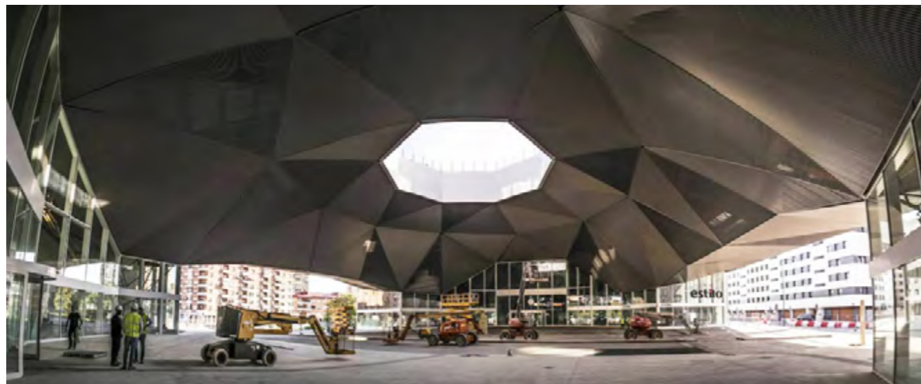
Cúpula vista desde el interior
