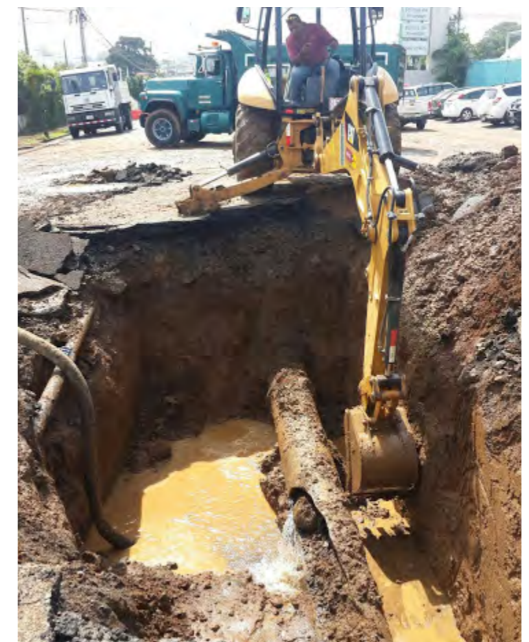
Obras de reparación en roturas con escapes en la vía pública
