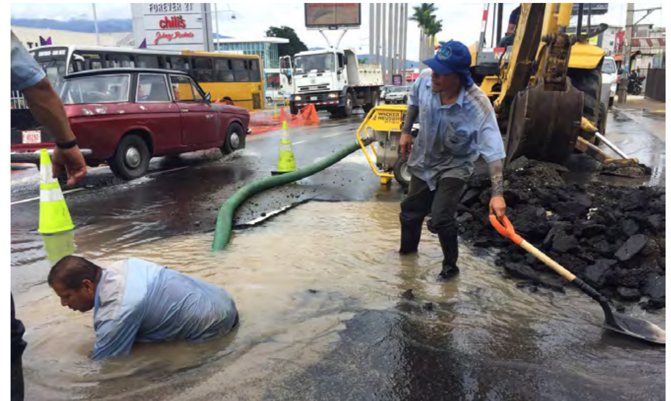
Obras de reparación en roturas con escapes en la vía pública
