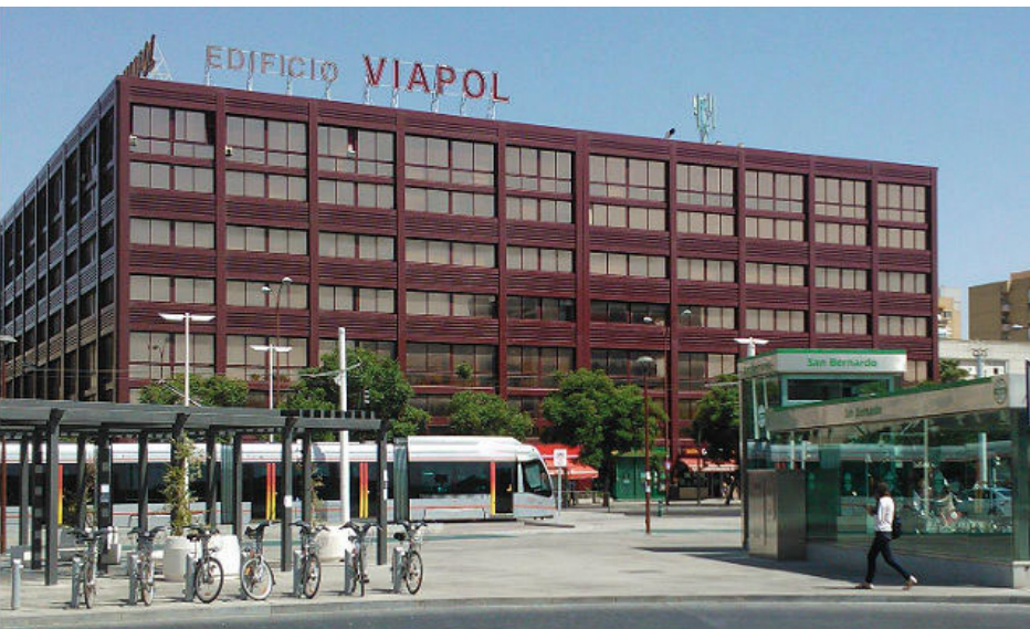
Vista general del Edificio Viapol
