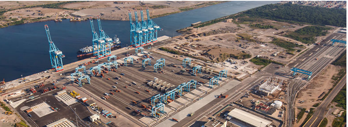
Terminal de Contenedores TECIL Lázaro Cárdenas
