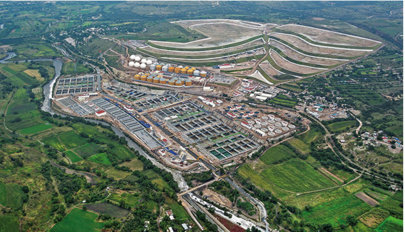
Planta de tratamiento de aguas de Atotonilco
