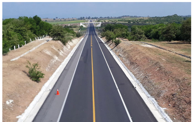
Tramo carretero del proyecto Ciudad Valles y Tamuín
