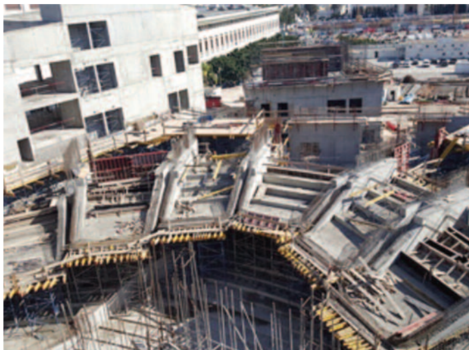
Gran Teatro – ejecución balcones (I)
