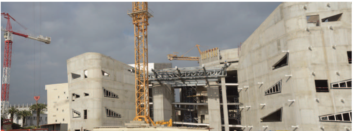
Vista principal del edificio
