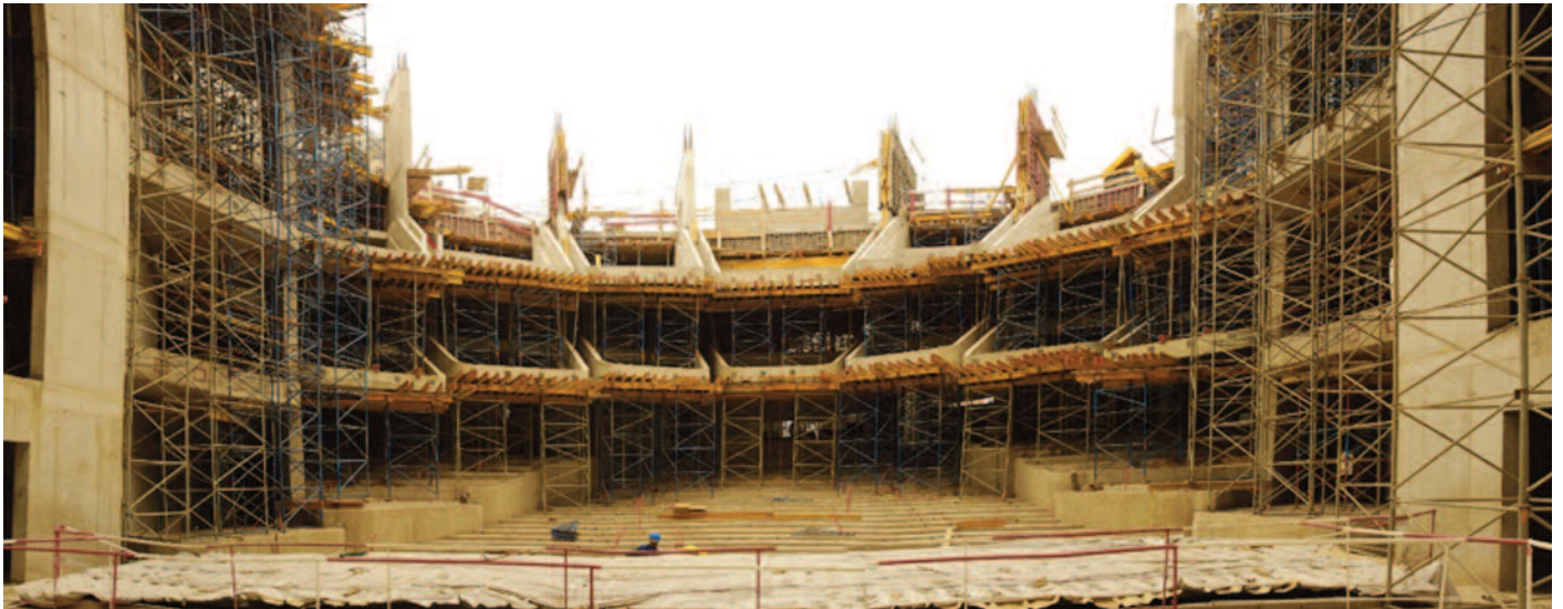
Gran Teatro – Construcción de los balcones
