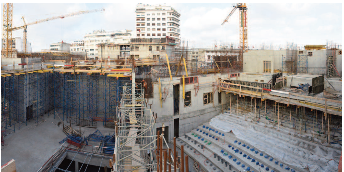
Pequeño Teatro – vista general durante la construcción
