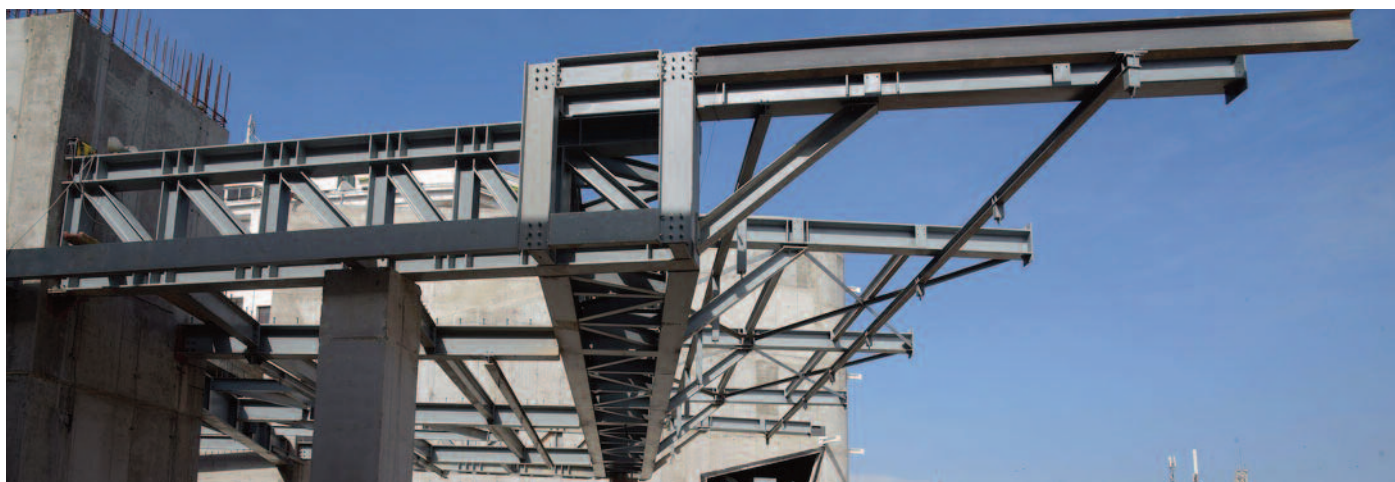
Pabellón de acceso – vista de la estructura de cubierta en construcción
