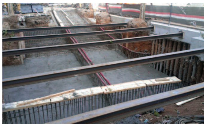
Detalle de la construcción de la rampa de acceso a un aparcamiento
