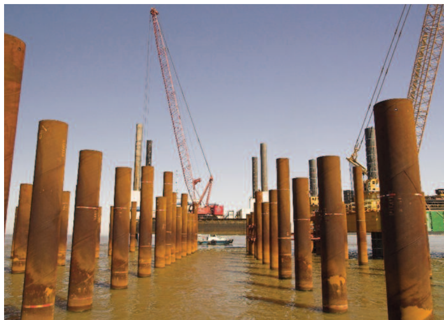
Las obras civiles de la terminal del Plata continúan su avance, venciendo paulatinamente diversas dificultades técnicas y operativas. Bajo la supervisión de TYPSA, se ha realizado la hincada de 69 pilotes de diámetro D800, a una distancia de unos 2 km de tierra
