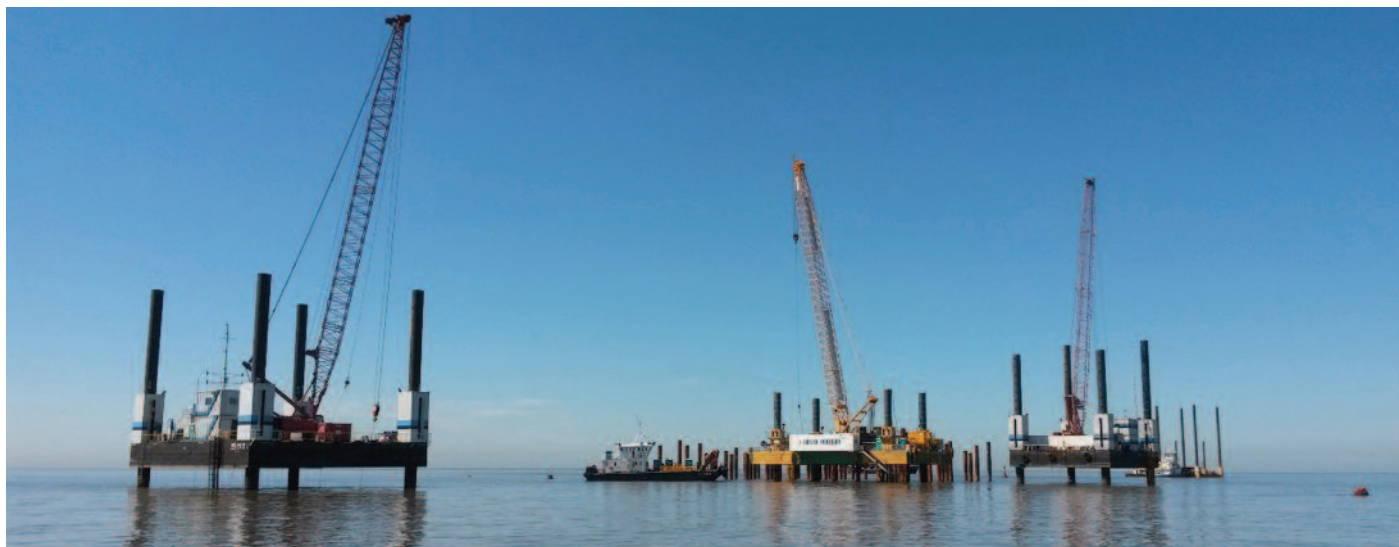
Las obras civiles de la terminal del Plata continúan su avance, venciendo paulatinamente diversas dificultades técnicas y operativas. Bajo la supervisión de TYPSA, se ha realizado la hincada de 69 pilotes de diámetro D800, a una distancia de unos 2 km de tierra
