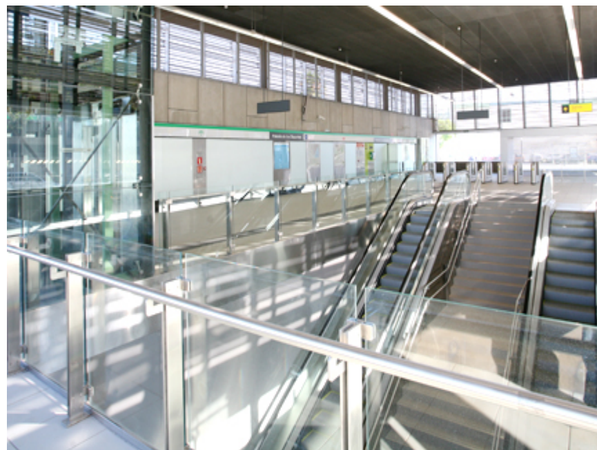
Acceso a la estación Palacio de los Deportes. Línea 2, Metro de Málaga
