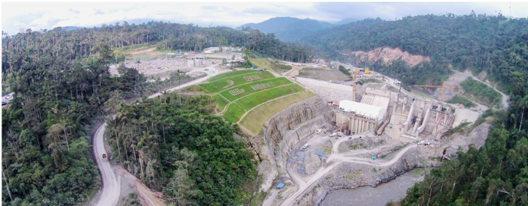
Fotografía de las obras de la presa hecha desde el mini-dron Departamento de Comunicación TYPESA | ©2014 Grupo TYPESA
