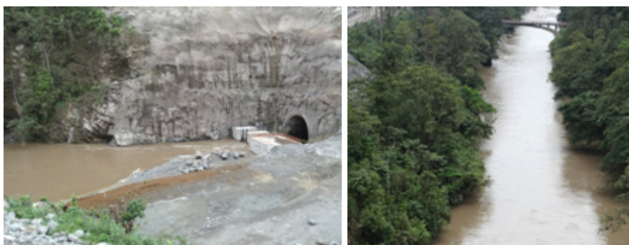
Situación del río antes de la avenida de principios de marzo de 2014
