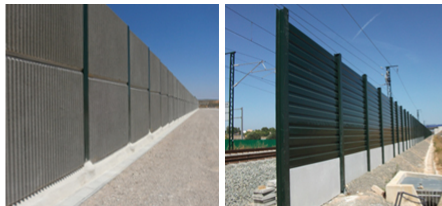
Pantallas de hormigón y metálica fonoabsorbentes
