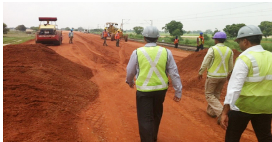
Vista a obra durante la ejecución de movimientos de tierra
