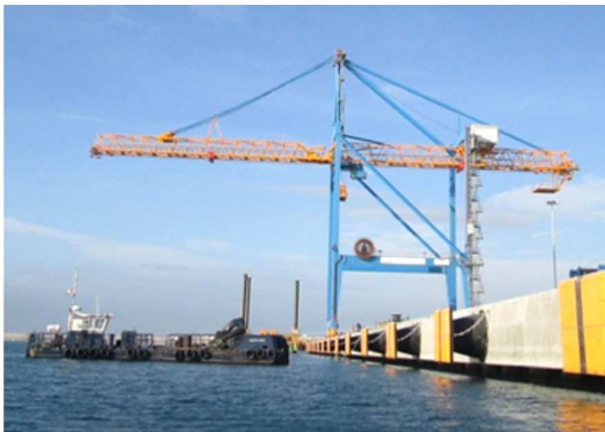
Vista de la grúa STS en su posición final
