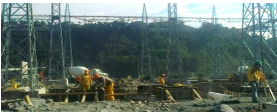
Llegada de los transformadores y trabajos en la subestación
