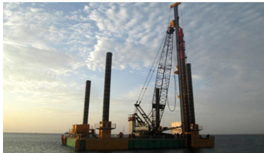
Hincado de pilote en posición E67
