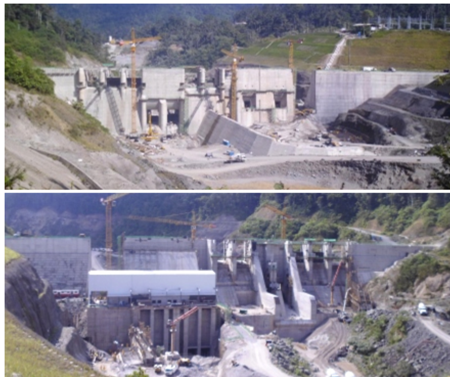
Vista desde aguas arriba y aguas abajo de la Presa de Manduriacu
