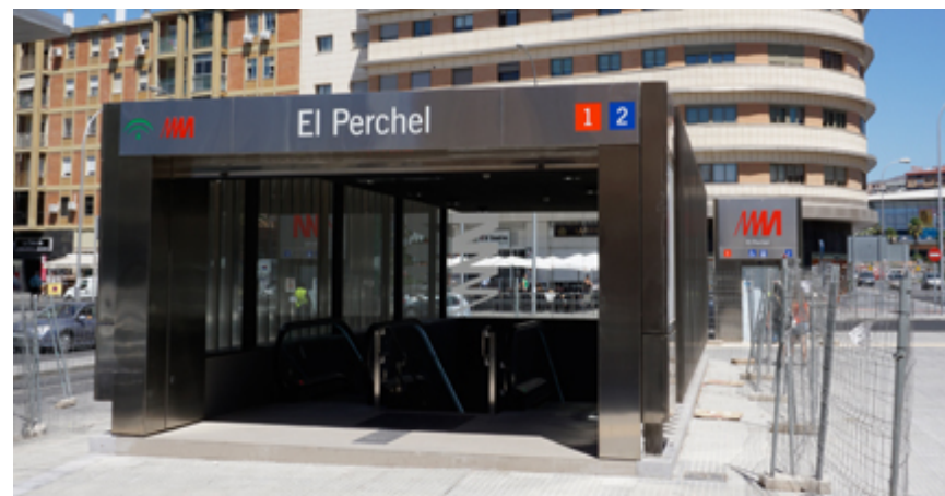
Acceso a la estación El Perchel. Líneas 1 y 2, Metro de Málaga
