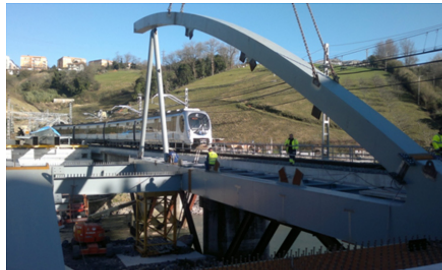
Montaje del semiarco derecho del puente del Urumea
