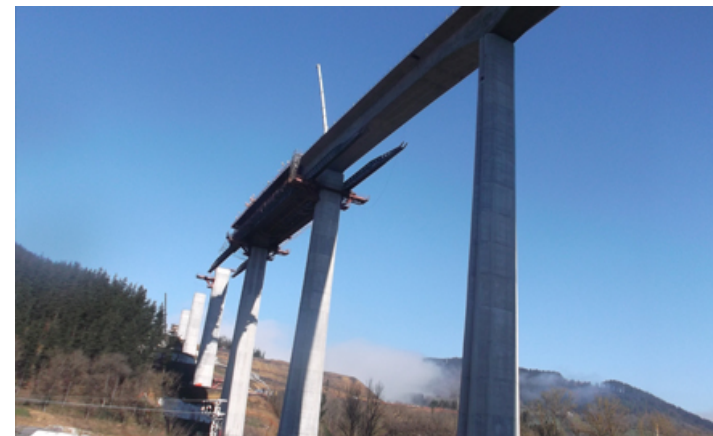
Retirada de encofrado. Vista general
