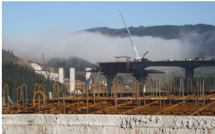
Parque de hormigonado de prelosas. Autocimbra al fondo
