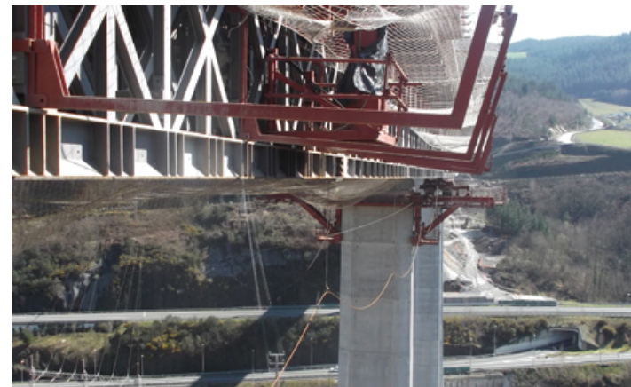
Apoyo de autocimbra
