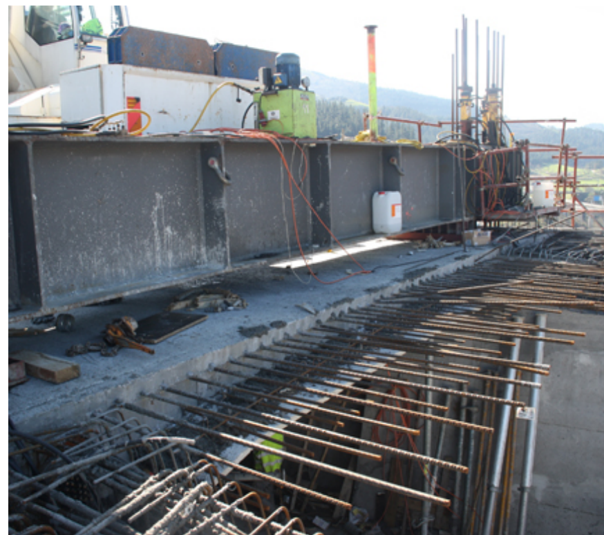
Vista desde interior de autocimbra y sobre ella de tensores de viga de cuelgue (barras GEWI tensoras en perímetro)
