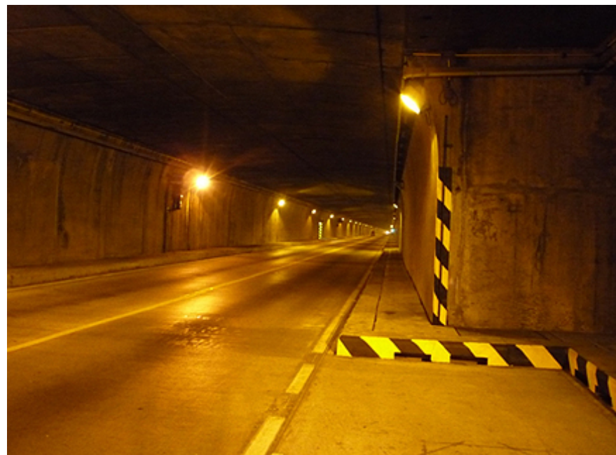
Túnel de Occidente, de 4.600 m. TYPESA ha realizado los diseños fase II de la duplicación de este túnel
