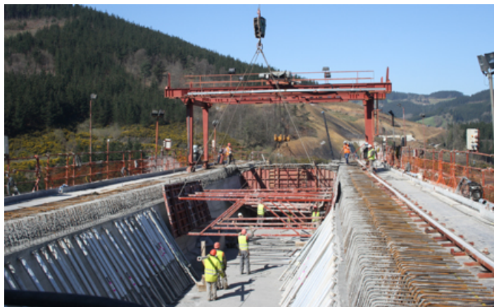
Retirada de encofrado de cajón para ejecución de losa superior
