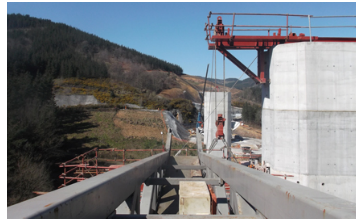
Preparación pila de apoyo
