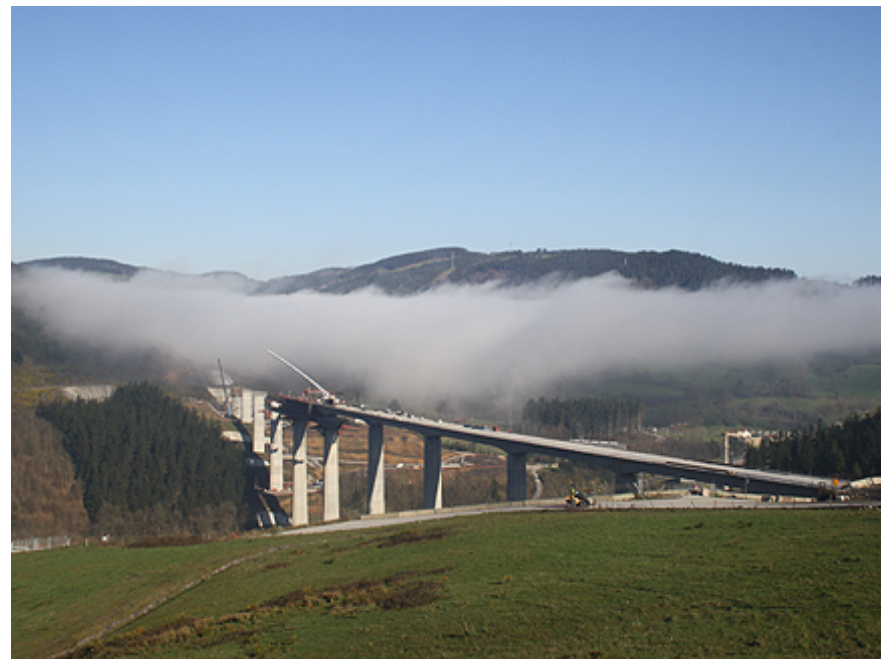
Viaducto sobre el río Deba. Fase de construcción
