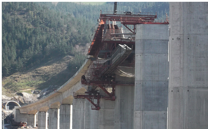
Detalle autocimbra y encofrado
