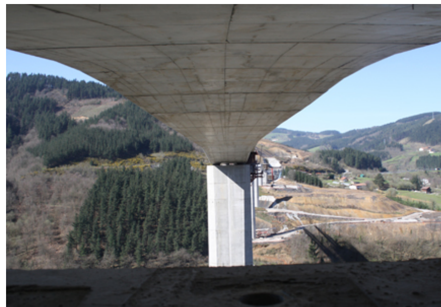
Viaducto desde paso de hombre de pila
