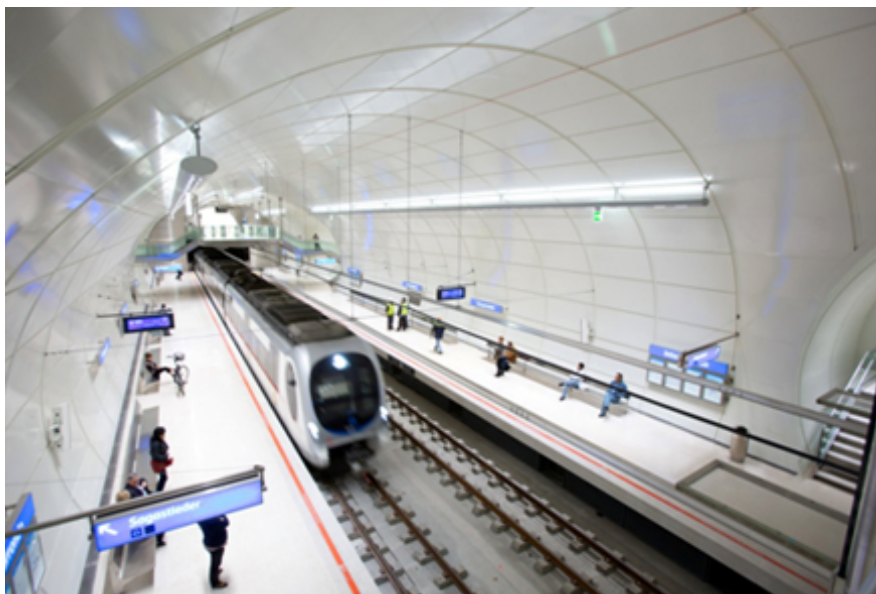
Nueva estación de Intxaurreondo, proyectada por TYP SA
