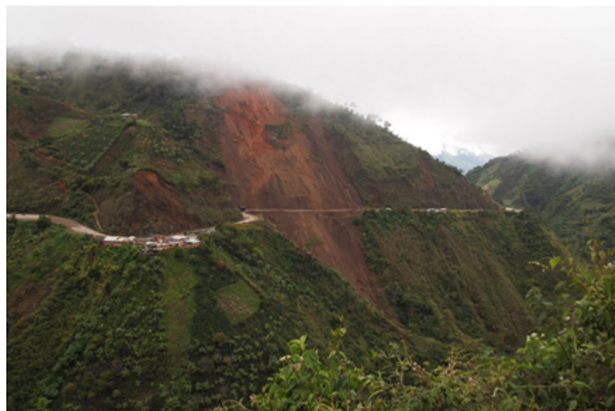
Gran deslizamiento que destruyó completamente la carretera cerca del Alto del Toyo y causó 20 víctimas en septiembre de 2010
