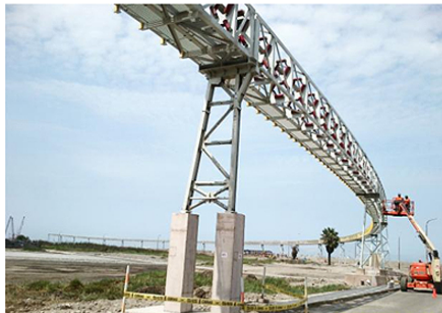
Construcción de la galería de la faja tubular
