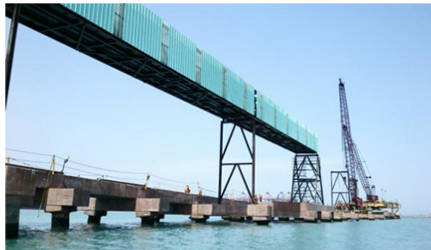
Galería cerrada paralela al puente de acceso, para la faja "tripper" extendida. Al fondo, el "Cantitravel" en la construcción del muelle
