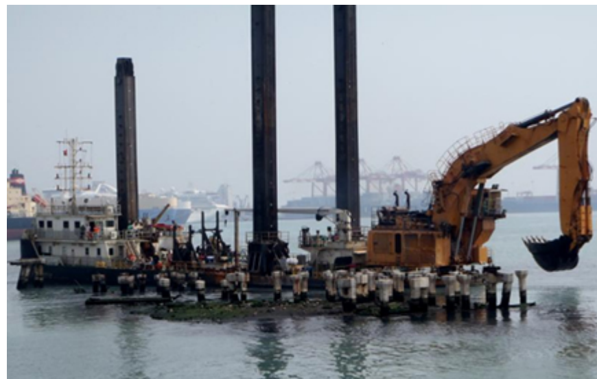
Draga "Il Principe", en trabajos de demolición de un antiguo varadero
