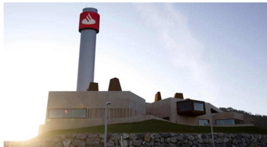
Centro de Proceso de datos para el Banco Santander, Cantabria
