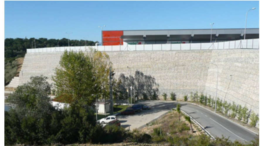
Panorámica del muro de gaviones del Parque comercial de Santarém
