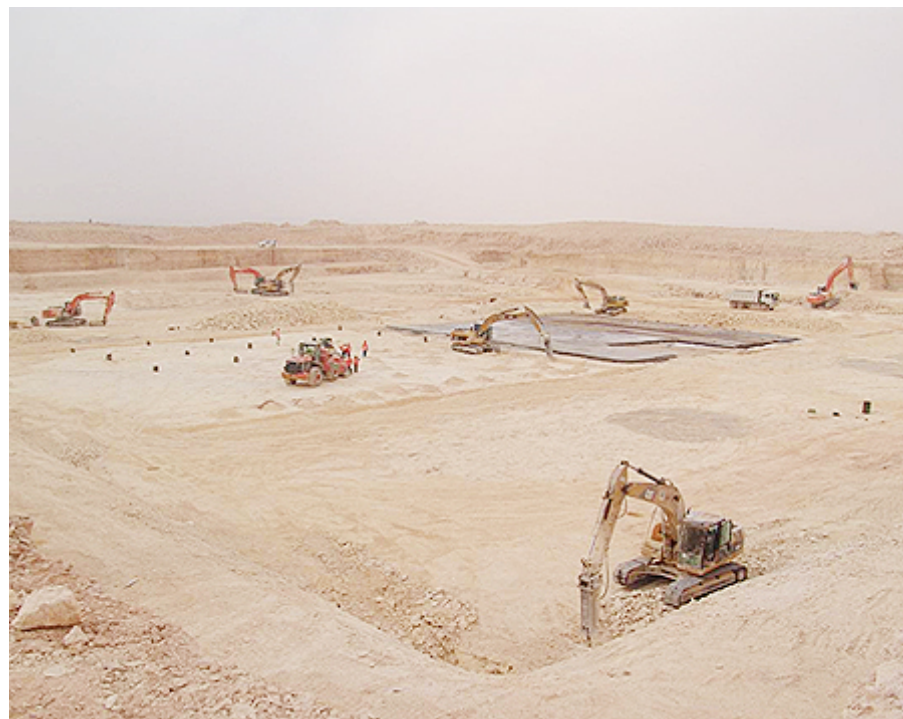
Excavación y hormigón de limpieza en el depósito de Salbouk (Contrato 4)
