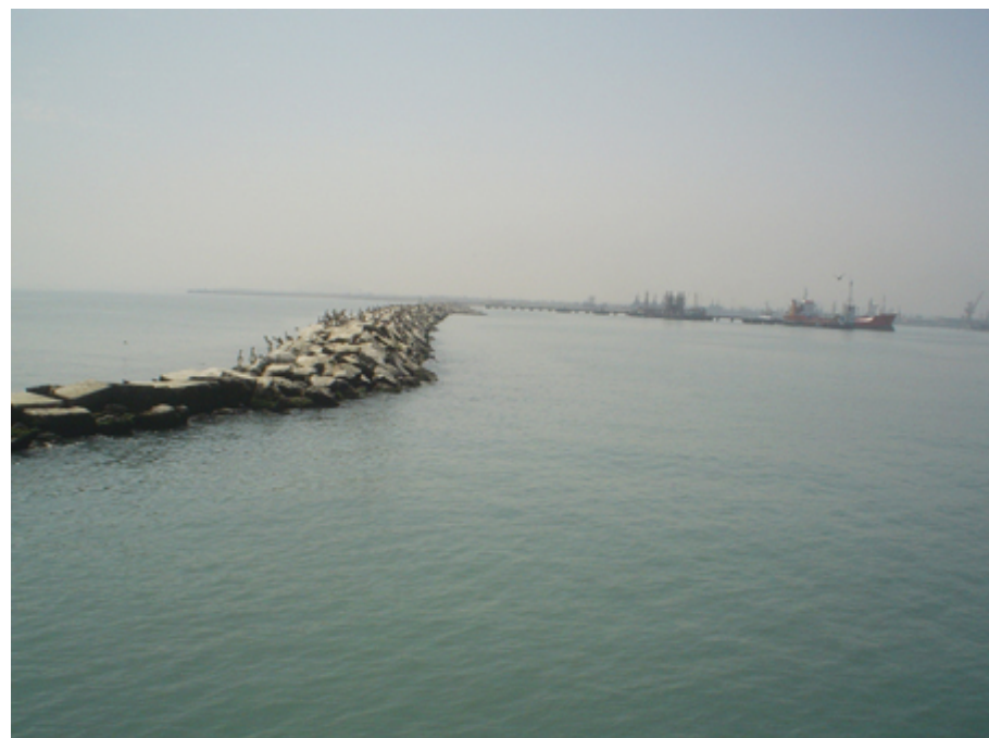
Rompeolas norte, junto al que se construirá el nuevo terminal de concentrado de minerales. Al fondo aparece el muelle nº7
