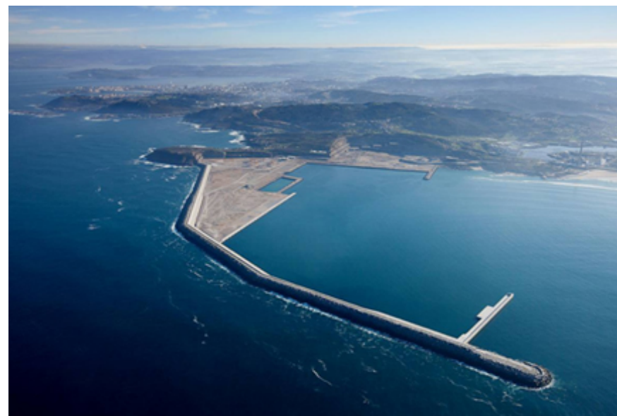
Vista aérea del nuevo puerto (enero 2012)
