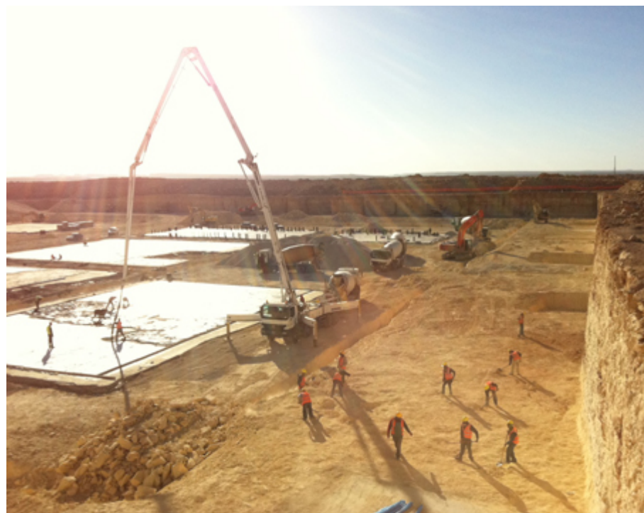
Excavación, hormigón de limpieza e impermeabilización en el depósito de Salbouk (Contrato 4)
