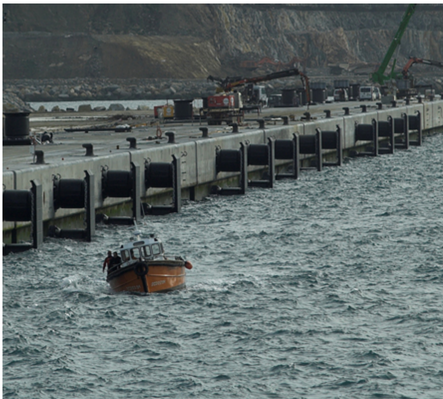
Trabajos de colocación de defensas (Diciembre 2011)
