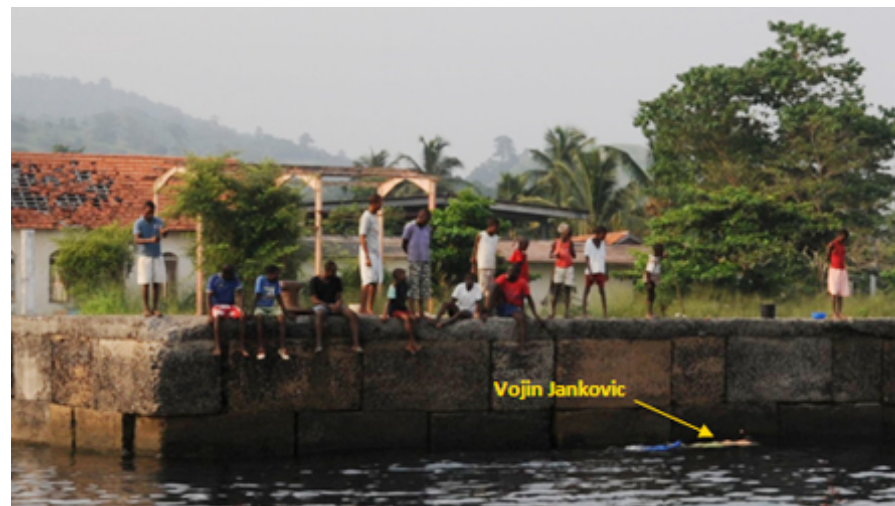
Inspección de uno de los muelles a rehabilitar
