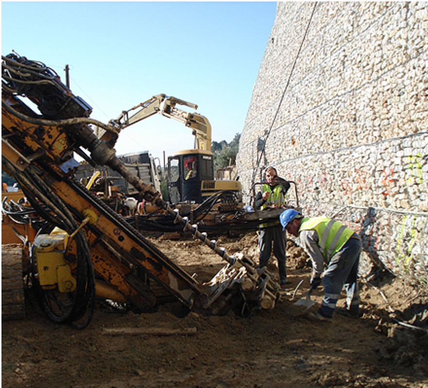
Ejecución de micropilote y trabajos de excavación simultáneos
