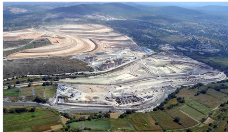
Obras de la Estación Depuradora de Atotonilco, México
