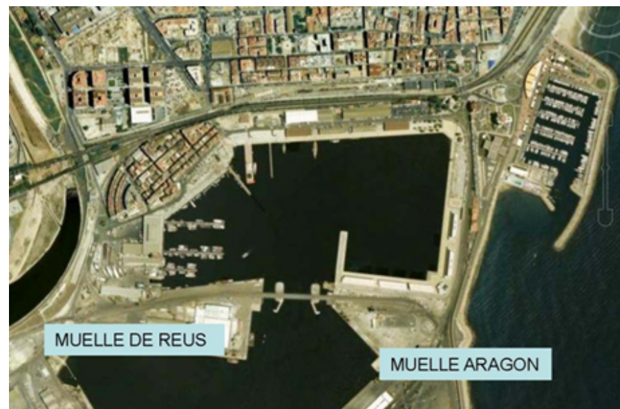
Localización del Nuevo Puente móvil de FFCC. En paralelo al de carretera ya existente
