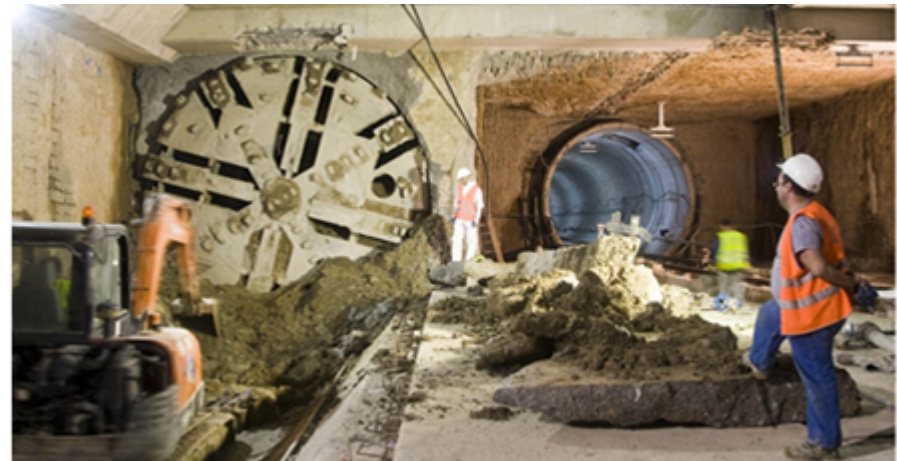
Segunda llegada de la tuneladora a la estación de San Bernardo
