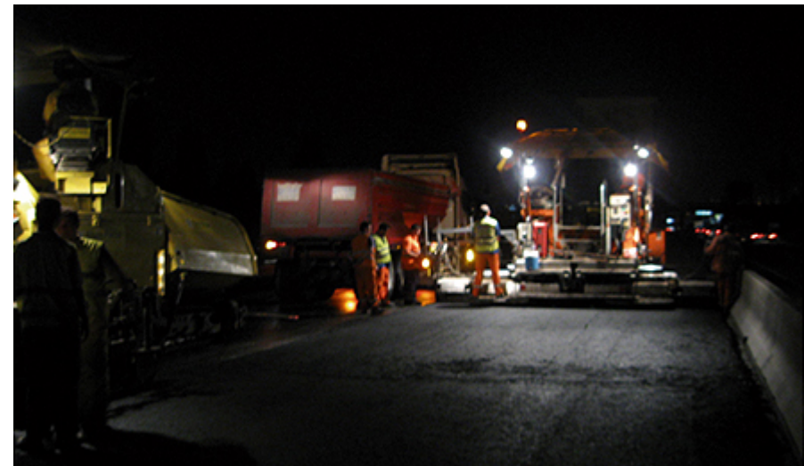
Extendido de aglomerado en las operaciones de refuerzo y rehabilitación del firme en la autovía A-2
