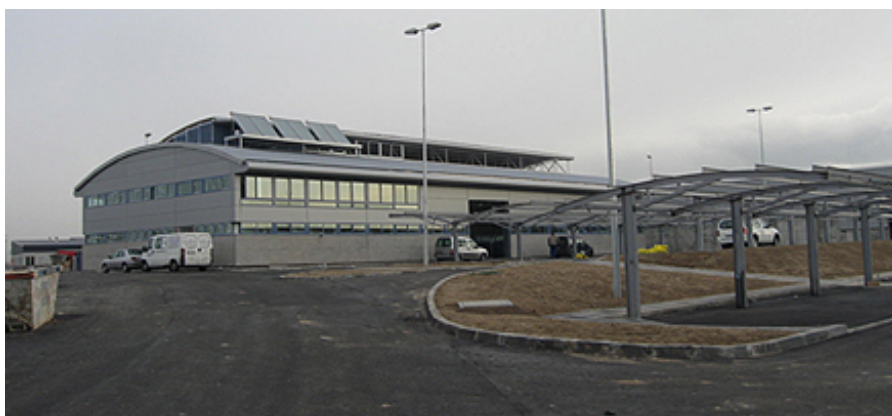
Nueva nave de conservación y zona de aparcamientos en el Centro de Control y Explotación en Alcalá de Henares
