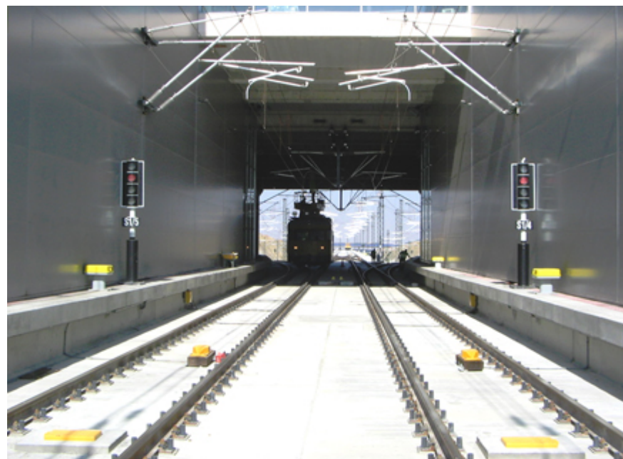
Balizas y señales de salida en la estación de Segovia
