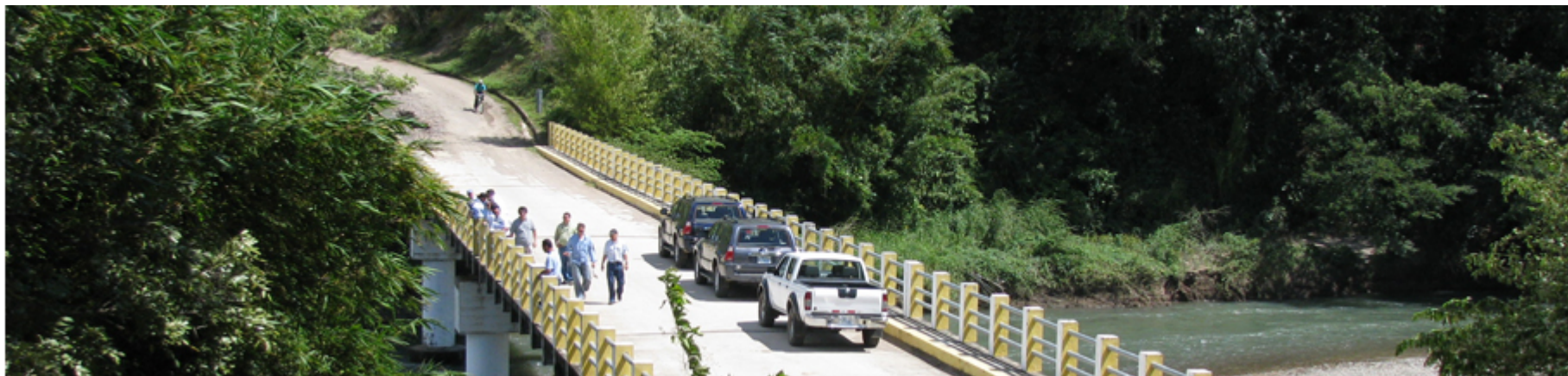
Vista de la carretera que se rehabilitará
