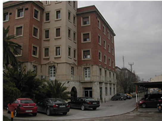
Edificio donde se encuentran las oficinas de obra
