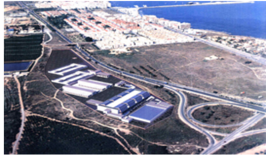
Planta desaladora de Torrevieja, Alicante
