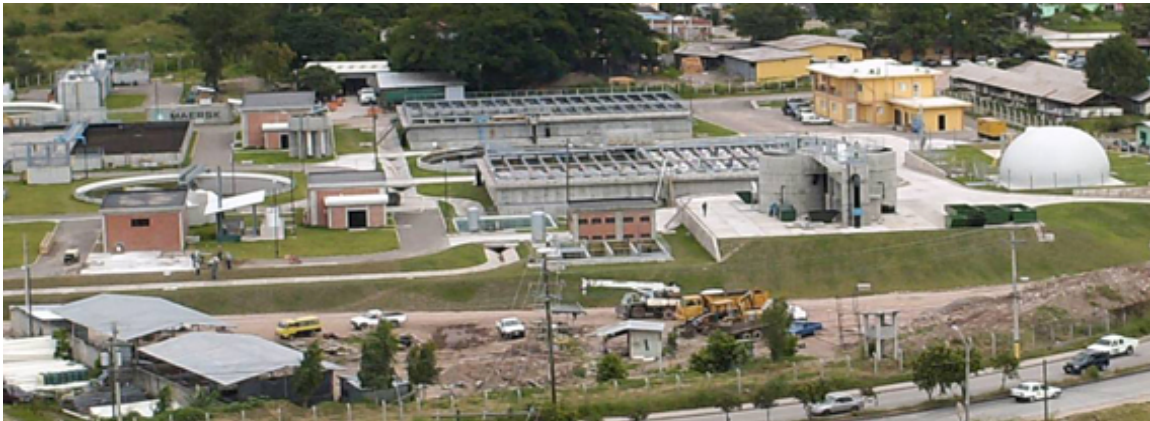
Vista general de la planta
