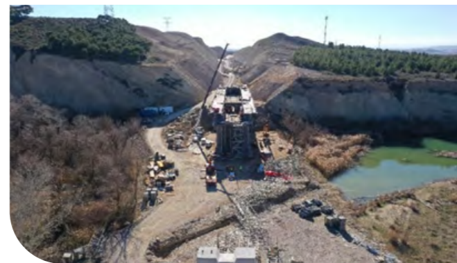
Viaducto en ejecución en el Río Aragón
