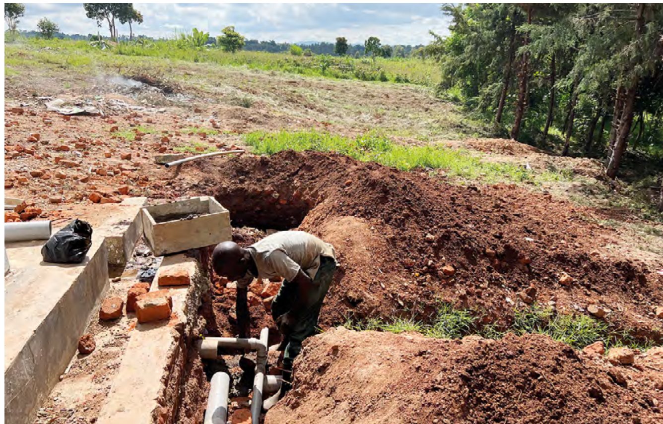
Obras de abastecimiento de agua potable en UNILAC
