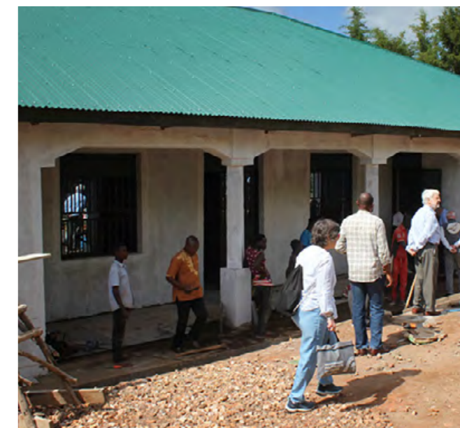
Visita a las obras de la residencia para profesores en UNILAC
