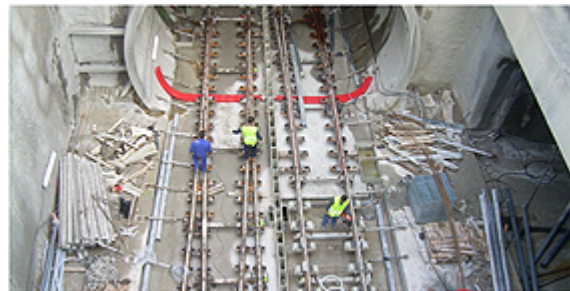
Proceso de montaje de vía en el telescopio de unión entre la línea 3 y las Cocheras. TYP SA ha realizado la asistencia técnica a la dirección de dichas obras
