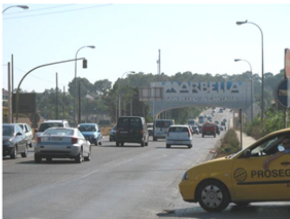
El ferrocarril discurre bajo la autovía A-7 en este tramo situado en San Pedro de Alcántara
