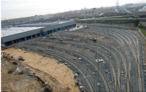
Vista aérea de la playa de vías de las Cocheras y Talleres de línea 3. Al fondo se aprecia la M-45
