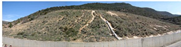
Vertedero que se va a dismantelar
