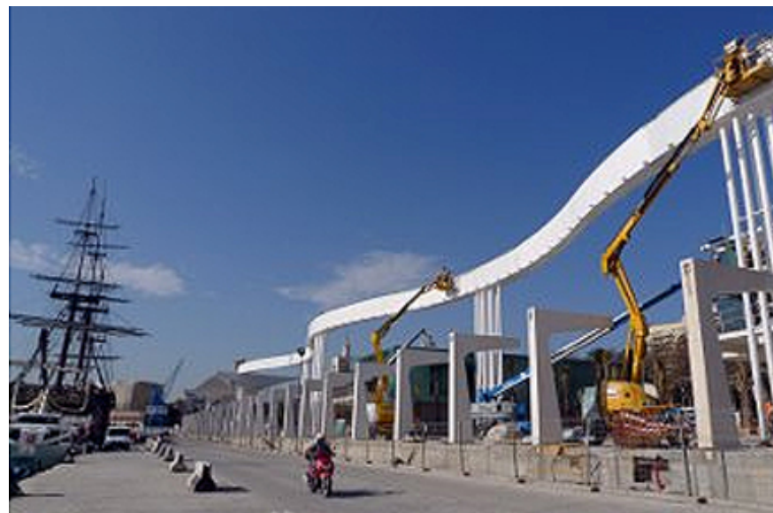
La pérgola gigante del puerto va tomando forma
