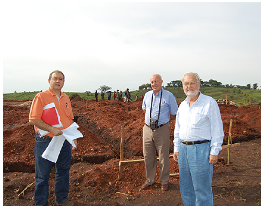
Obras de la Universidad de Mahagi
