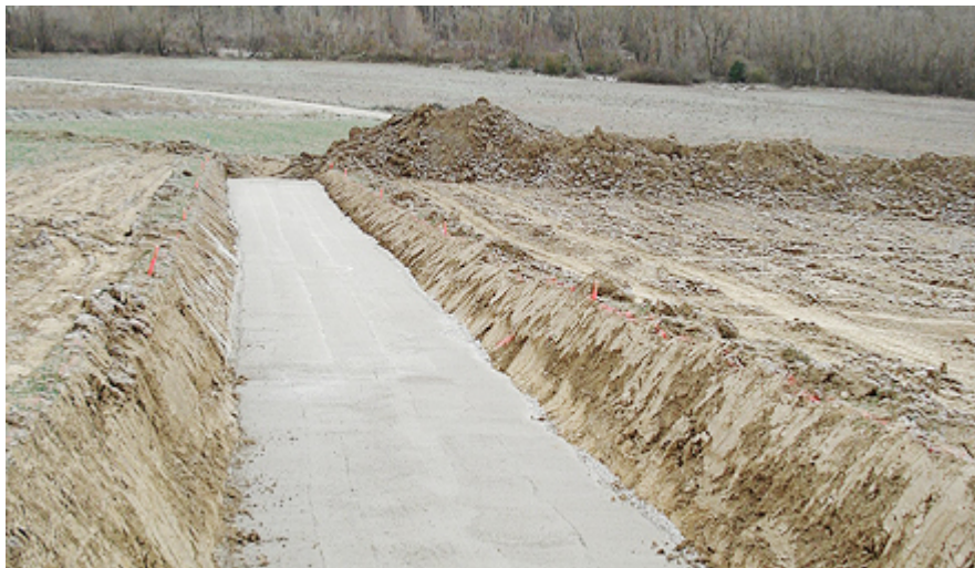
Hormigón de limpieza en la ODT 4.8
