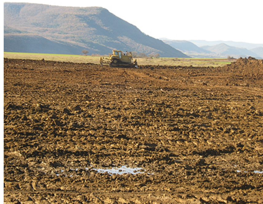
Desbroce con buldozer en la traza de la futura autovía
