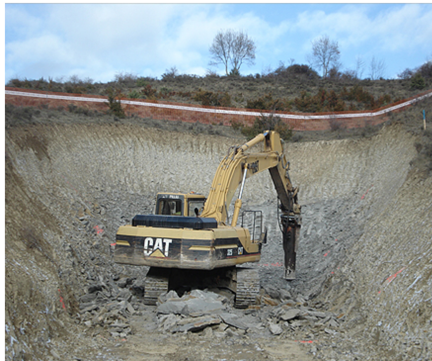
Excavación en roca en un extremo de la ODT 4.8
