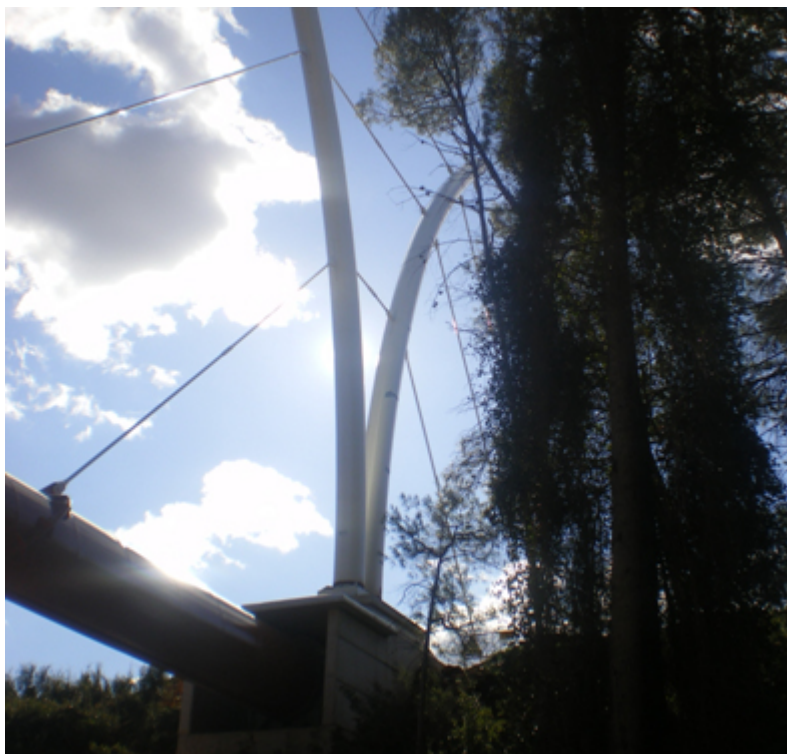
Detalle de dos de los pilonos de la estructura
