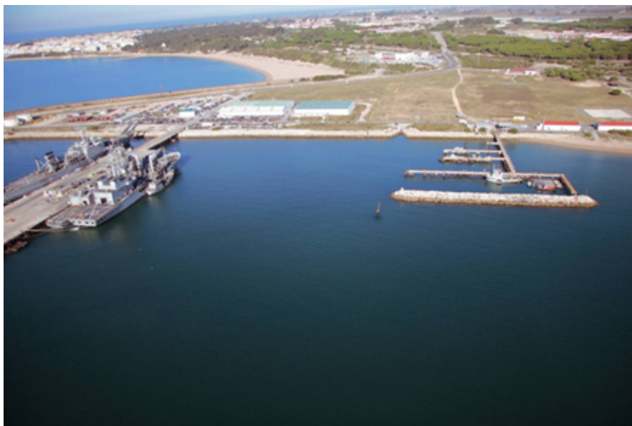
Base Naval de Rota en diciembre de 2007 (zona del futuro muelle nº 4)
