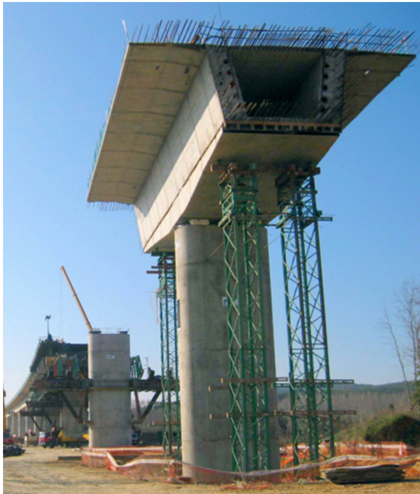
Construcción del tablero en pilas P11, P12 y P13 (fuente: Mecanotubo)
