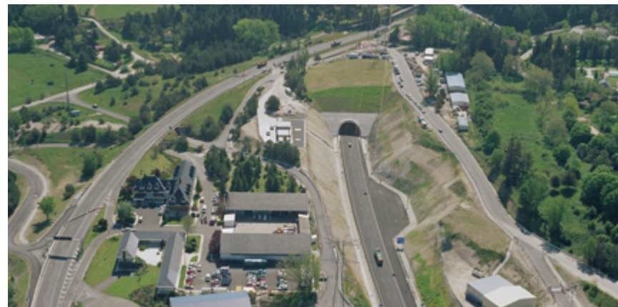
Boca Norte del túnel
