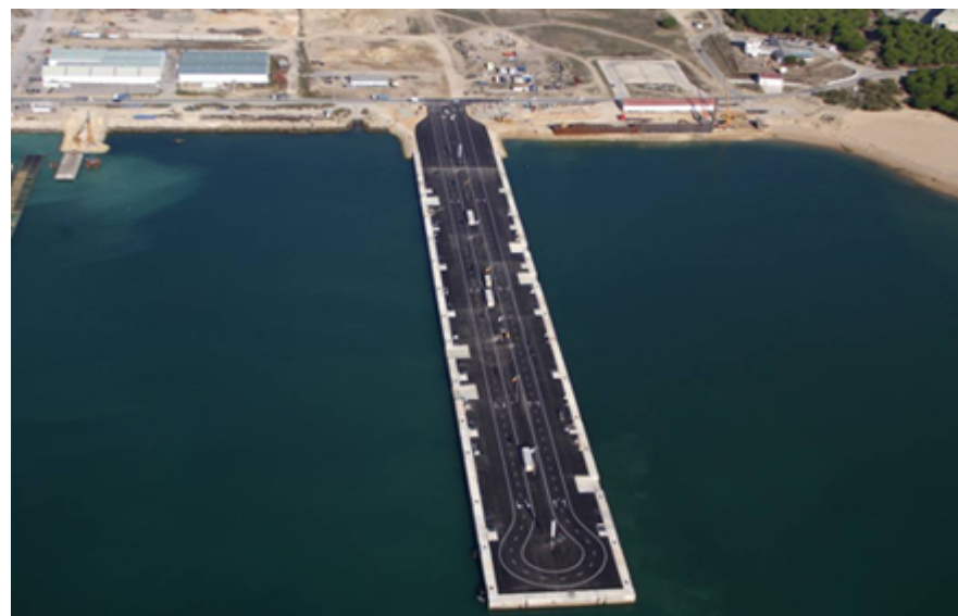
Base Naval de Rota actualmente (nuevo muelle nº 4)
