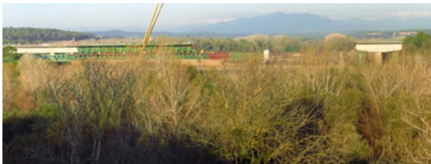
Cimbras empleadas en la construcción del viaducto (fuente: Mecanotubo)
