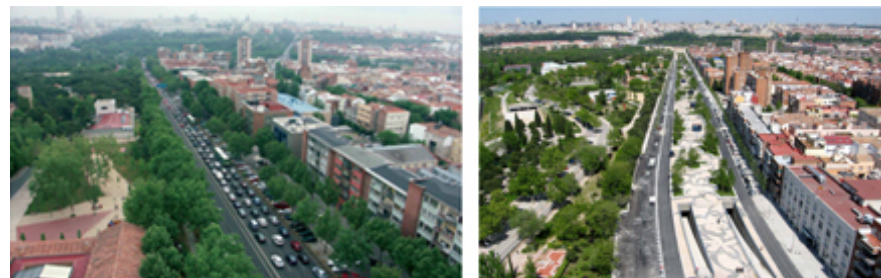
Imagen de la Avda. de Portugal antes y después del soterramiento de la N-V
