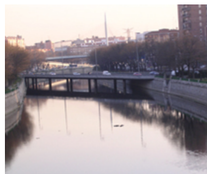
Antes y después del Puente Oblicuo
