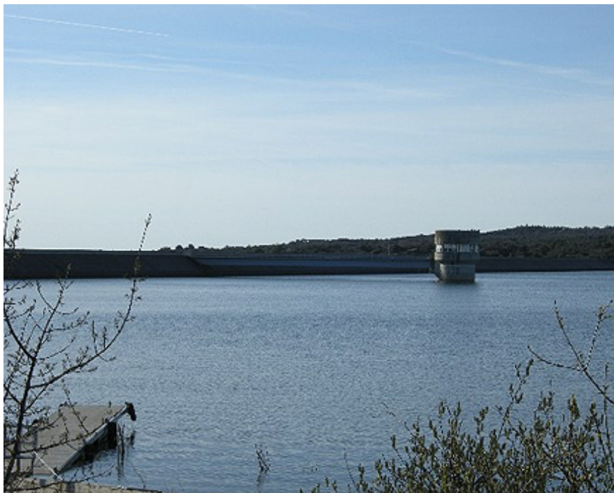
Nueva Obra de Toma en el embalse de Valmayor
