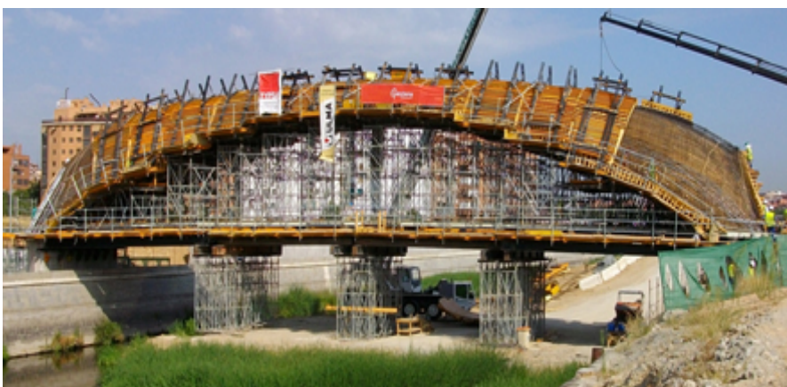
Montaje del encofrado superior de la pasarela cáscara
