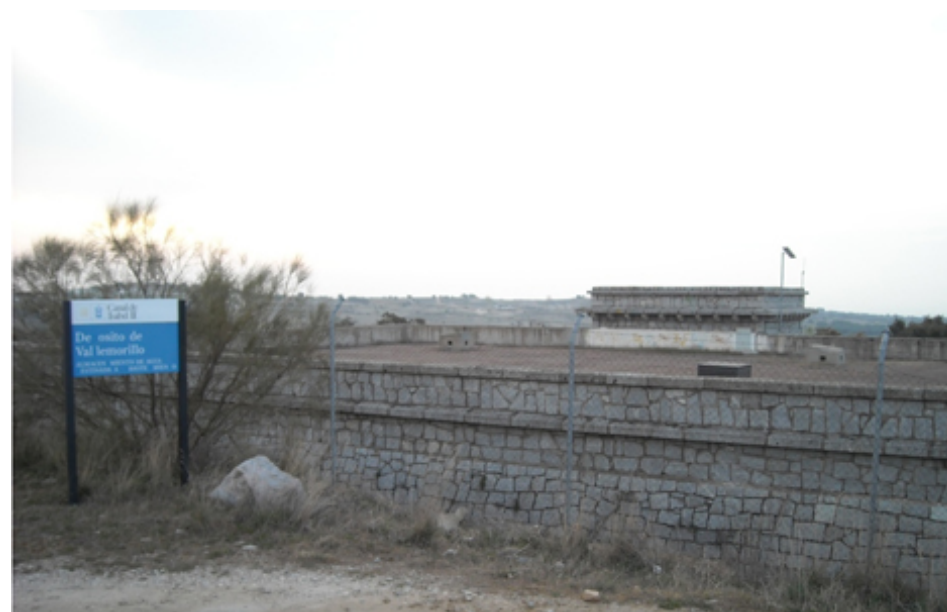
Depósito de Valdemorillo
