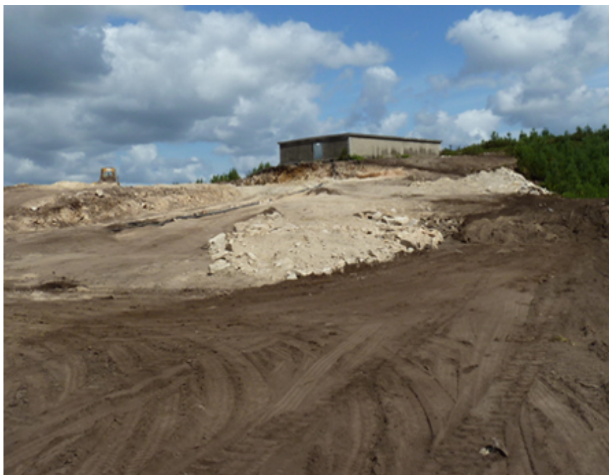
Vista de la rampa de acceso a la llegada, con casi un 6% de pendiente
