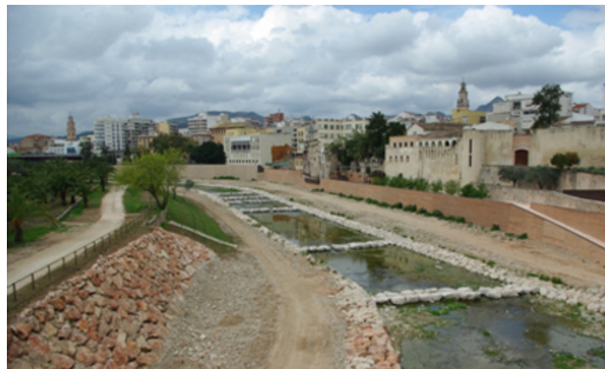
Vista general de un tramo de la obra
