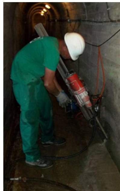
Ejecución de red piezométrica y cámara de video utilizada para grabar el contacto presa-cimiento en Villar de Plasencia (Cáceres)
