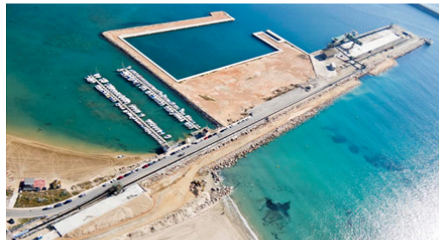
Ejecución de la ampliación del dique de Poniente. Febrero de 2012.
