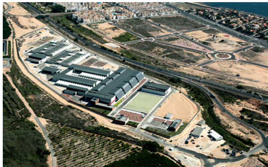
Foto aérea de la desaladora de Torrevieja. Diciembre de 2011
