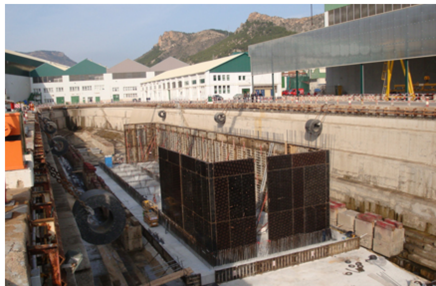
Construcción del cajón en el dique seco de Navantia. Marzo de 2012
