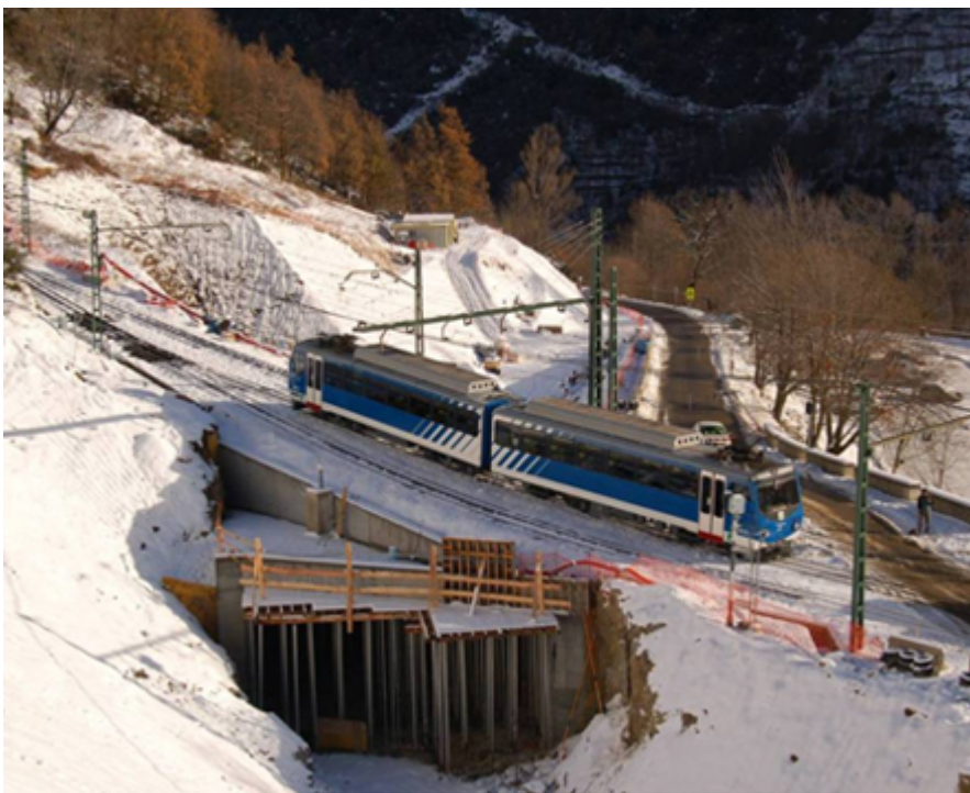
Prolongación paso inferior lado sud en ejecución
