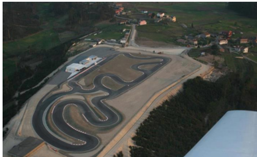
Vista aérea de las obras
