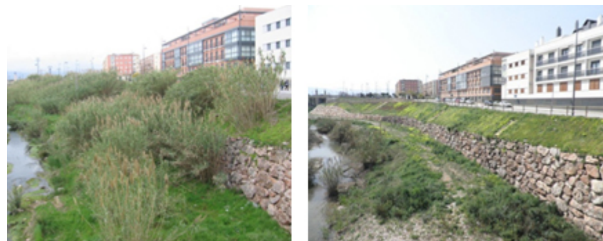
Imágenes del estado previo a las obras y el estado actual
