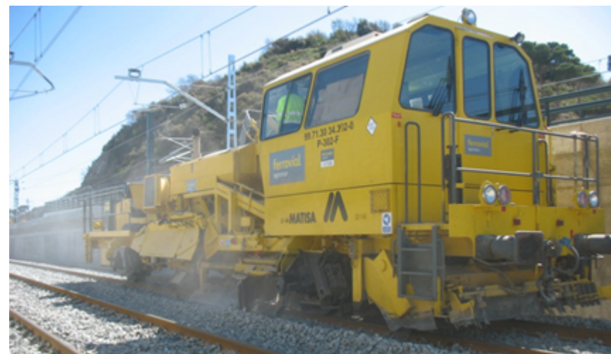
Perfiladora sobre el viaducto del Congost IB
