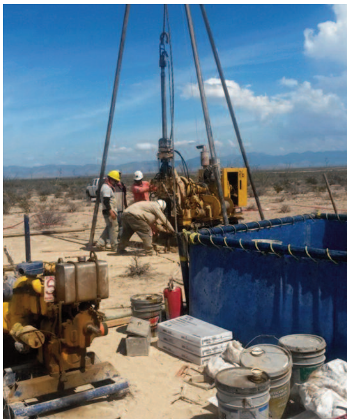
Ejecución de sondeos de investigación geotécnica
