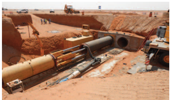
Detalle de microtúnel
