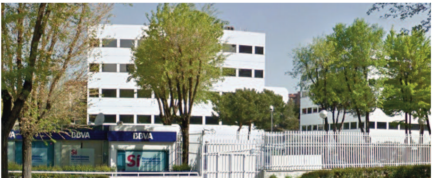
Edificio de oficinas y CPD Espejo, Madrid
