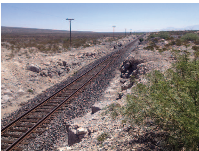
Línea de ferrocarril existente a cruzar mediante la ejecución de dos puentes
