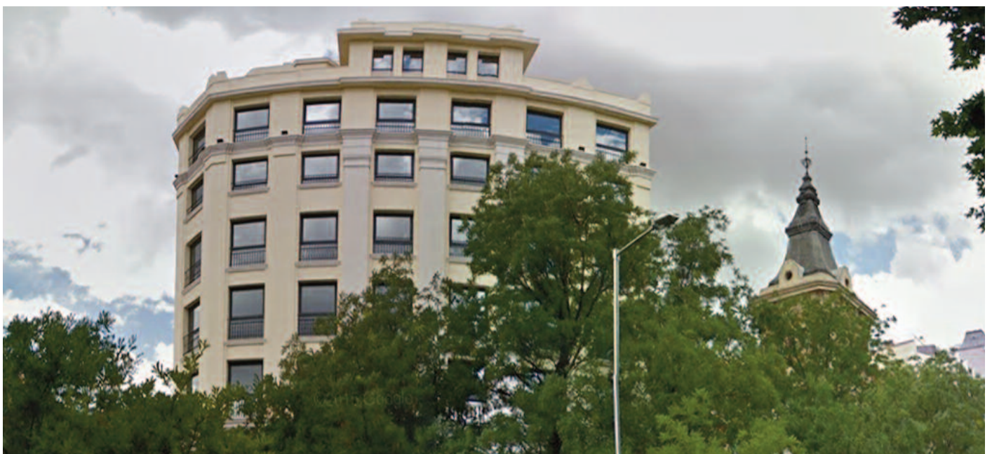
Edificio colindante al Palacio de la Condesa de Guevara, actual área de auditoría del Banco BBVA, Madrid
