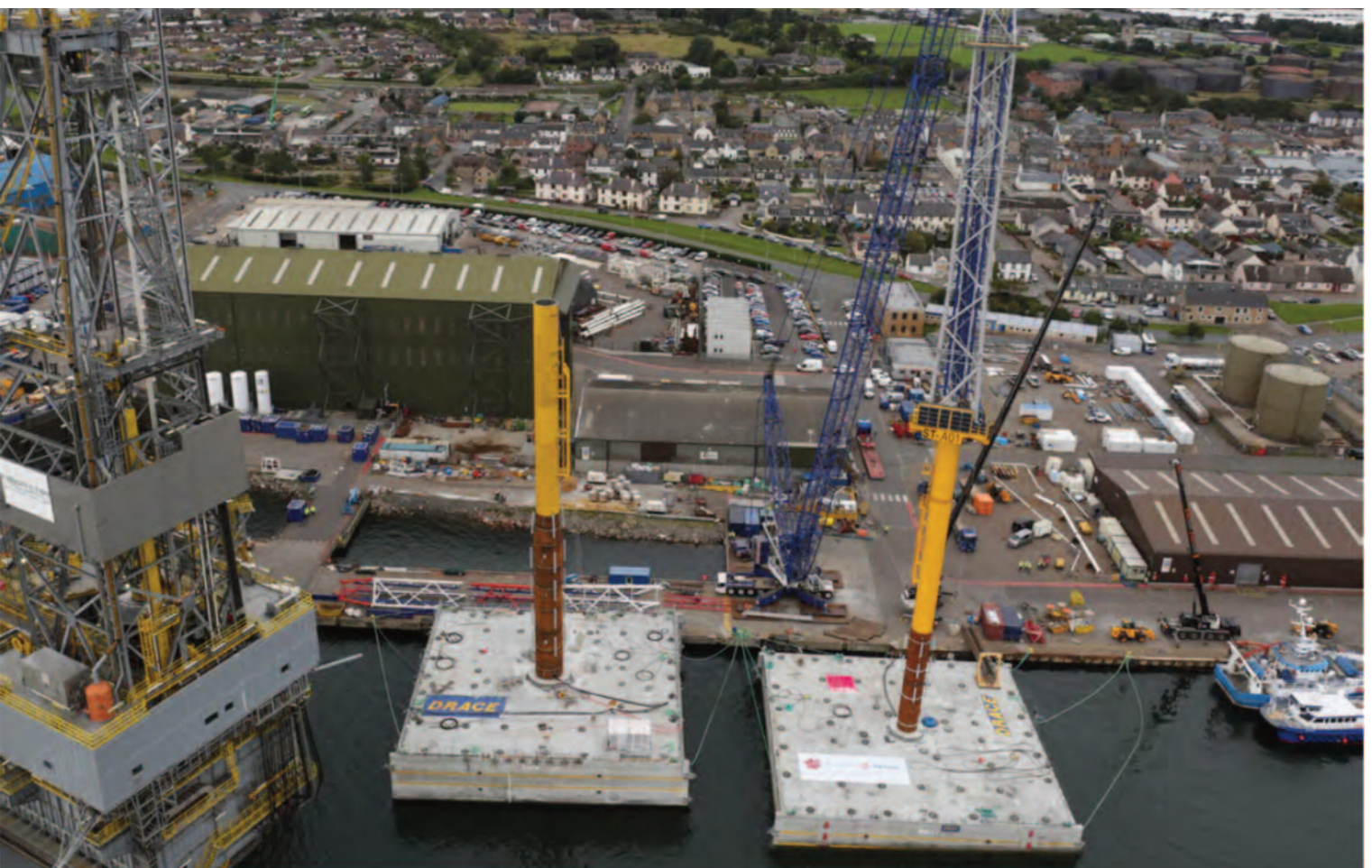
Montaje de estructuras sobre los cajones en el puerto de Invergordon (Escocia, UK)
