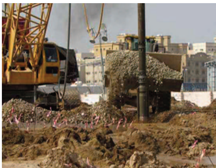
Tratamiento del terreno y cimentación de uno de los tanques
