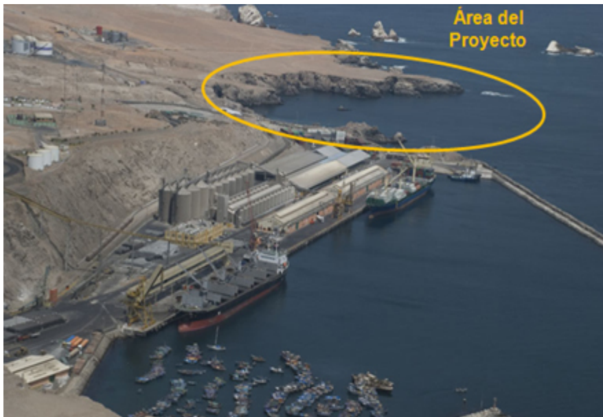
Actual puerto de Matarani y área del proyecto del futuro sistema de recepción, almacenamiento y embarque de minerales y amarradero "F" en la Bahía ISLAY
