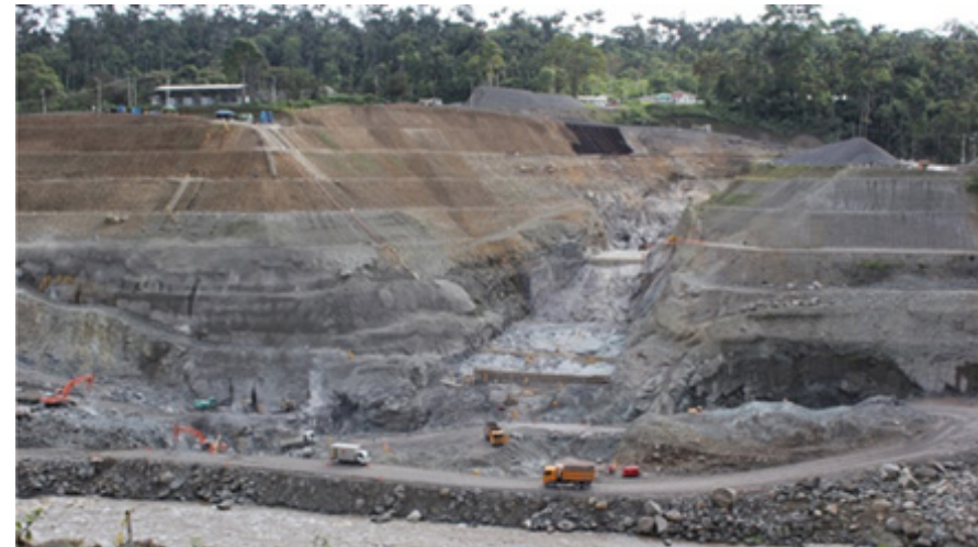
Vista general de los trabajos en la margen derecha
