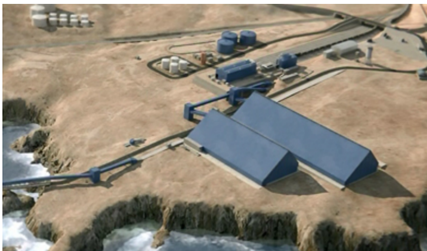
Instalaciones del lado tierra
