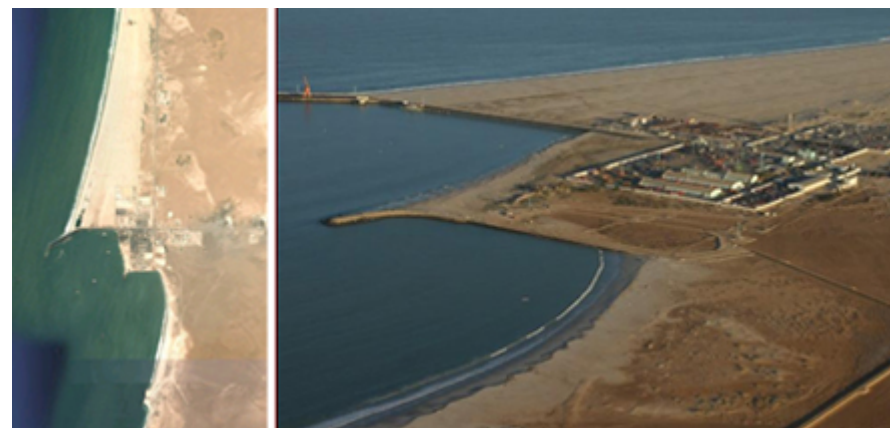
Puerto de Nouakchott. Modificación del litoral por el efecto barrera del dique
