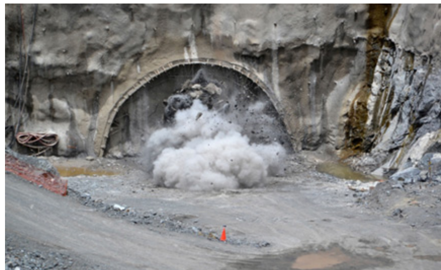
Inicio excavación del túnel en fase de avance
