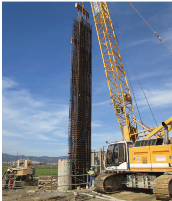
Jaula de armado de batache de pantalla en zona de rampa de emboquille
