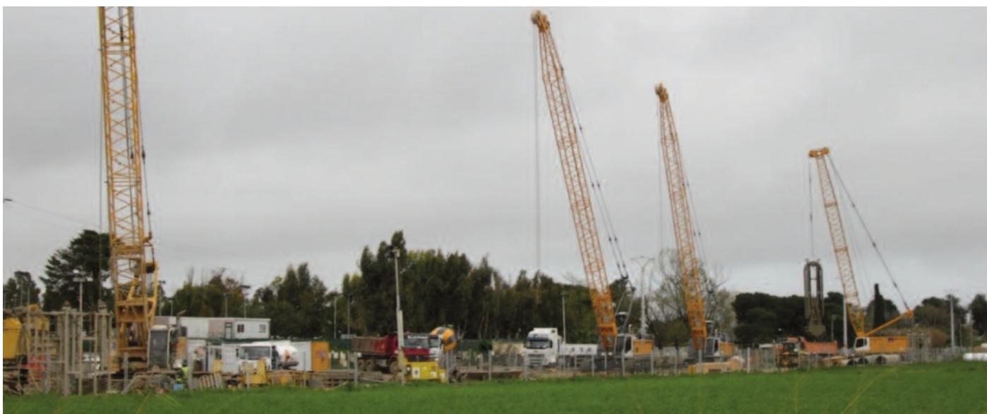
Trabajos de ejecución de bataches de pantalla en rampa de emboquille
