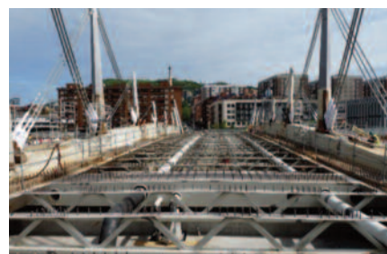
Vista de las riostras y celosías transversalmente dispuestas a lo largo del puente
