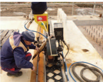
Soldadura semiautomática longitudinal superior del tablero mediante carro de arco sumergido
