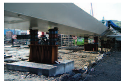
apeos provisionales sobre los que se apoyaron las distintas piezas metálicas durante las fases de ejecución
