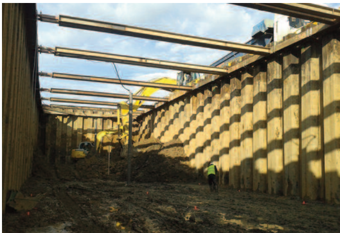
Excavación en recinto tablestacado en la zona de rampa de emboquille
