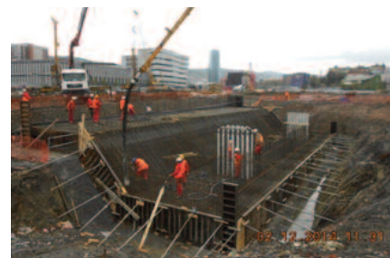
Hormigonado del estribo Zorrotzaurre y colocación de las barras de pretensado tipo Macalloy
