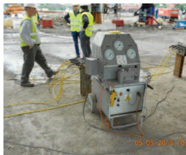
Central hidráulica utilizada para el tesado de los tirantes y levantamiento del tablero
