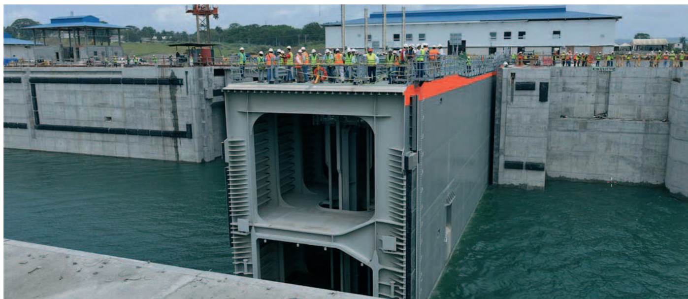
Puesta en servicio de las compuertas de las esclusas
