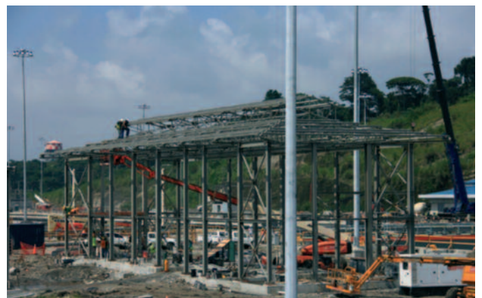
Edificio en construcción
