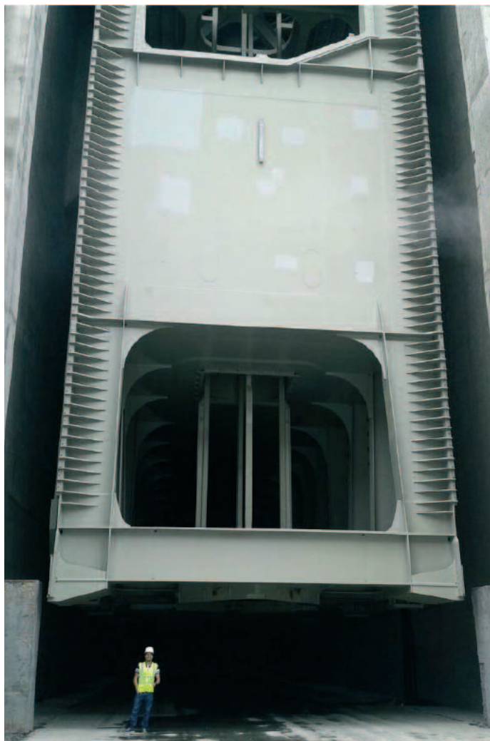
Estructura de compuerta durante su instalación in-situ
