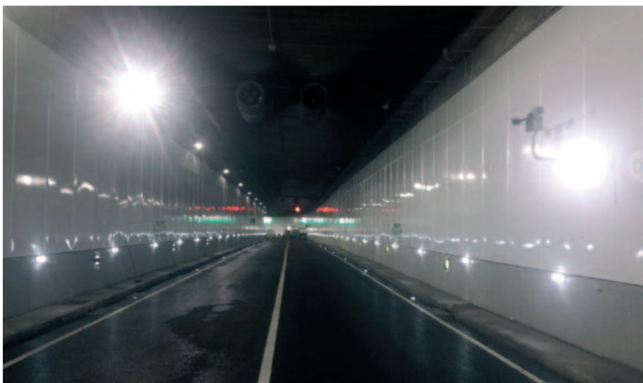
Túnel de El Parrote en estado final
