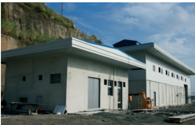
Otros edificios de la Ampliación
