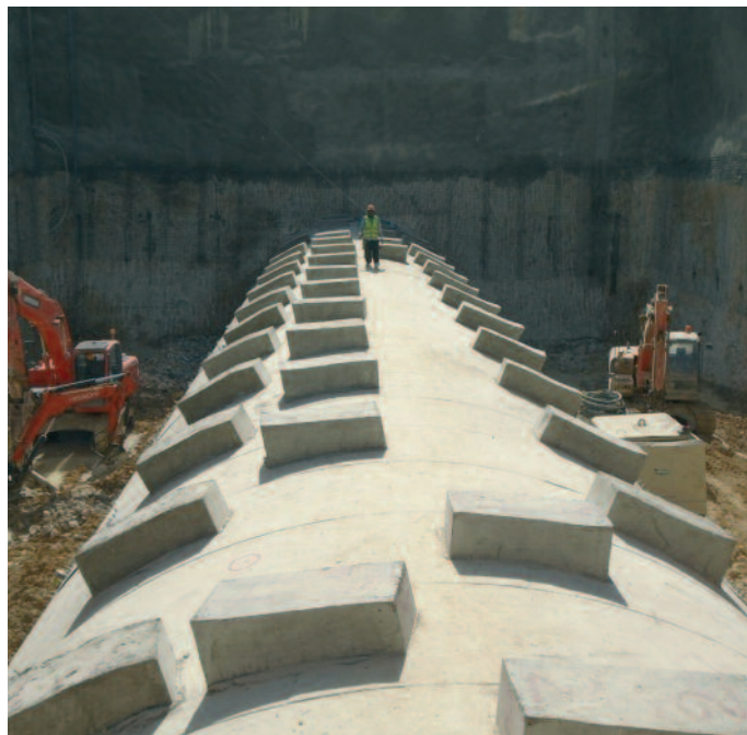
Vista de los anillos de dovelas al nivel de clave
