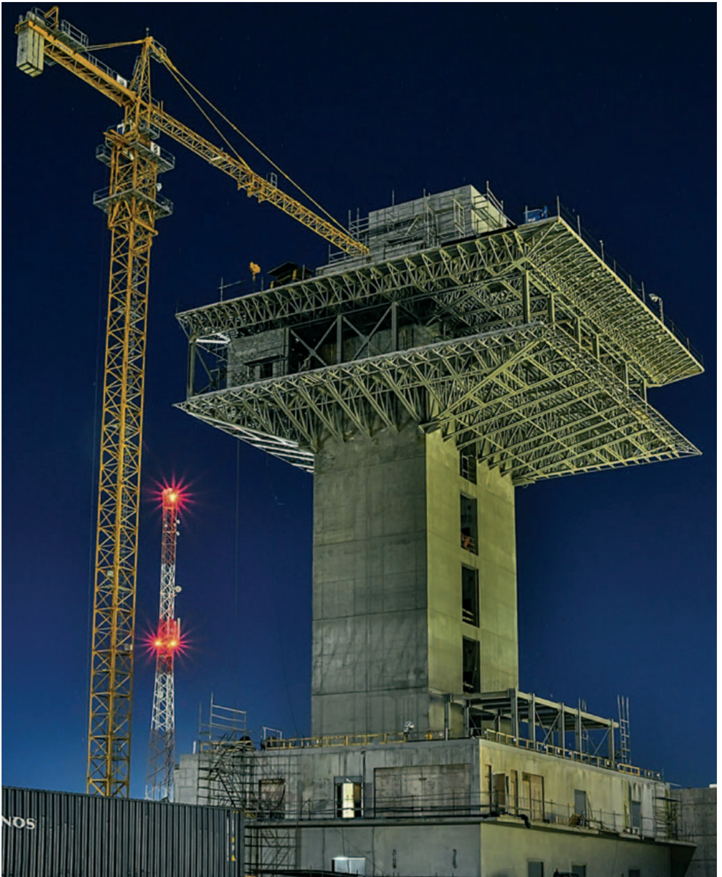
Vista nocturna del edificio de control del lado Pacífico con la estructura en fase de finalización
