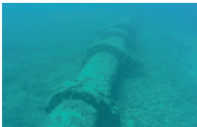
Tramo de emisario apoyado y bien lastrado
