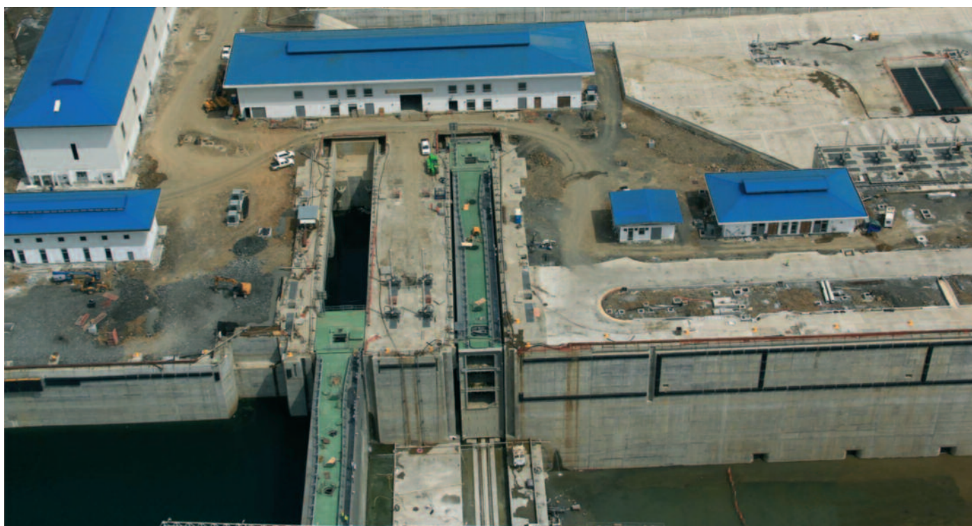
Edificios en el entorno de las compuertas de la nueva esclusa
