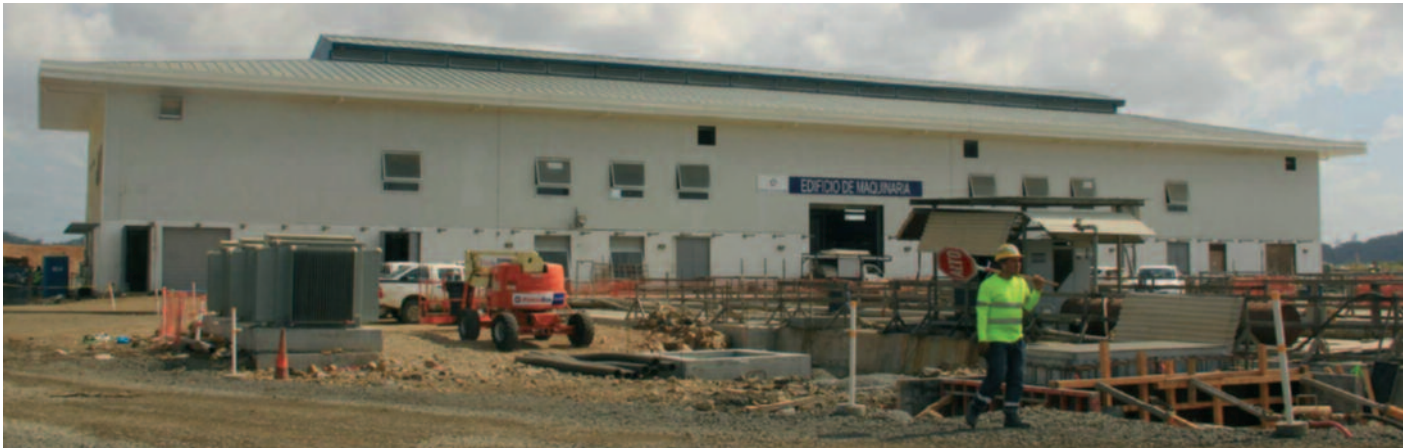
Edificio de Maquinaria
