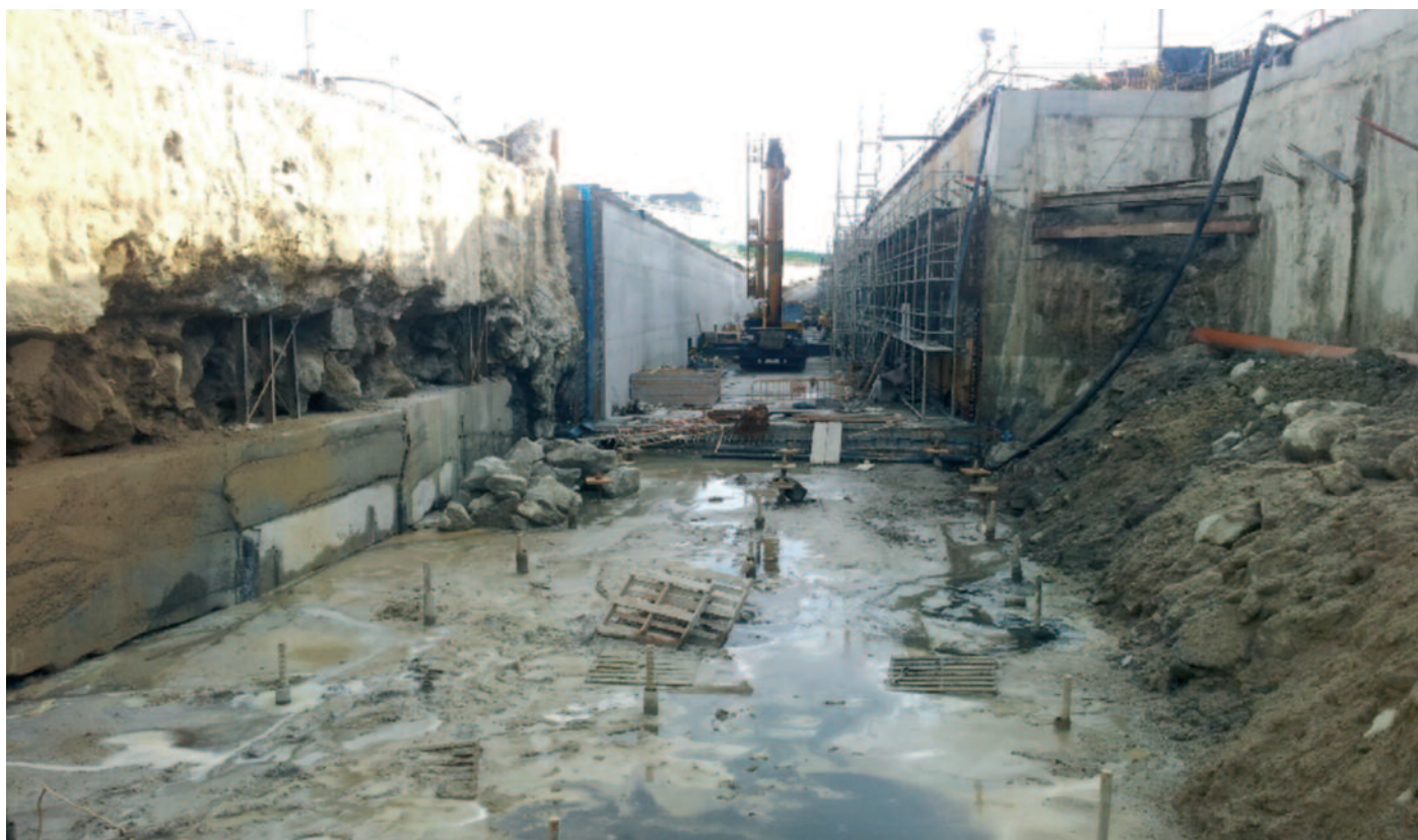
Fases de excavación entre pantallas en el Túnel de El Parrote
