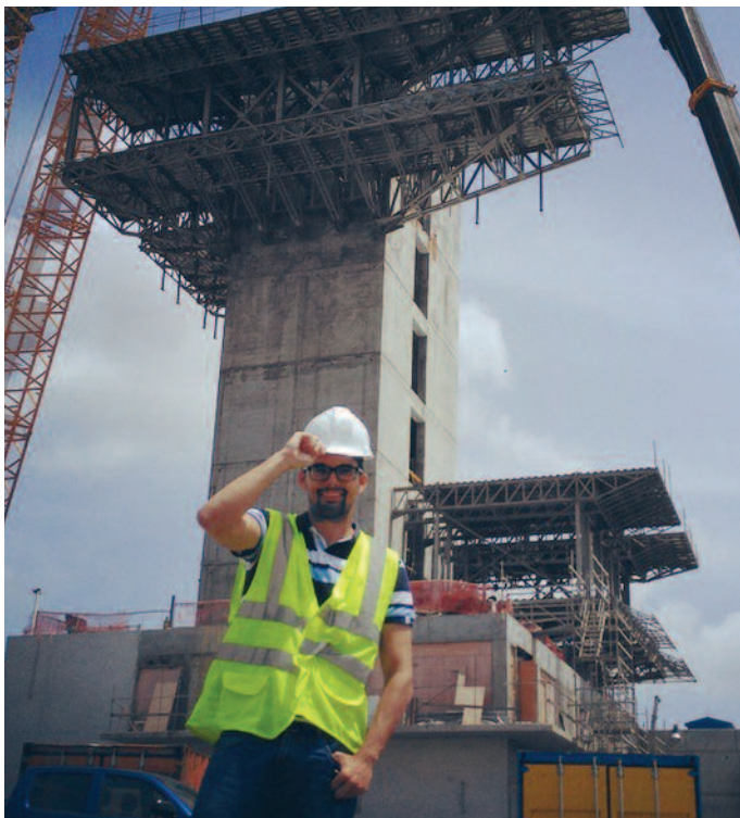
José María Aranda, ingeniero de MC2 durante el montaje de la estructura superior del edificio de control
