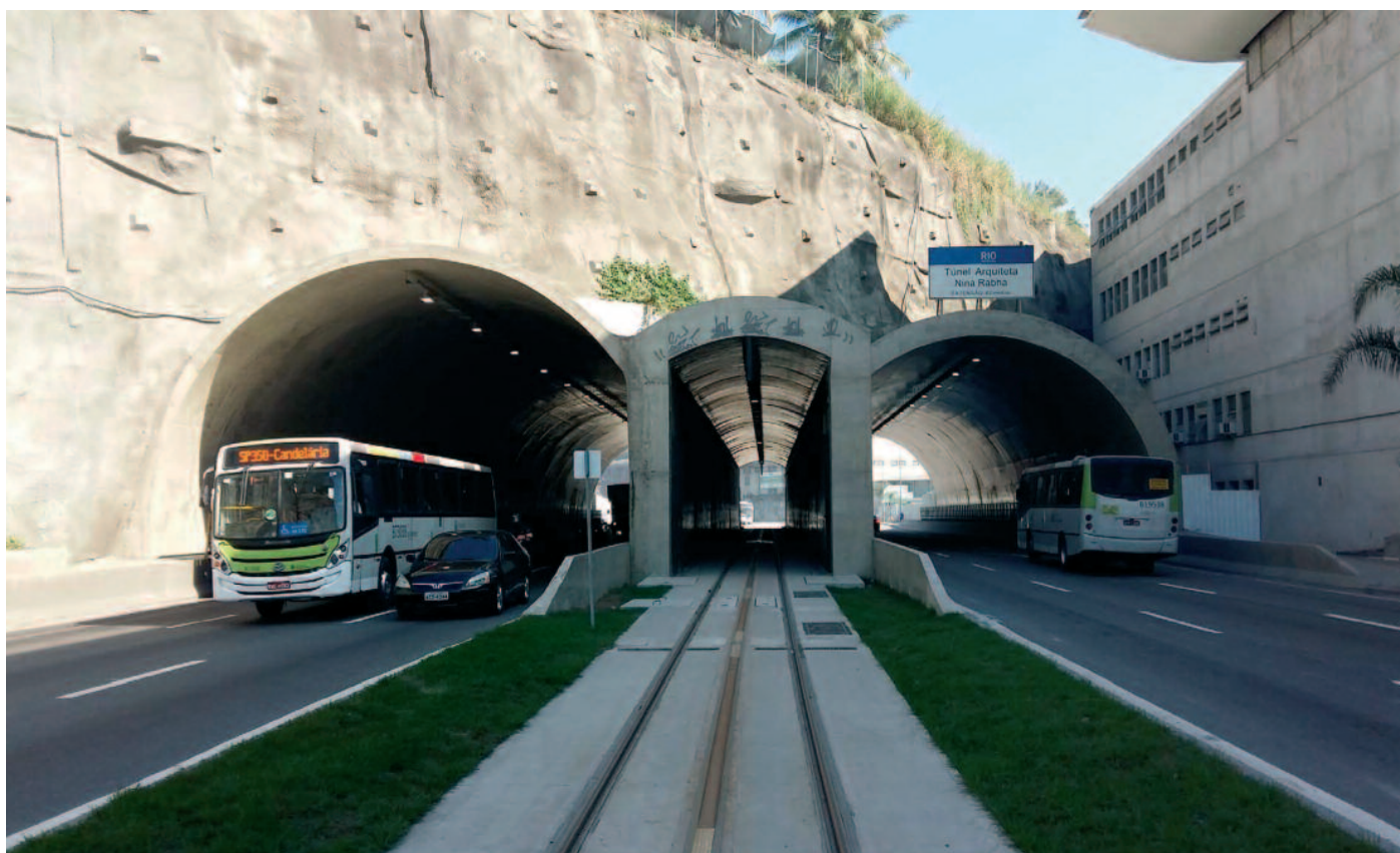
Saúde tunnel (Via Binaria)
