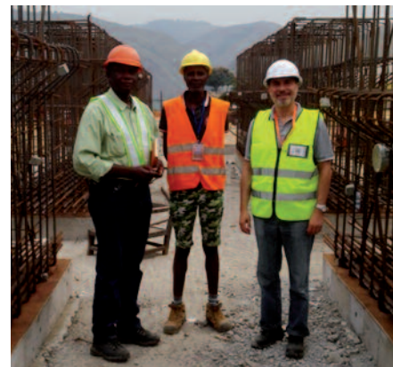
Equipo de inspección de obra durante la visita de julio de 2016
