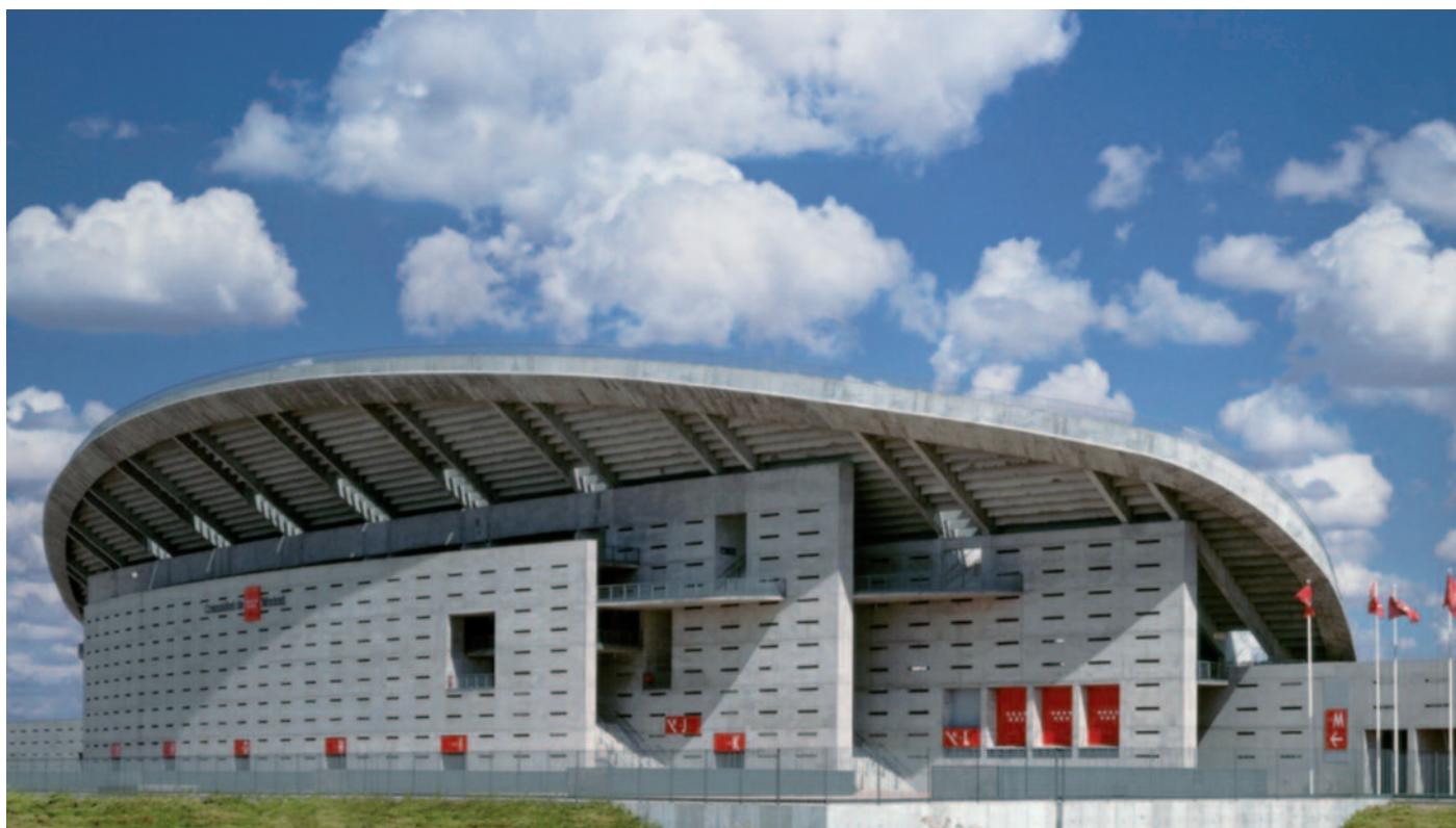
Vista exterior de la Peineta existente
