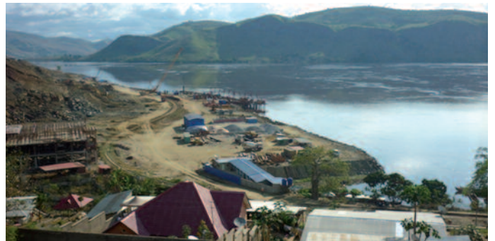
Desarrollo de las obras. Noviembre 2015
