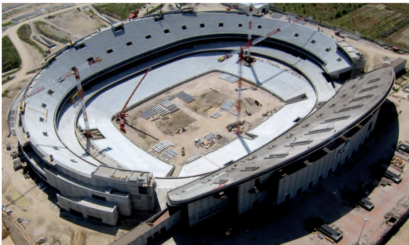
Finalización de la estructura de la ampliación
