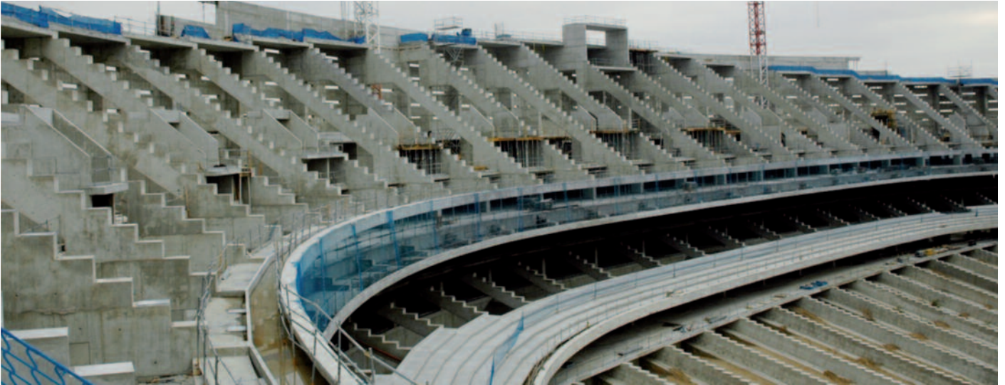
Pórticos de los tres graderíos de la ampliación durante la colocación de las vigas prefabricadas de grada
