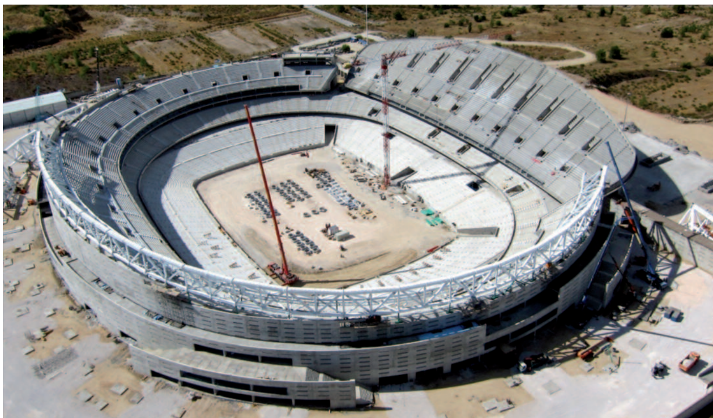
Primeras fase del montaje de la cubierta – anillo exterior
