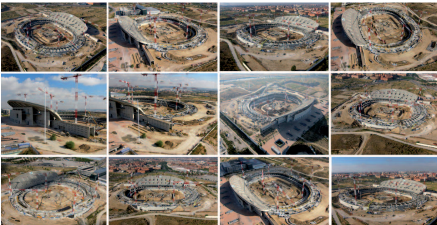
Primeras fases constructivas de la ampliación del estadio
