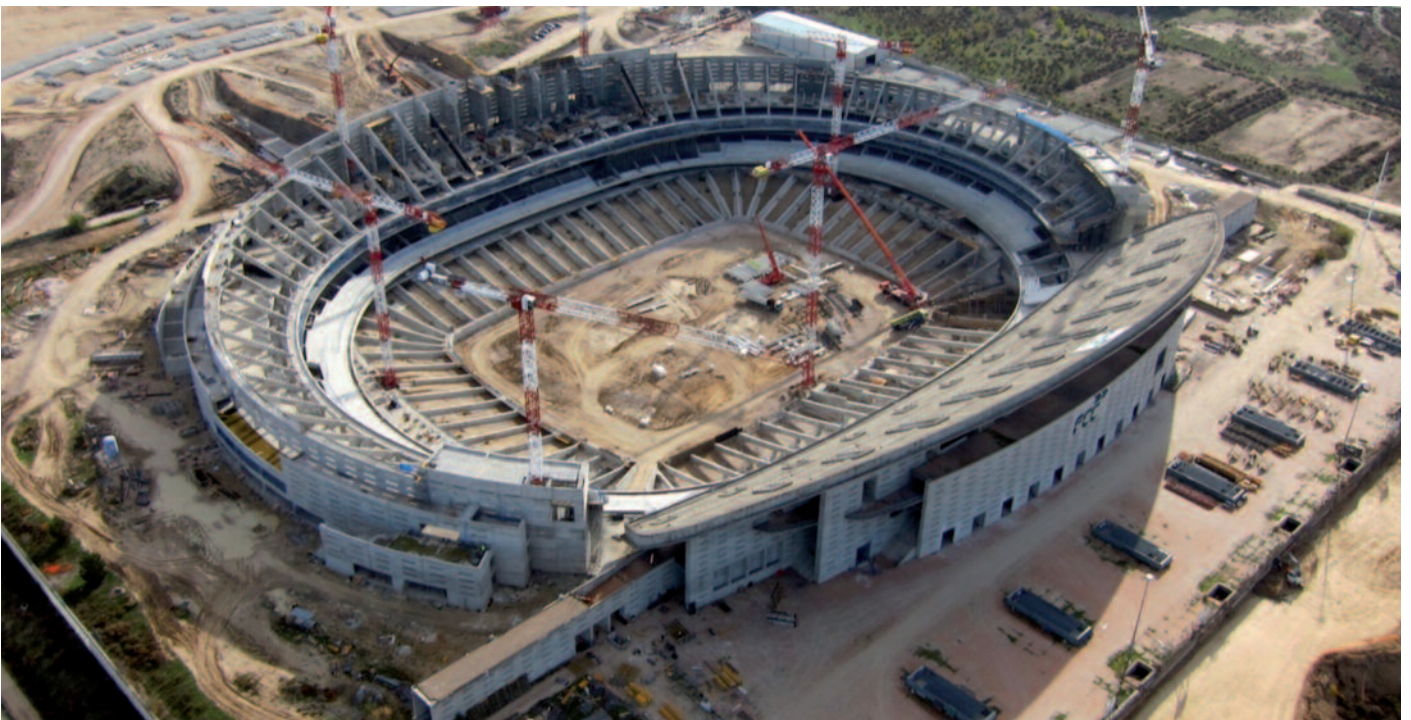
Finalización de los pórticos radiales y muros perimetrales
