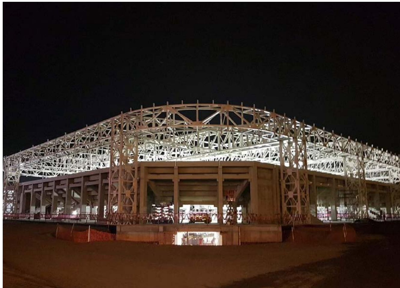
Avance de la obra en febrero de 2019
