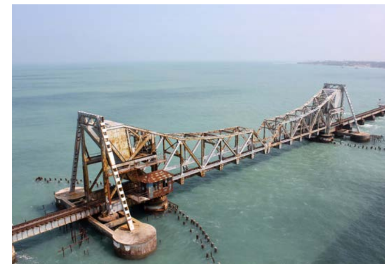
Tramo móvil del Puente de Pampan existente
