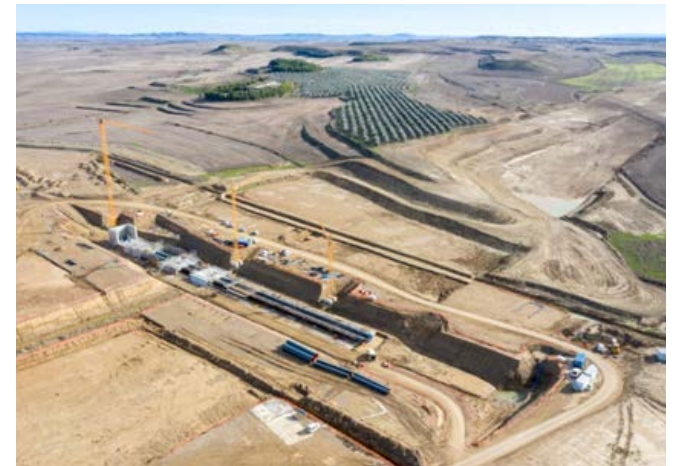
Cimentación y desagües de fondo. Dique oeste
