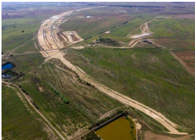
Desbroce y excavación rastrillo y espaldones. Dique este
