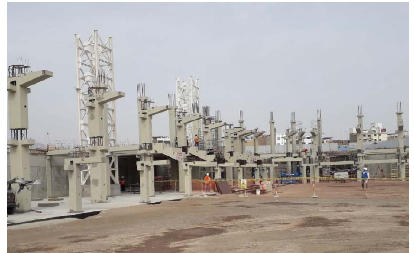
Avance de la obra en diciembre de 2018
