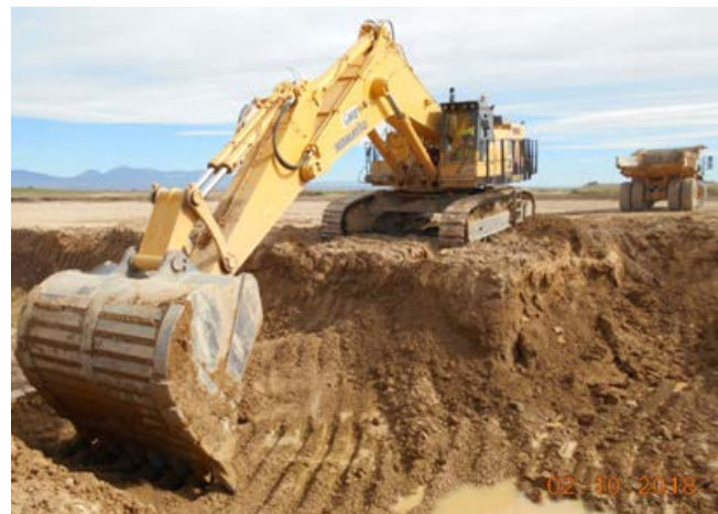
Excavación rastrillo. Dique este
