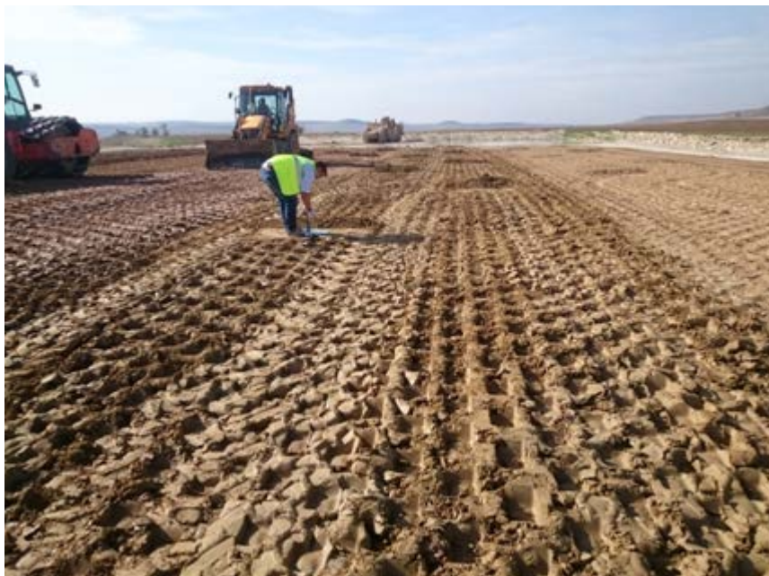
Terraplén de ensayo. Dique este
