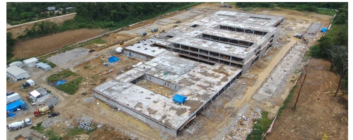
Vistas aéreas de los trabajos de hormigonado de la estructura en la que se aprecia en la parte central los bloques de hospitalización de 3 plantas
