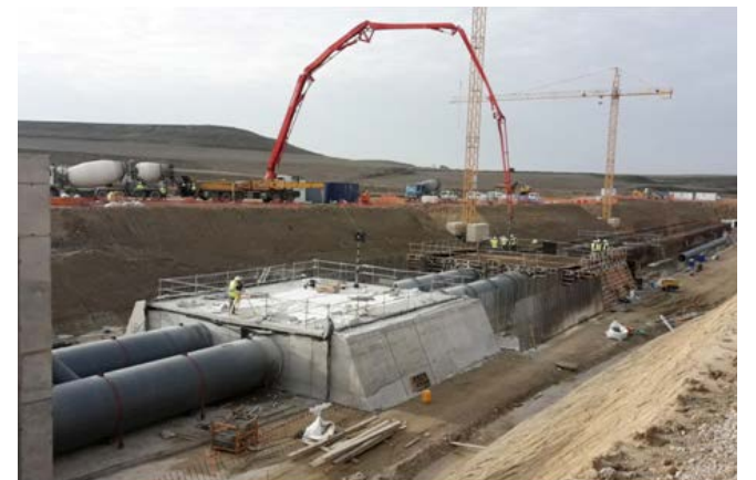
Hormigonado desagües de fondo. Dique oeste
