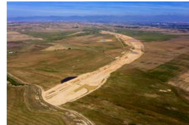
Cimentación dique este
