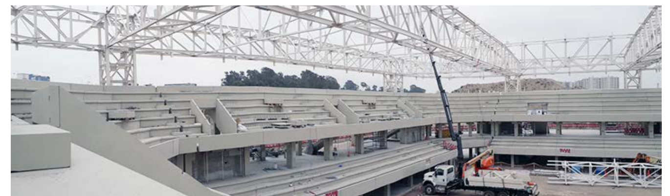
Avance de la obra en enero de 2019
