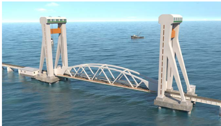
Nuevo puente de desplazamiento vertical. Posición cerrada
