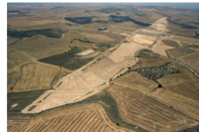
Cimentación dique oeste
