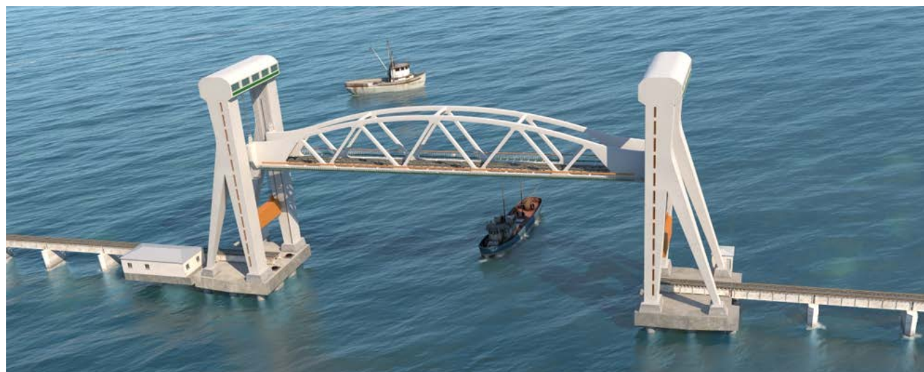
Nuevo puente de desplazamiento vertical. Posición abierta
