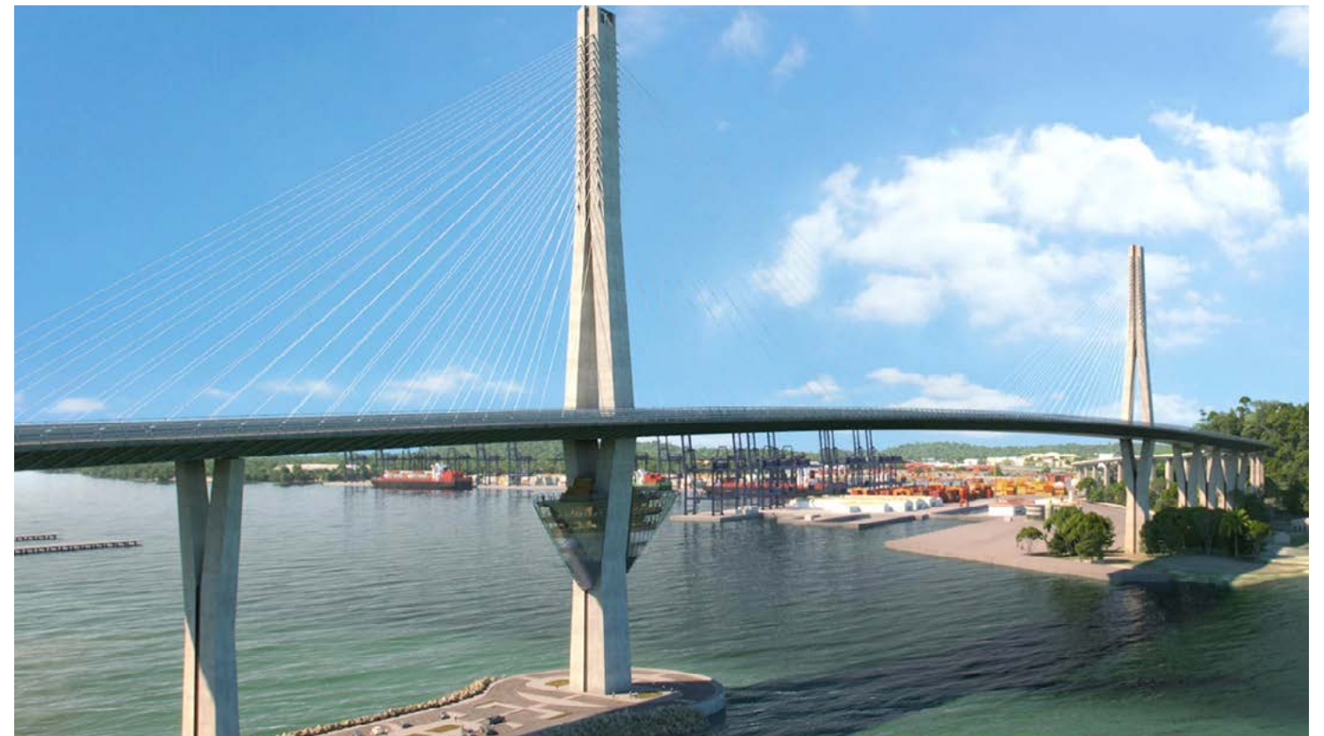
Vista del puente desde el puente de las Américas
