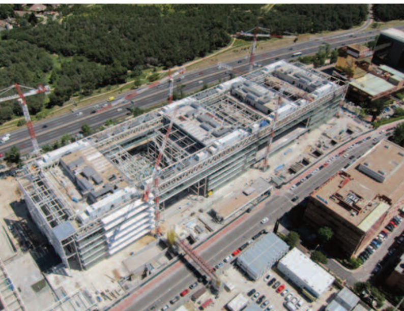
Vista general de la cubierta (mayo 2016)
