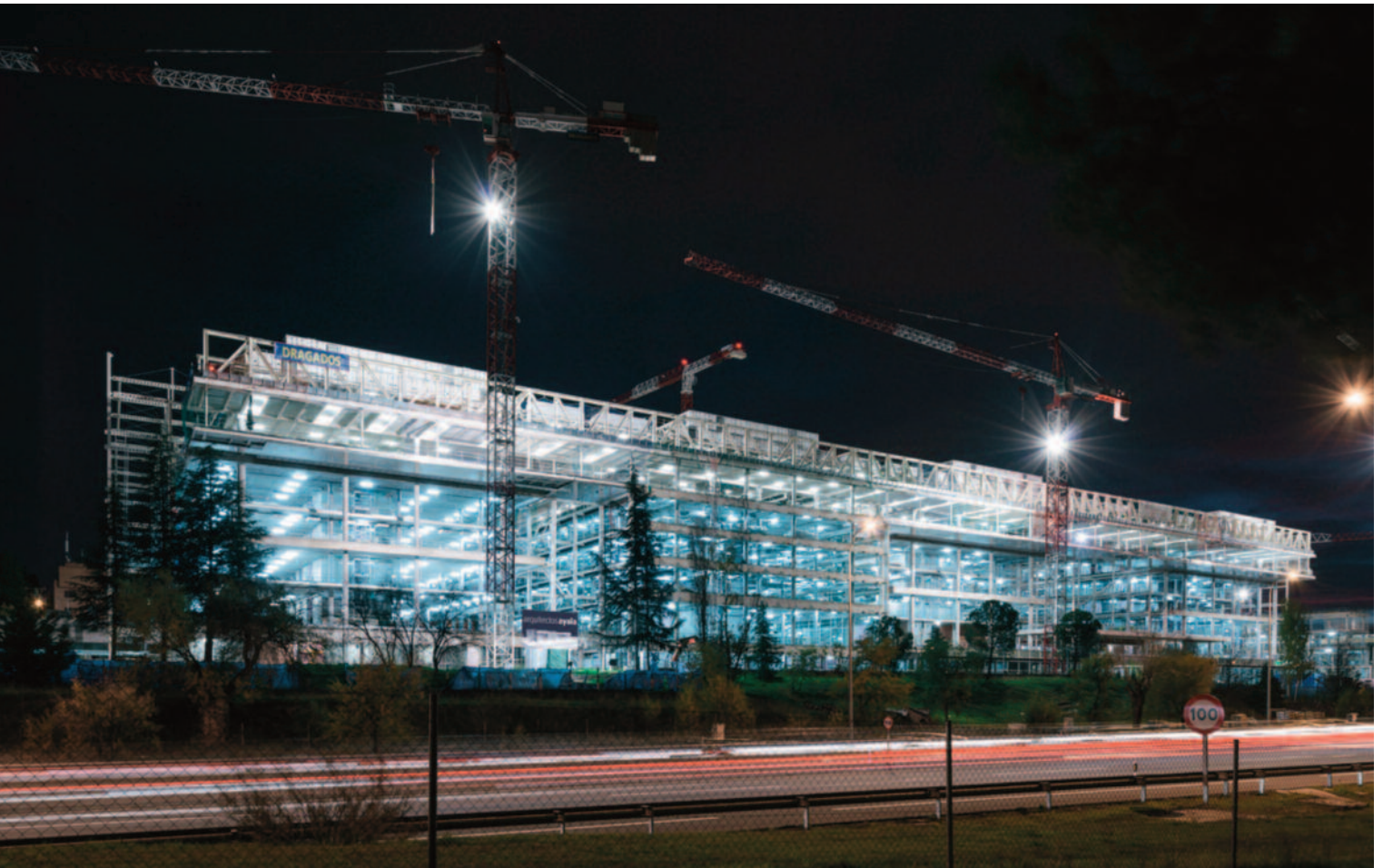
Imagen nocturna de las obras (©Arquitectos Ayala)
