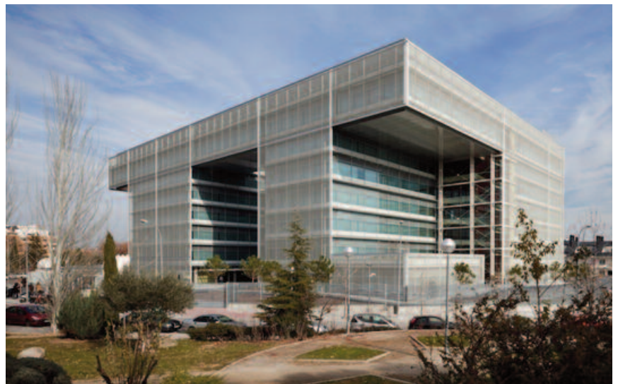
Edificio del Centro de Proceso de Datos (fase 1)
