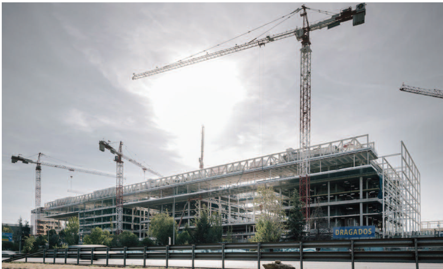
Vista de celosías en la fachada norte (@Arquitectos Ayala)
