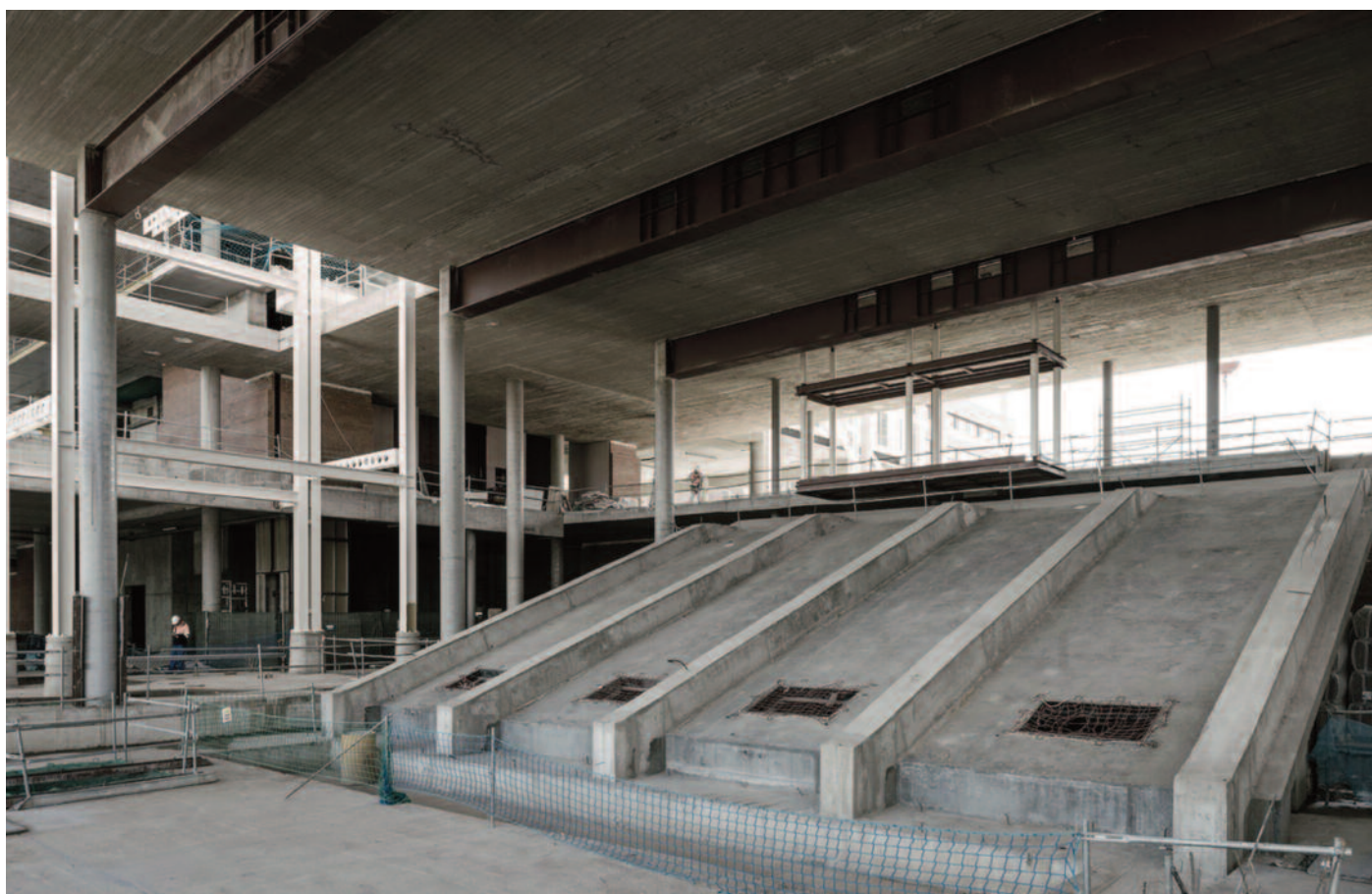
Graderío del salón de actos y cubierta sobre vigas mixtas (@Arquitectos Ayala)
