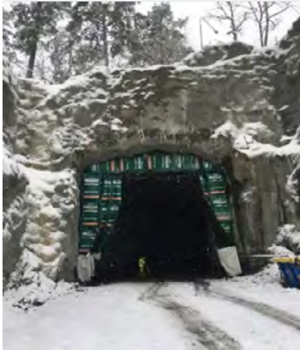
Emboquille del túnel de acceso de Järta Östral / Järta Östra access tunnel mouth
