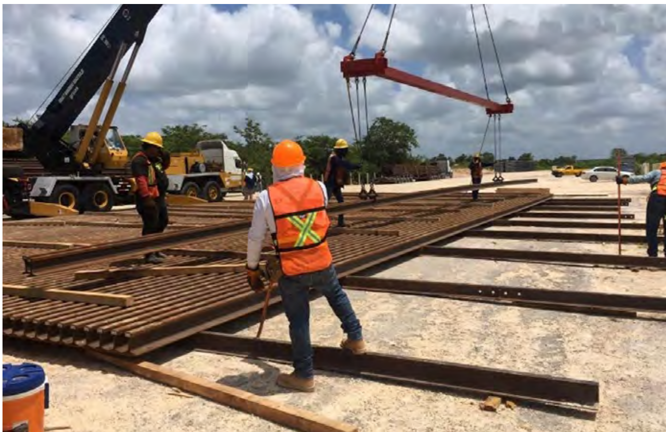
Descarga de carriles en obra T2
