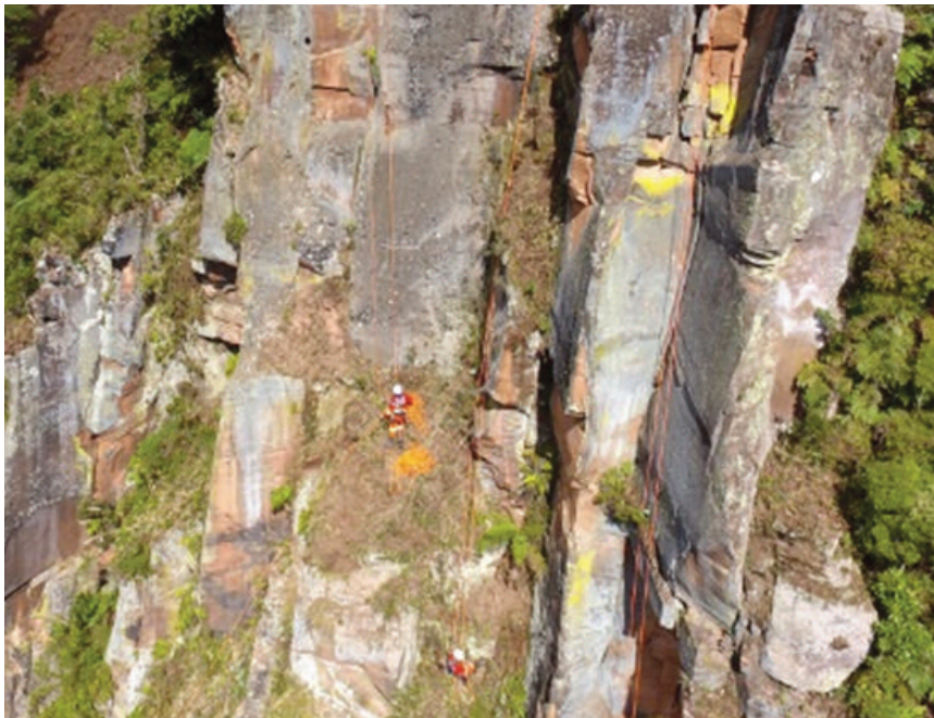
Profissionais em alpinismo executando limpeza
