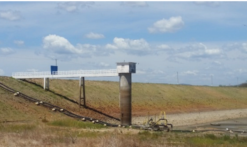
Vista da torre de comando e bomba flutuante para captação de água no reservatório Pau dos Ferros/RN (Acervo Engecorps: foto obtida em fevereiro/2015)
