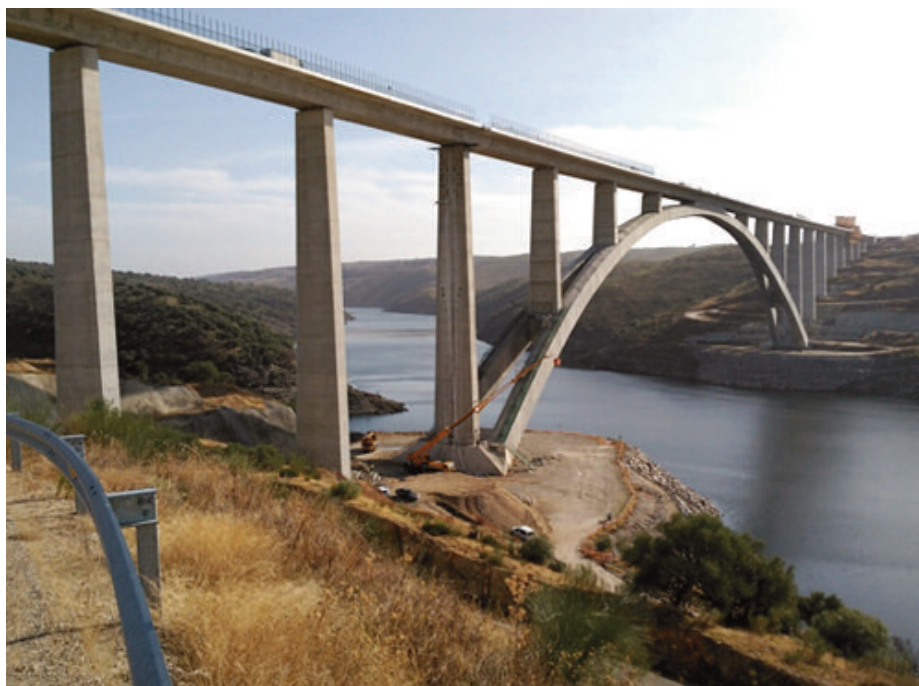
Viaducto sobre el río Almonte
