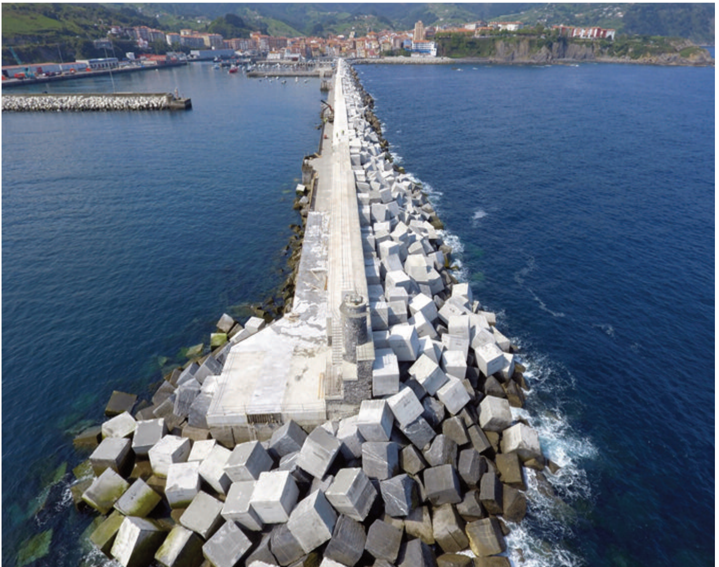
Vista general del dique de abrigo del Puerto de Bermeo (foto tomada desde vuelo dron)
