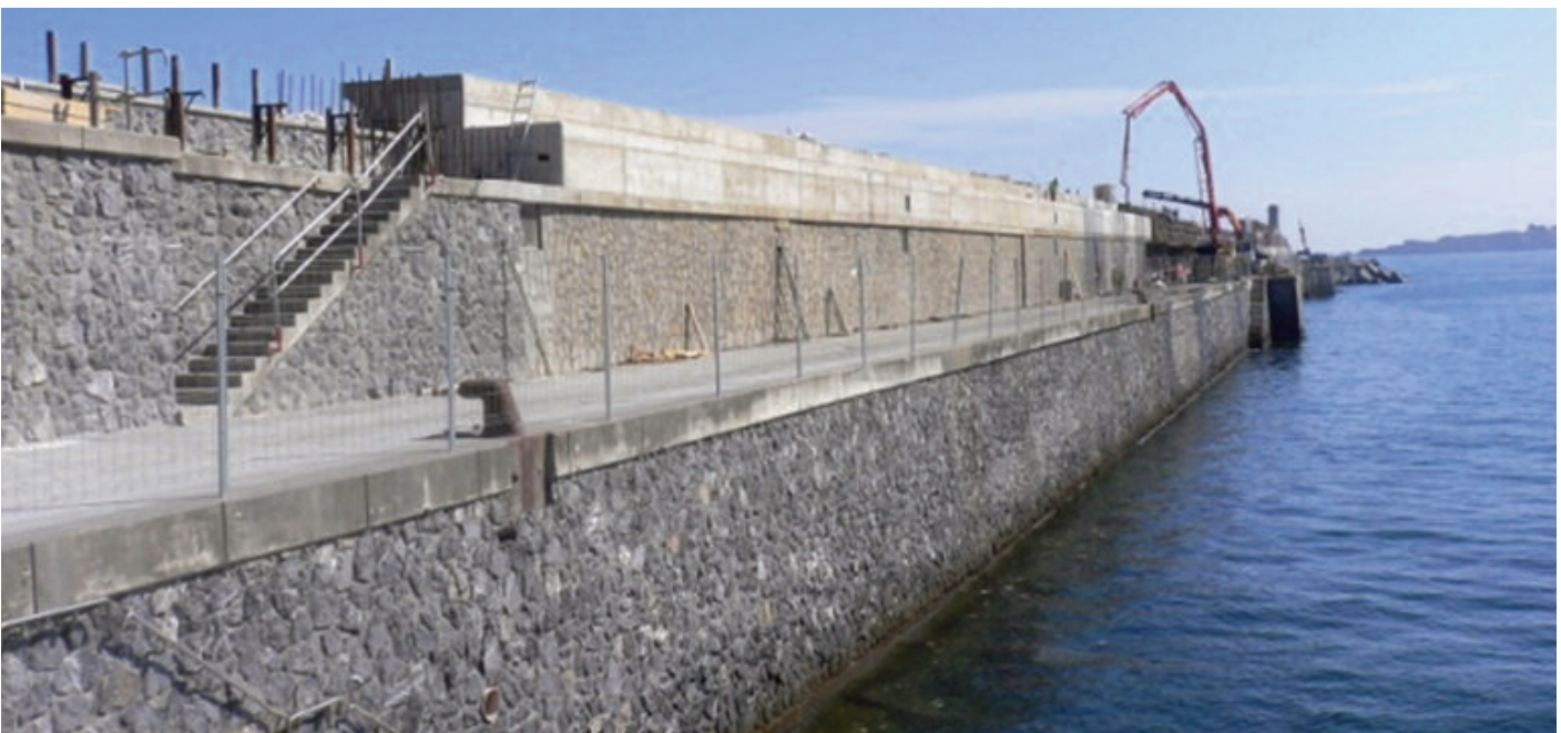
Avance en las labores de recrecido del espaldón
