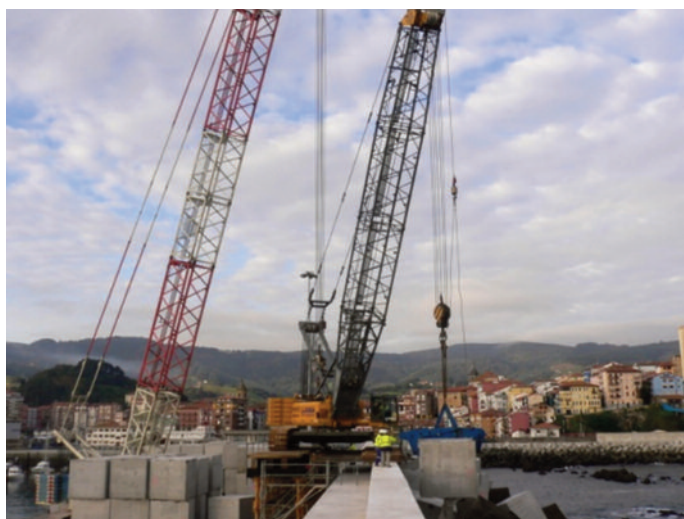
Grúa de 180 t colocando bloques de 40 t
