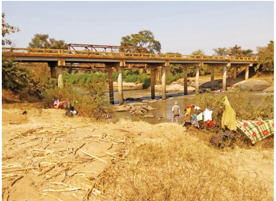
Vista de uno de los puentes a rehabilitar
