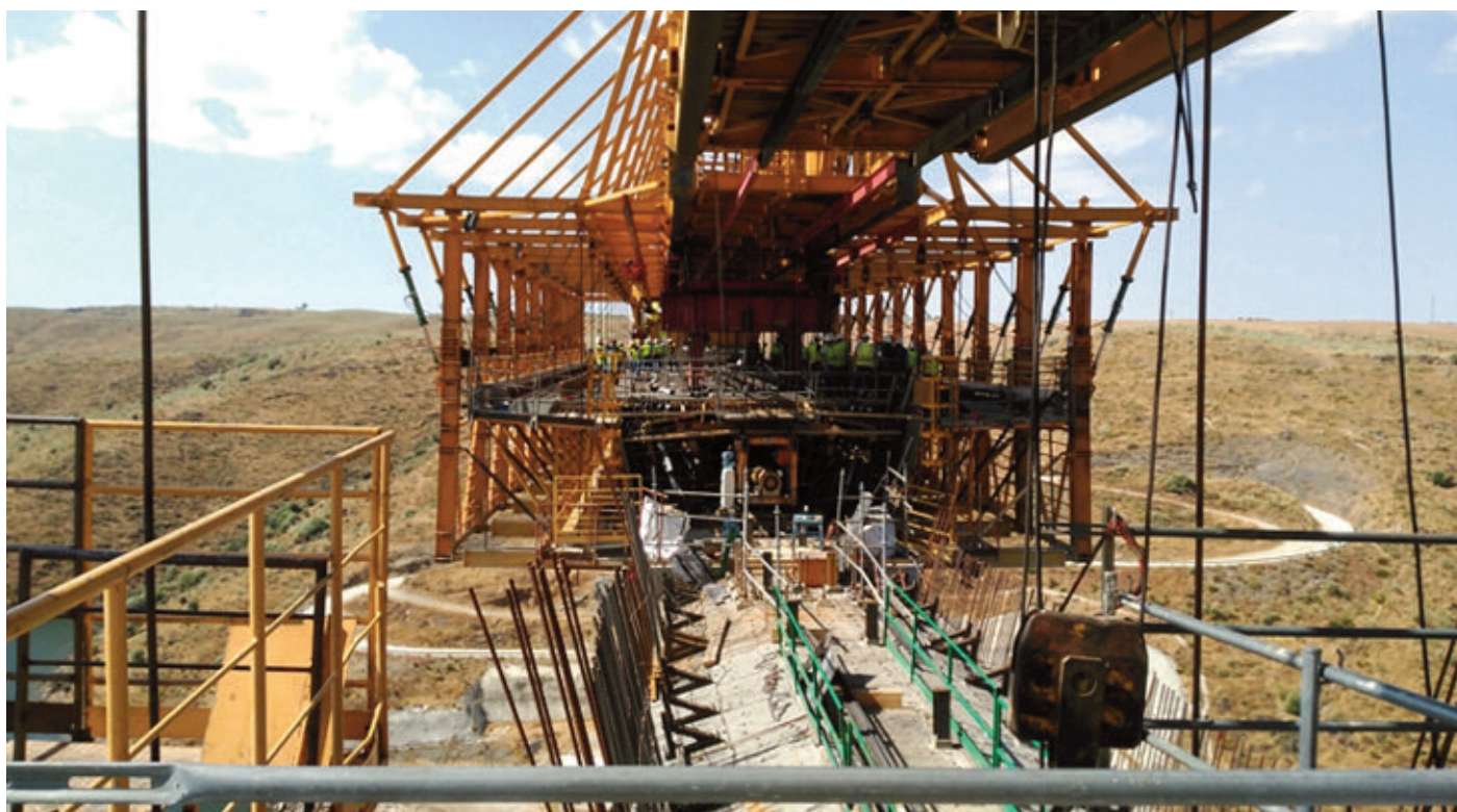
Trabajos de hormigonado en la autocimbra en viaducto sobre el río Almonte
