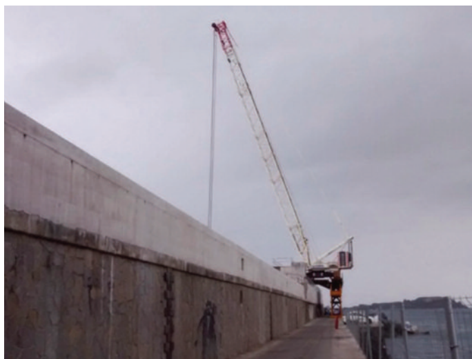
Grúa de 600 t colocando bloques de 60 t
