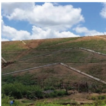
Vista de jusante para a barragem
