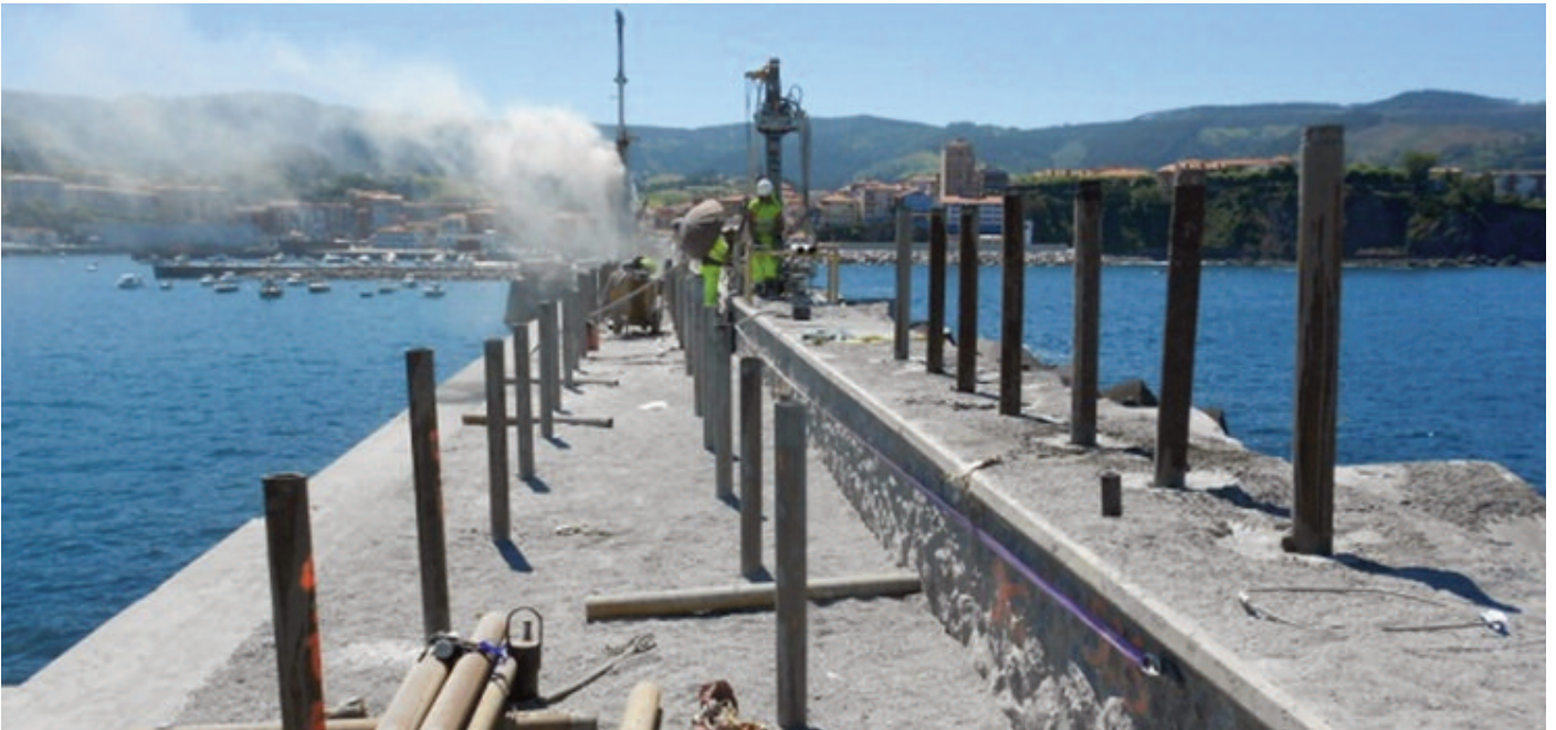
Avance en las labores de micropilotaje
