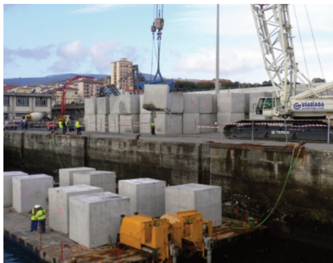
Transporte marítimo con apoyo grúa de 600 t
