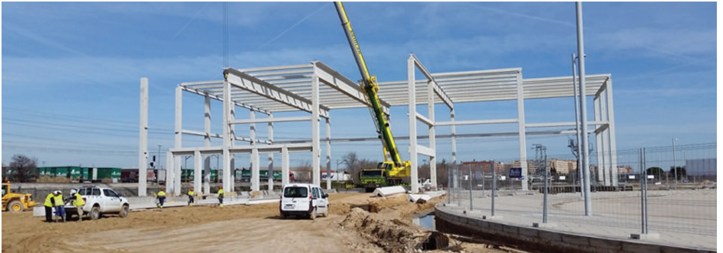
Estructura de la Nave Air&Ocean
