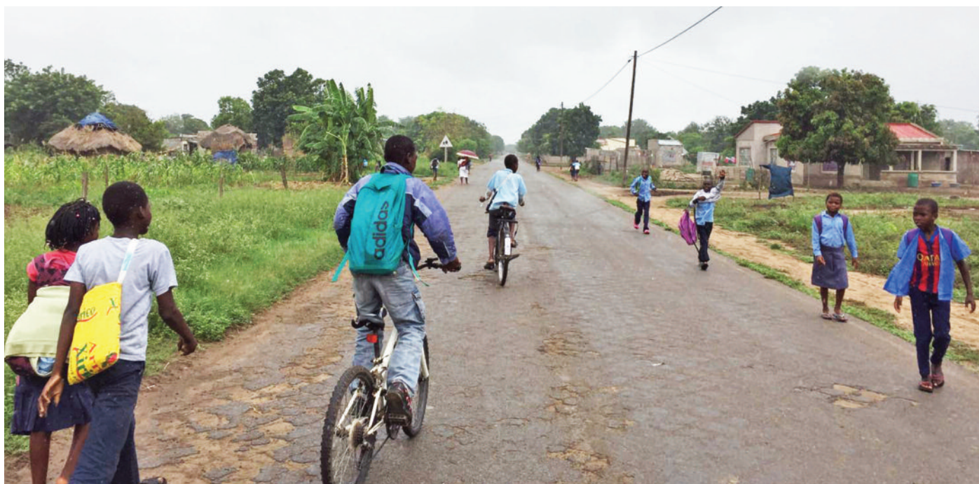
Carretera antes de las obras de rehabilitación
