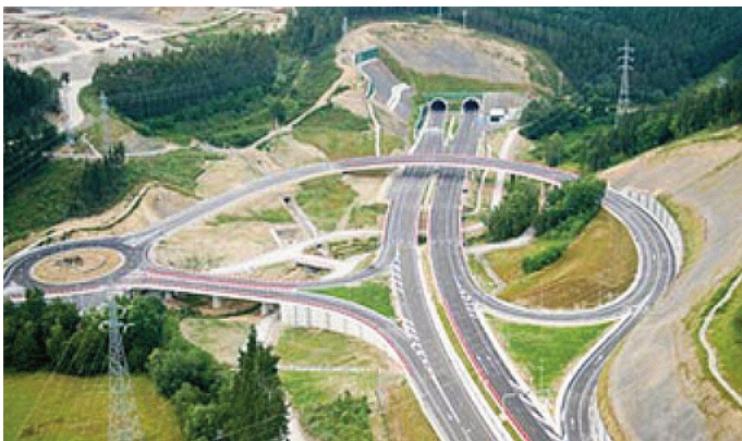
Autovía Gerediaga Elorrio. Enlace de Muntsaratz
