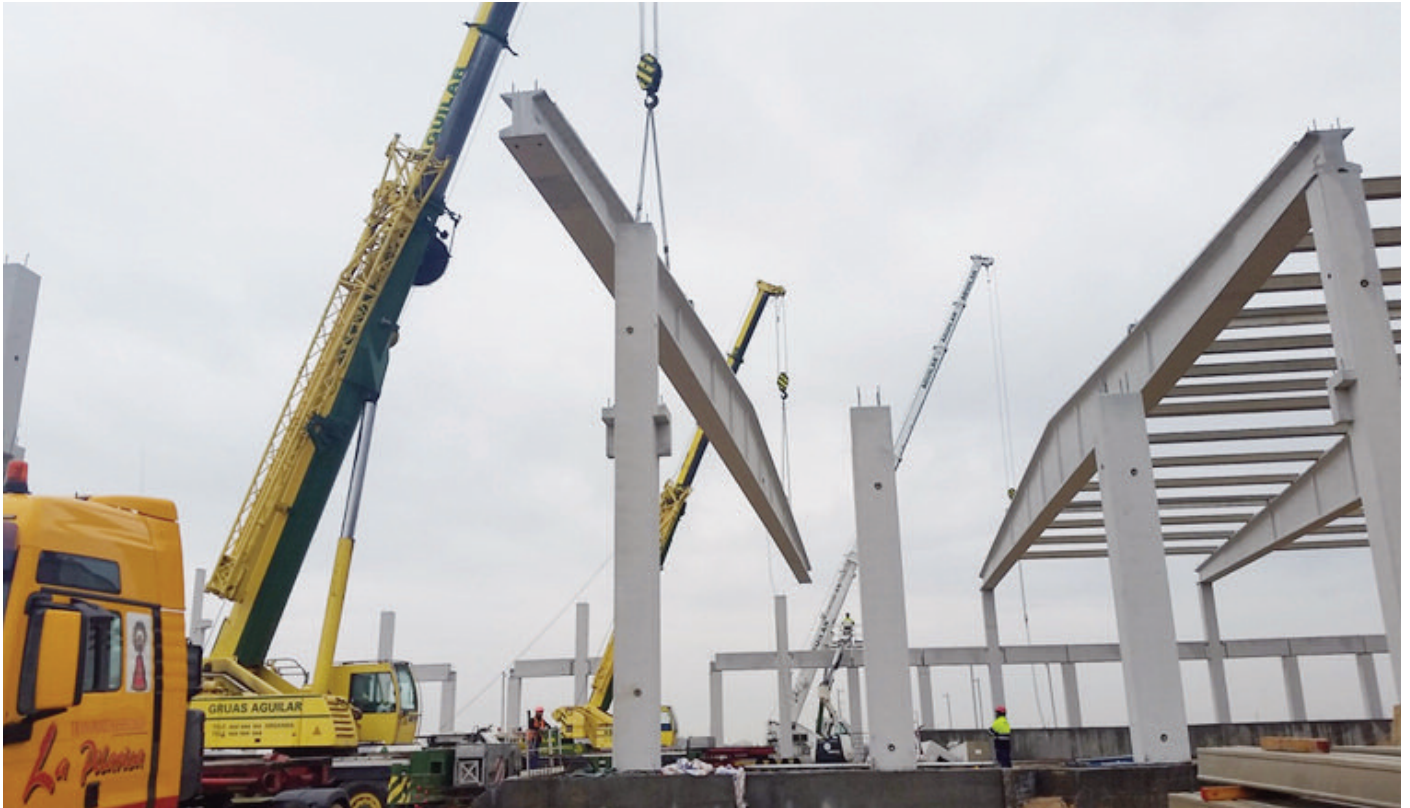
Montaje de vigas en la Nave Cross-Docking
