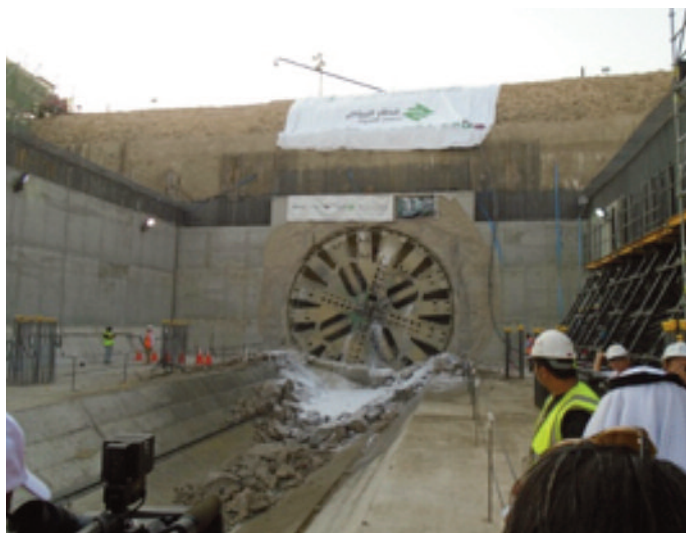
Salida de tuneladora tipo EPB en zona urbana de bajo recubrimiento. Línea 5 de Metro de Riad
