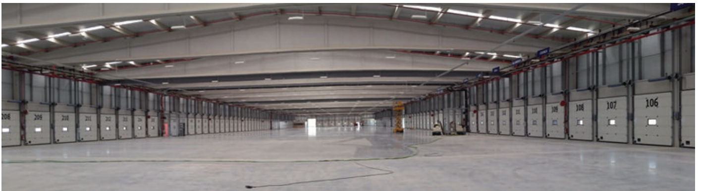
Interior Nave Cross-Docking antes...
