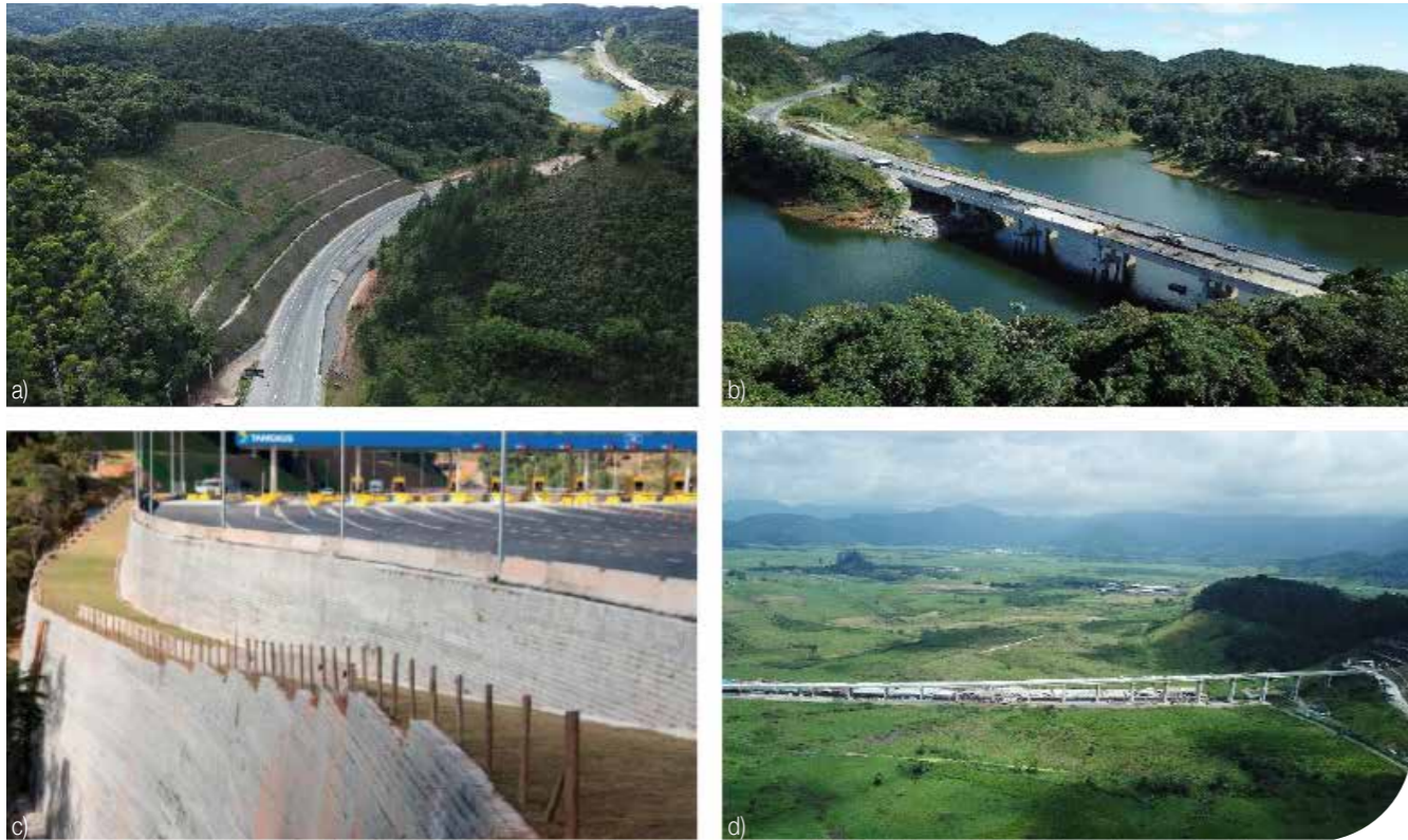
a) Movimiento de tierras en el tramo del Planalto; b) Puente sobre el embalse de Paraibuna; c) Muro de contención y peaje al fondo; d) Viaducto en la planicie costera.
