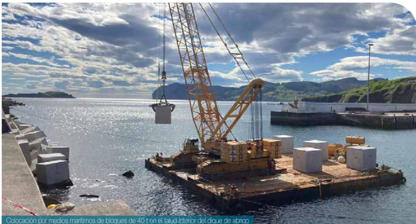
Colocación por medios marítimos de bloques de 40 t en el talud interior del dique de abrigo
