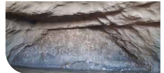
Detalle de la formación techos planos en el frente túnel
