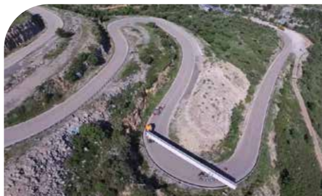
Acceso de vigas prefabricadas de 40 m por el puerto. Voladizo trasero de 9 m
