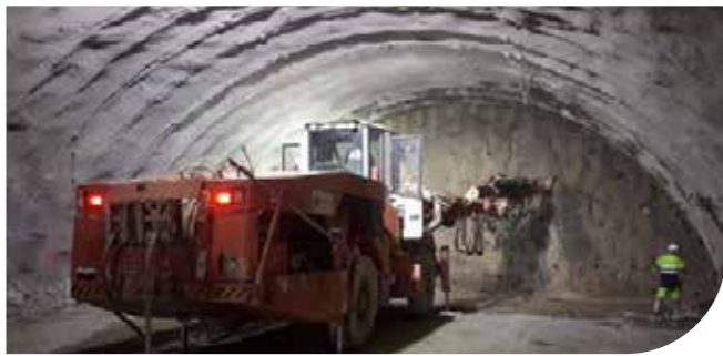
Perforación de barrenos con Jumbo Tamrock
