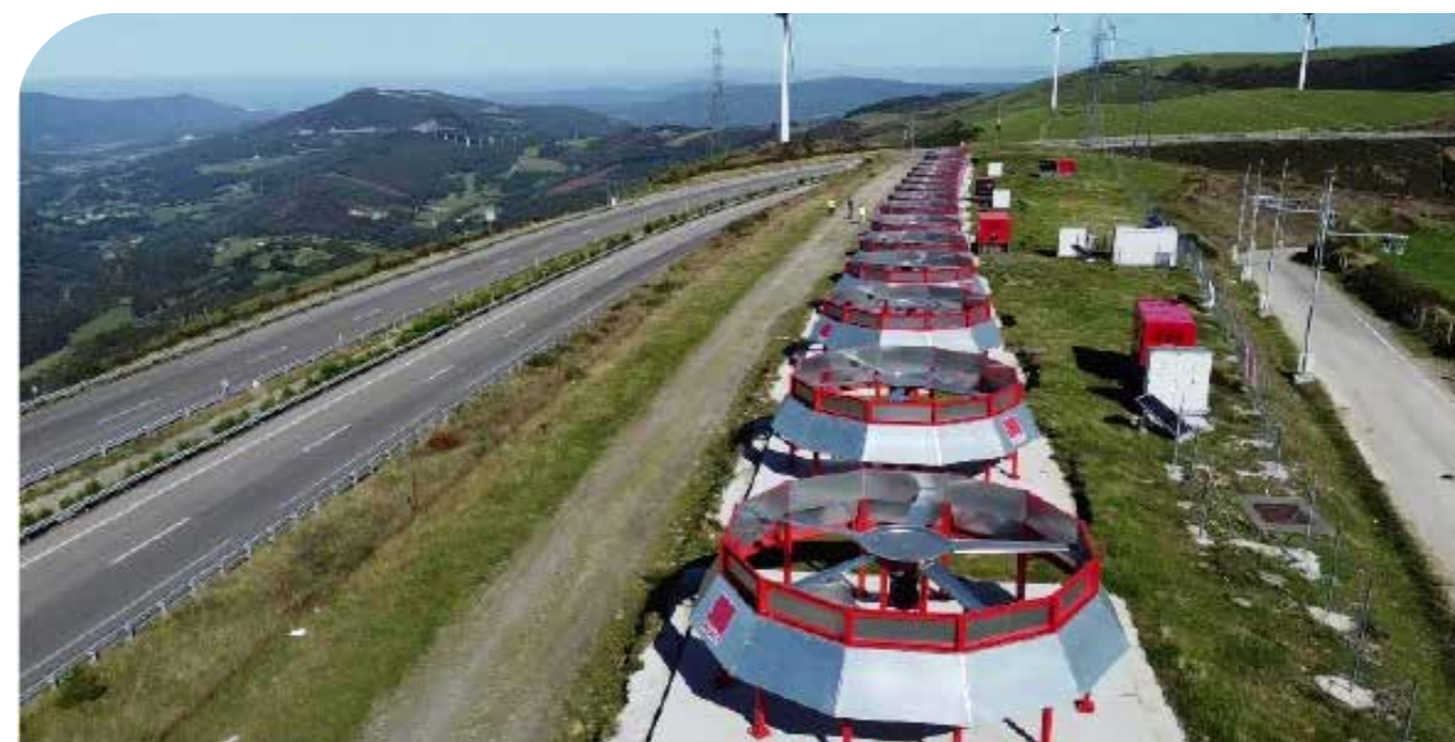
Barrera dinámica compuesta por una hilera de ventiladores de eje vertical; entrada de niebla por la derecha de la imagen, que es desviada hacia arriba a su paso por la autovía
