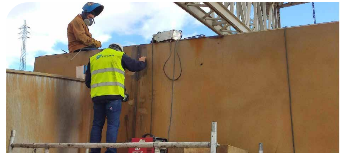
Ensayos de soldadura no destructivos por ultrasonidos. Uniones a tope
