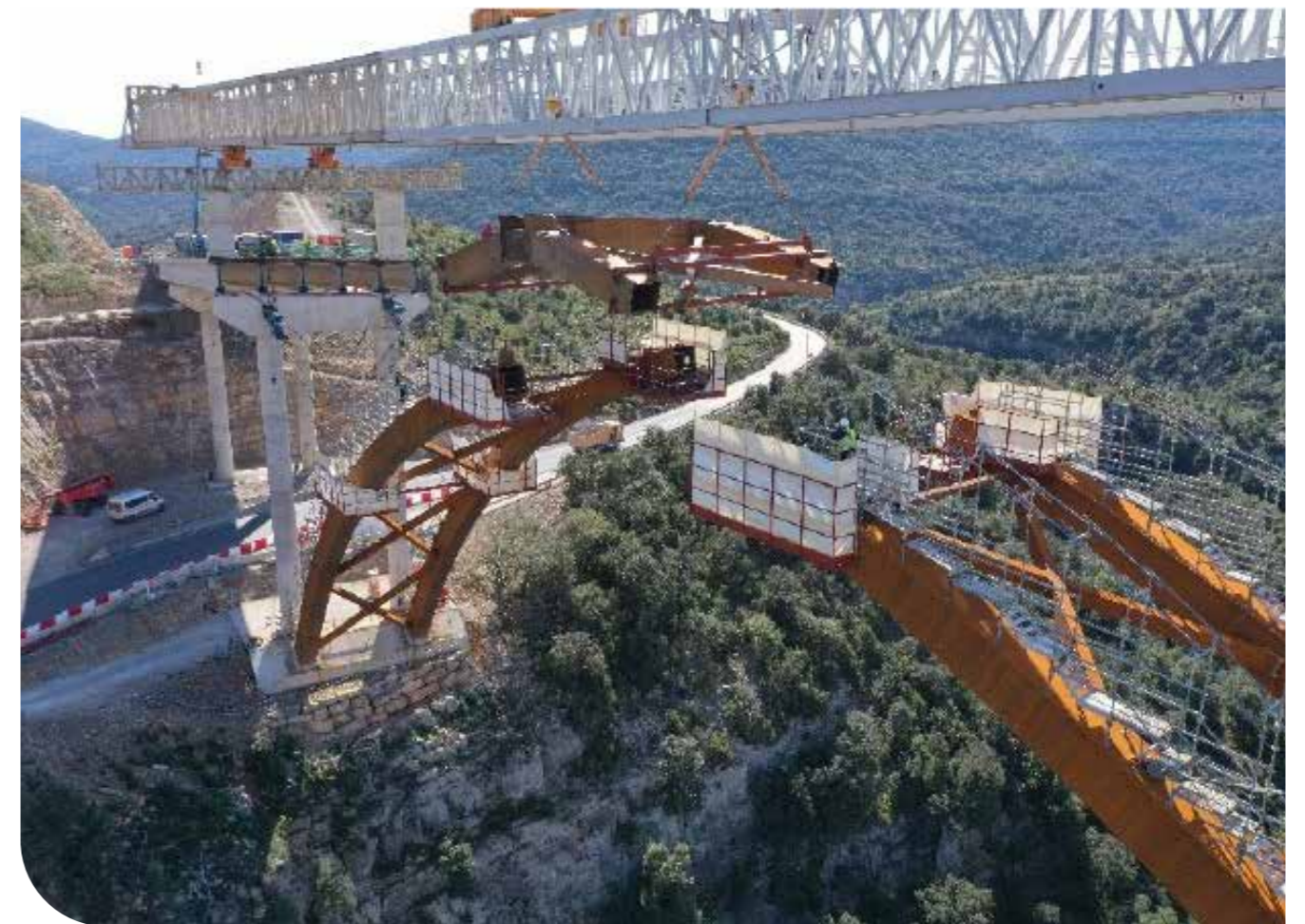
Colocación de la pieza de cierre del arco
