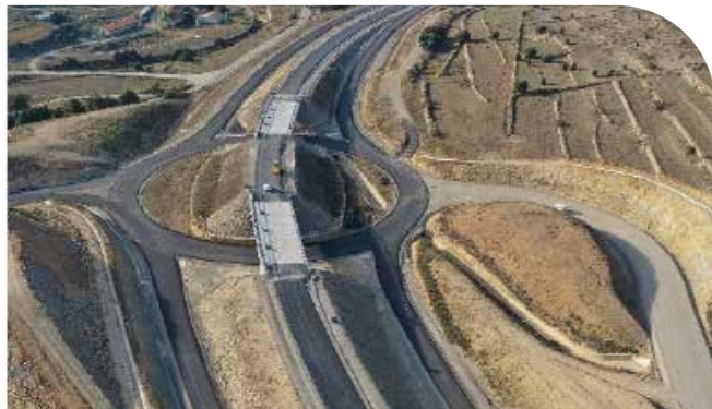
Detalle del enlace que conecta con la CV-111 de acceso hasta Vallibona
