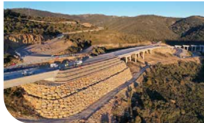
Detalle de un "muro ecológico" realizado con materiales procedentes de la excavación
