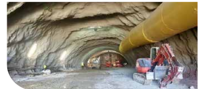
Excavación túnel. Formación "techos planos"
