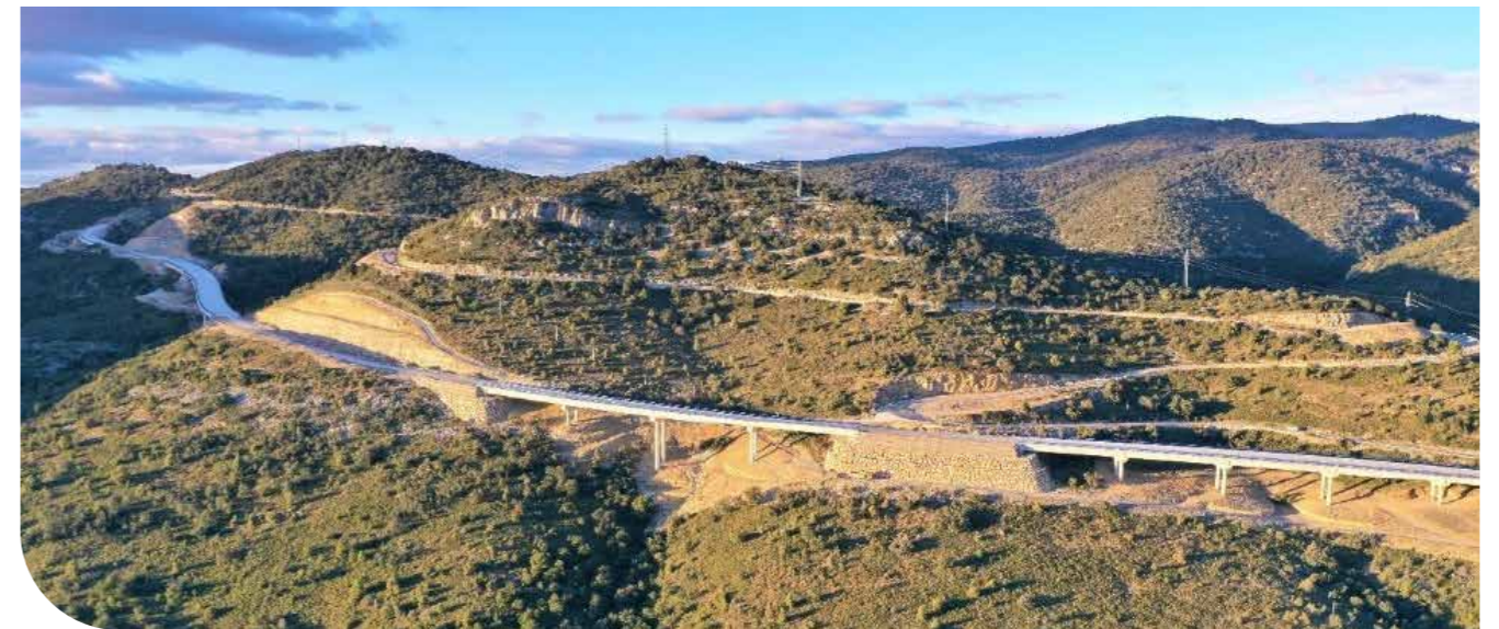
Vista del nuevo trazado en zona Barranco de La Bota e inicio Puerto Querol
