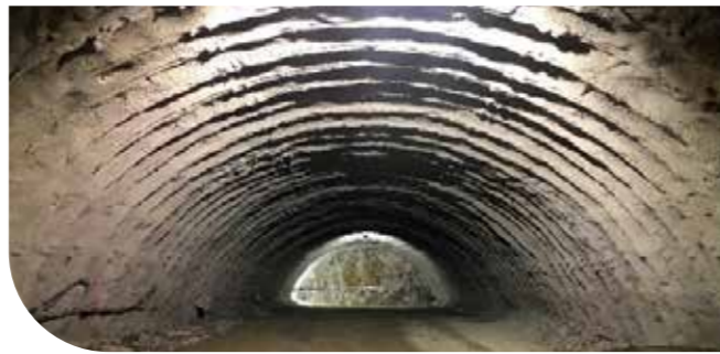
Excavación del túnel en sección de avance
