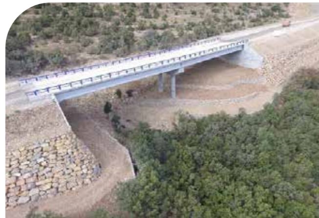
Acondicionamiento de vaguadas con muretes, tierra vegetal y plantaciones
