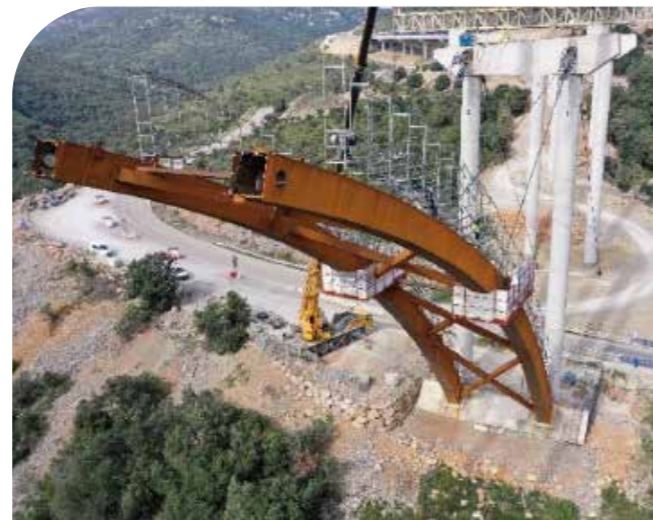
Montaje de tramos de arco desde pk+
