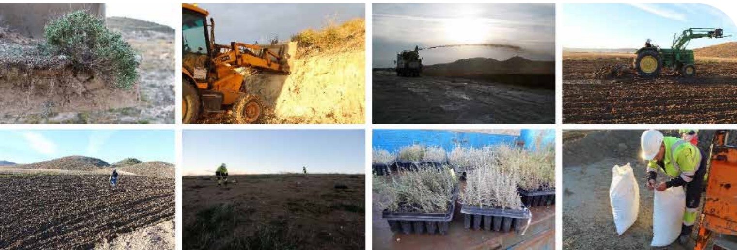
Diferentes actuaciones de restauración. De izda a dcha: tepes, hidrosiembra, siembra y plantación.
