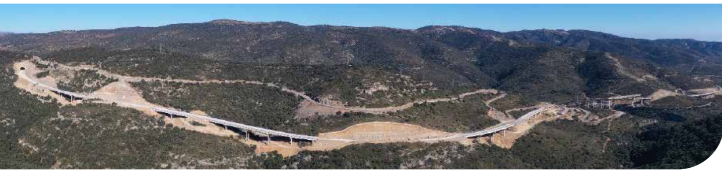
Vista panorámica del Puerto de Querol. (Situación actual-Obra de acondicionamiento)
