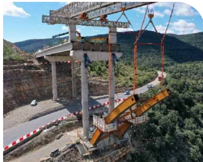
Montaje de tramos de arco desde pk-
