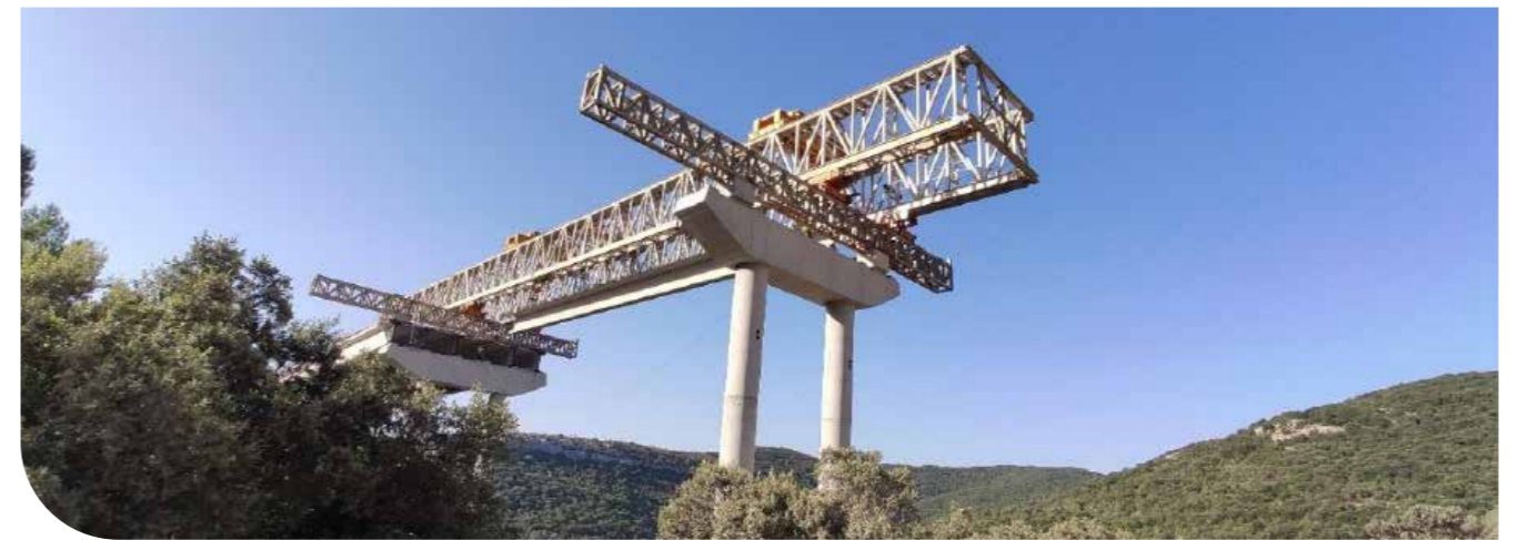
Vista del equipo lanzavigas durante la colocación de las vigas de un vano en el viaducto V-2.8
