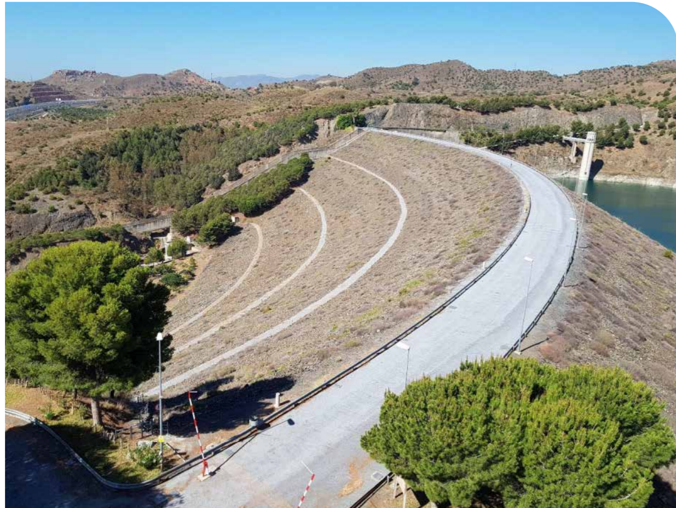
Vista de la coronación de la presa de El Limonero (Málaga)
