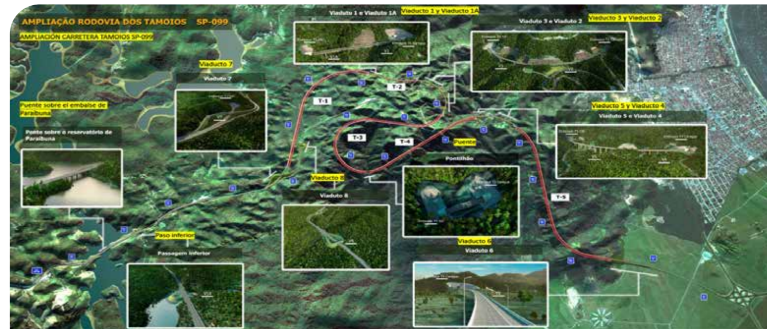
Ruta de la remodelación del tramo Sierra de la Rodovia dos Tamoios
