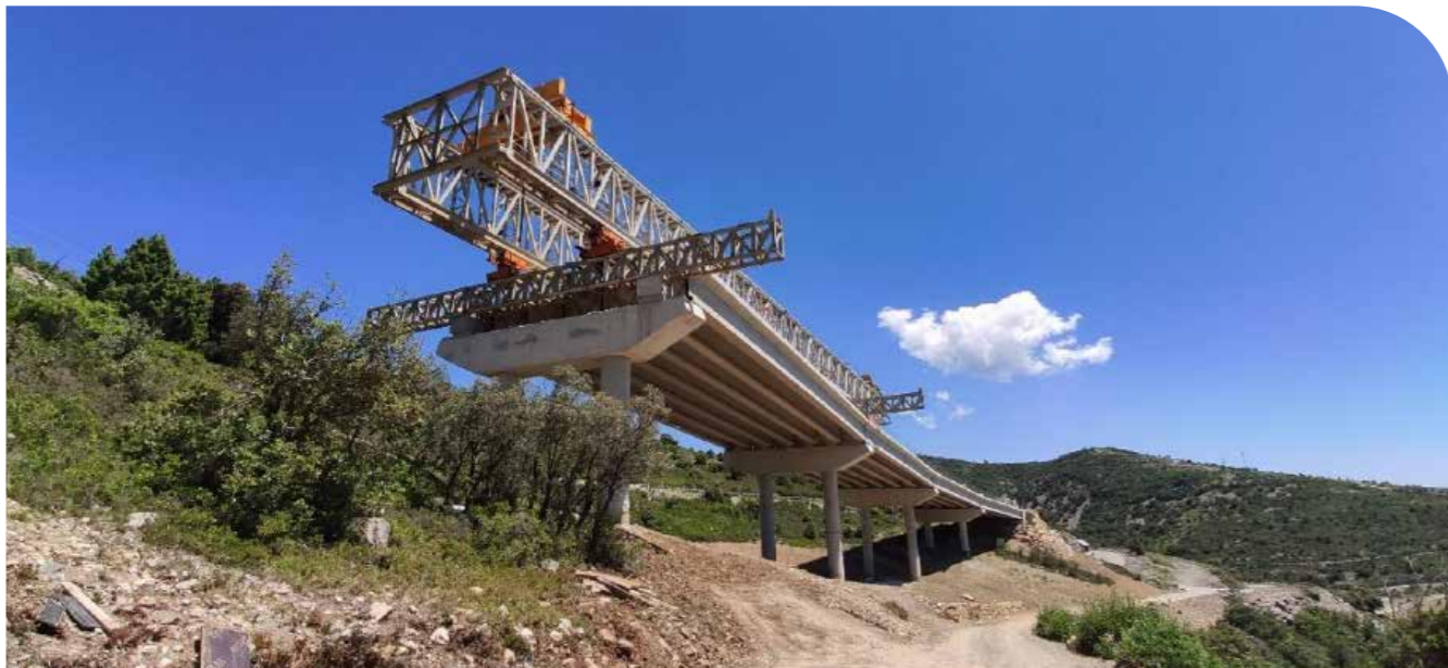
Vista del equipo lanzavigas completando un vano del viaducto V-2.1
