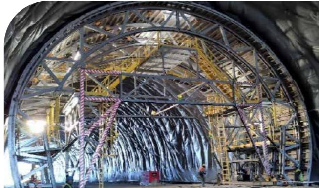
Carro de encofrado para revestimiento de túnel
