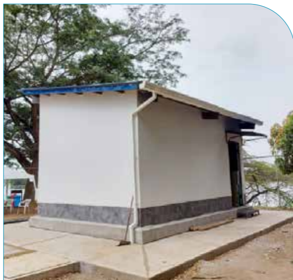
Estación de Monitoreo Remoto (EMR)
