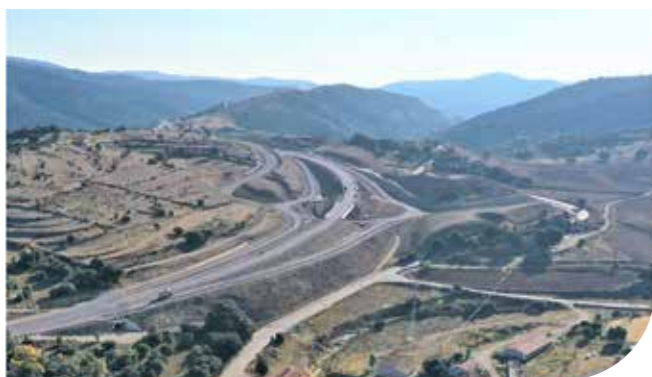
Vista aérea de la zona donde se ubica el enlace
