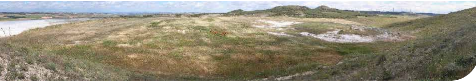
Meseta de la escombrera y taludes oeste (en primer término) y sur (mayo de 2021)
