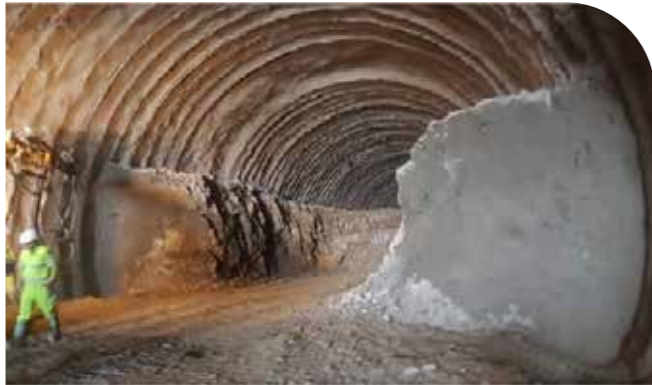
Excavación del túnel en sección de destroza central y bataches alternos
