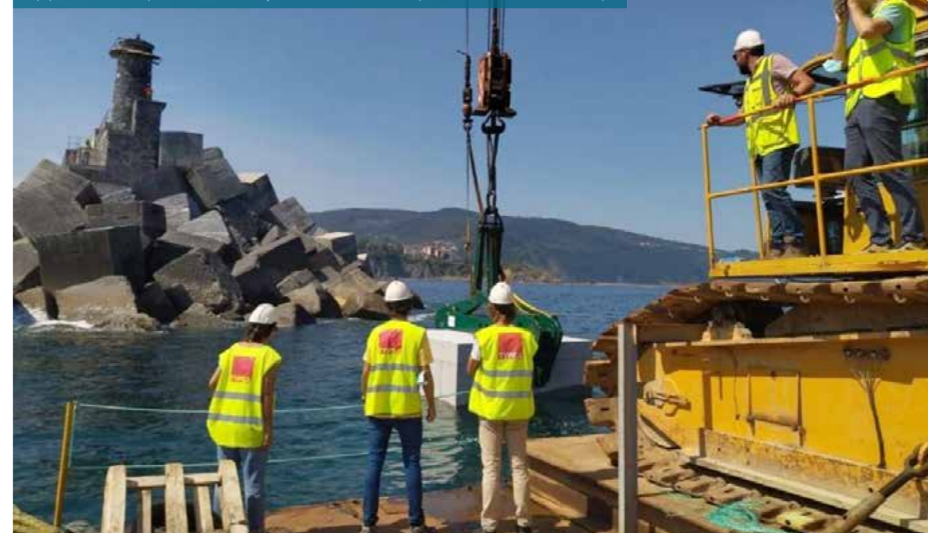
Equipo de TYPSA supervisando los trabajos de colocación de bloques de 80 t en el morro del dique
