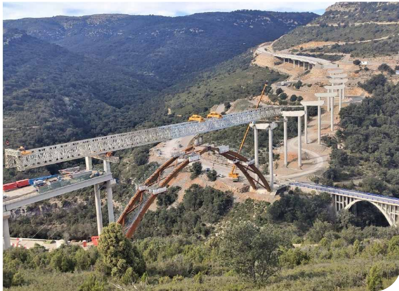
Vista general del Viaducto del Barranco de La Bota
