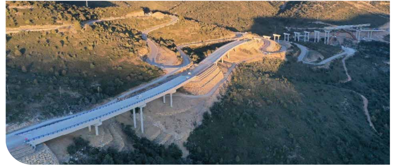
Vista del nuevo trazado en zona Barranco de La Bota e inicio Puerto Querol
