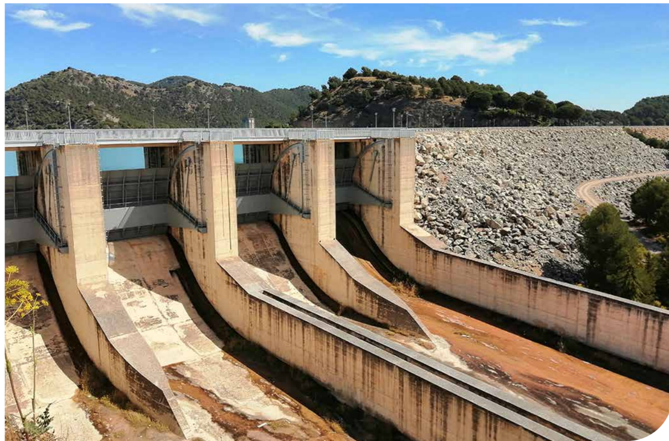
Aliviadero de la presa de Guadalteba
