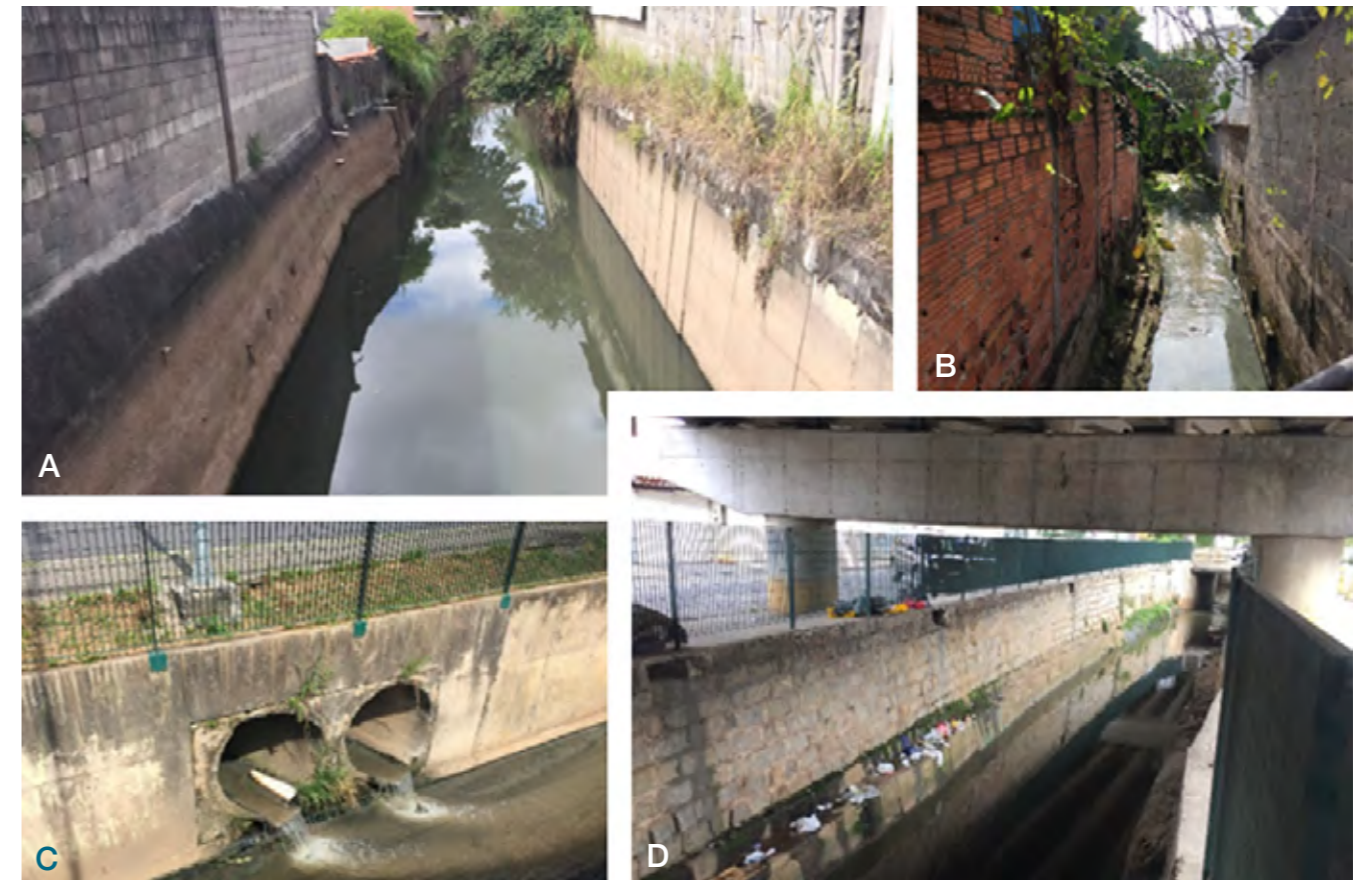
A) Tuberías de descarga irregular en la red de agua. B) Zanja de drenaje en una zona sin colector de aguas residuales. C) Descarga de caudal de tiempo seco en macrodrenaje urbano. D) Acumulación de residuos sólidos urbanos en el cauce del arroyo
