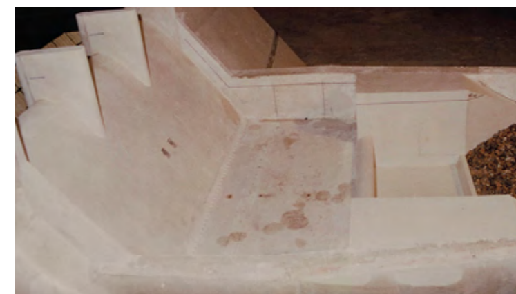
Presa de la Risca: disipación de energía en dos etapas, con dos cuencos en serie. Diseño forzado por la presencia de una oquedad en el extremo aguas abajo del cuenco.
