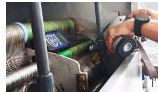
Medición mediante fluorescencia de RX de la calidad del acero de los anillos internos de un tornillo deshidratador de fangos
