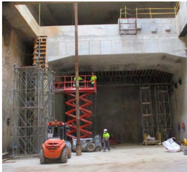
Avance de carro de ejecución de cubierta de dovela en paso inferior L1 metro
