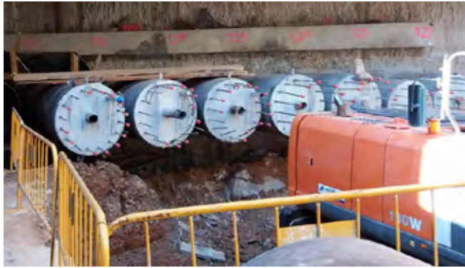
Plataforma sostenimiento túnel ferroviario con Tubos D1100 hincados
