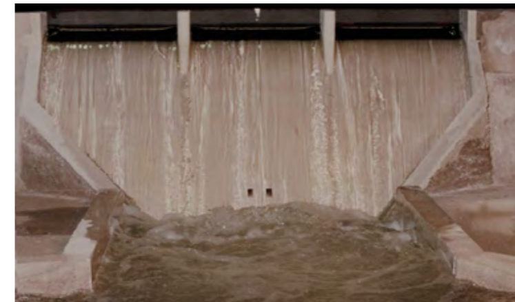
Presa de Moratalla: canal de descarga con cajeros convergentes. Muy apropiado para cauces estrechos con caudales punta elevados.
