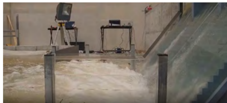
Presa de Casupá. Aliviadero escalonado en presa de hormigón compactado con rodillo y cuenco de amortiguación
