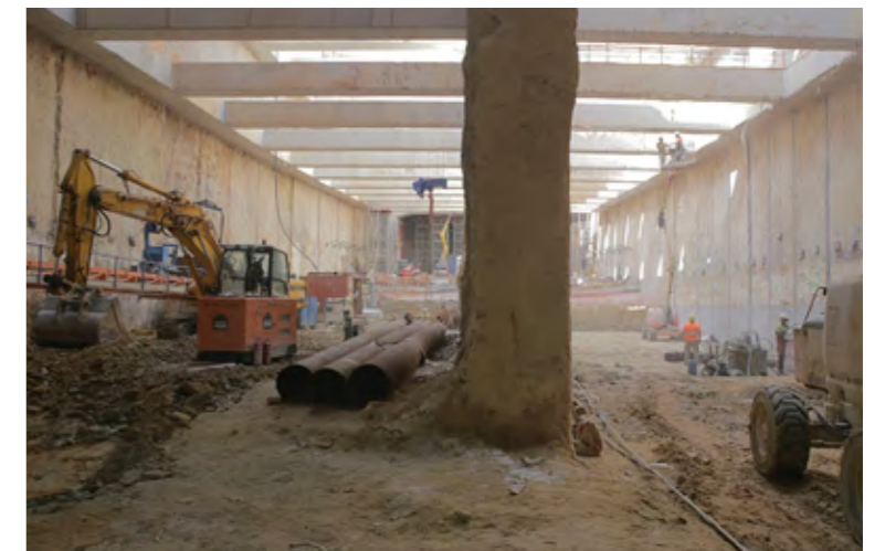
Túnel entre pantallas
