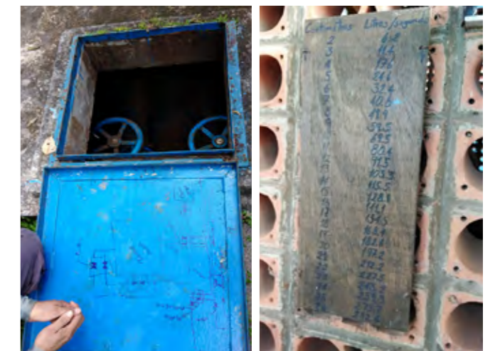
Esquema hidráulico en tapa de arqueta | Curva de gastos de caudal producido
