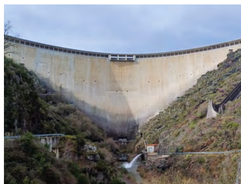
Las Portas Dam. Orense, Spain
