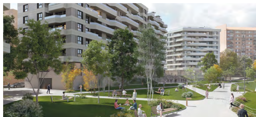
Urbanisation of Pozokoetxe. Basauri, Spain
