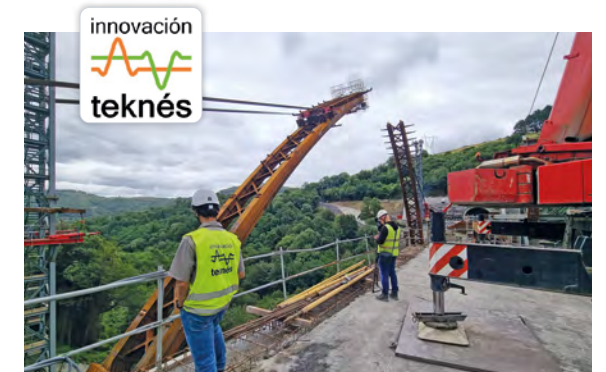
Monitorización en el abatimiento del viaducto del Bolintxu
