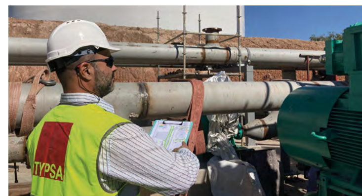
Obras de ampliación de la terminal de graneles del puerto de Nueva Palmira, Uruguay
