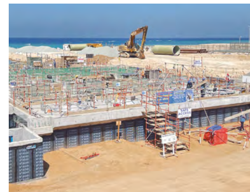
Obras de la planta desaladora de Shuaibah3, Arabia Saudí
