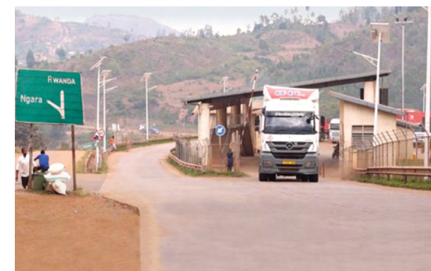
Obras de rehabilitación de la carretera de Lusahunga a Rusumo, Tanzania
