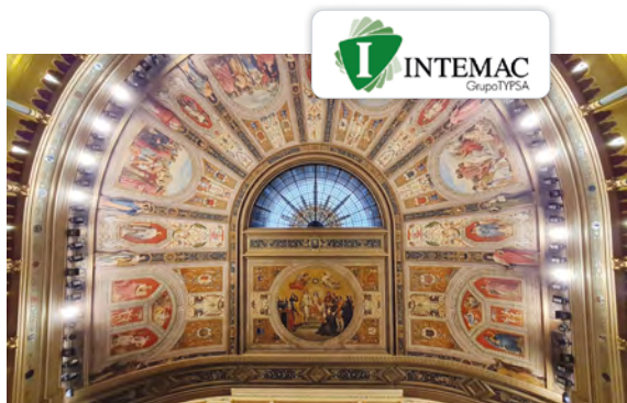
Bóveda del Palacio de Las Cortes, en Madrid
