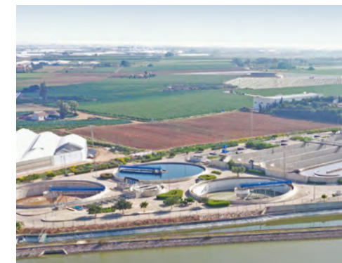
Planta depuradora de Los Alcázares. Murcia, España
