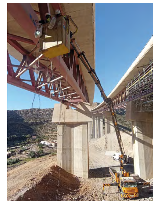
Obras de refuerzo en el viaducto del Caballar, Almería, España
