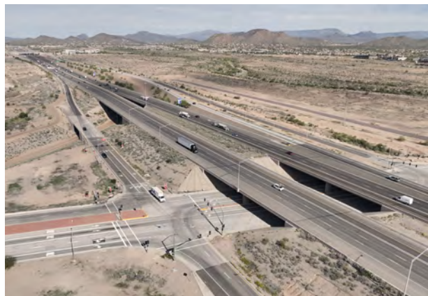
Mejora de la carretera SR303L, Phoenix, Arizona
