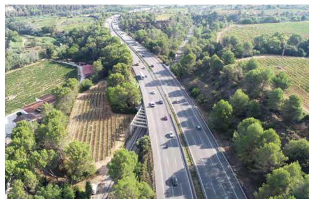
Ampliación de la autopista AP-7, Barcelona
