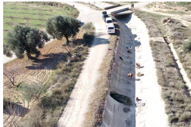
Conservación y mantenimiento del canal de Calanda-Alcañiz, Zaragoza, España
